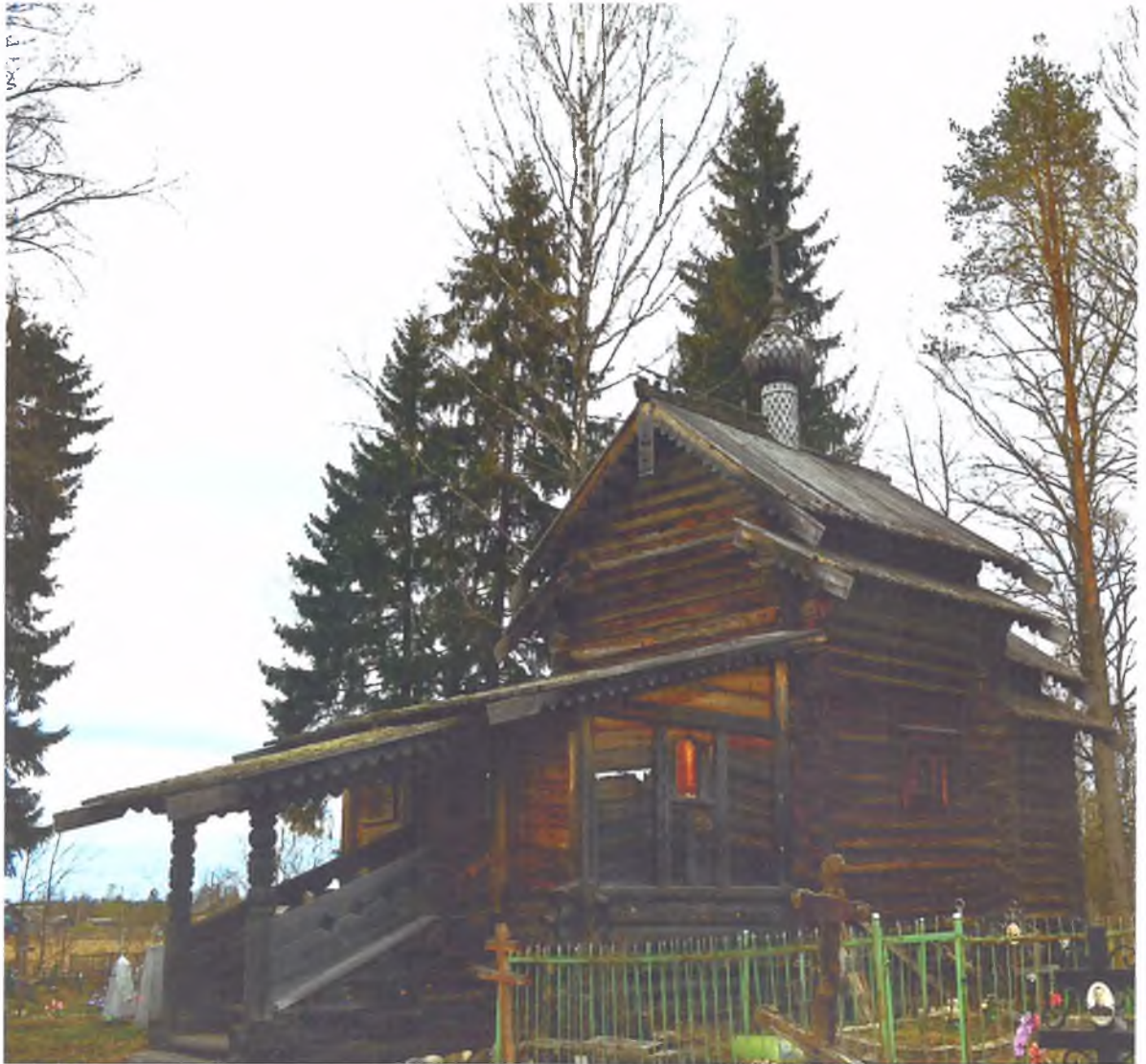
Фото 1. Ленинградская область, Бокситогорский район, д. Лиственка, дом 1а. Общий вид с юго-запада.
