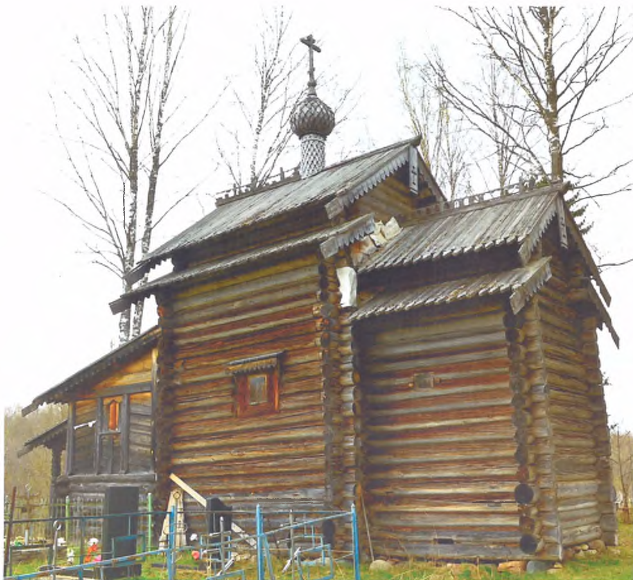
Фото 2. Ленинградская область, Бокситогорский район, д. Лиственка, дом 1а. Общий вид с юго-востока.
