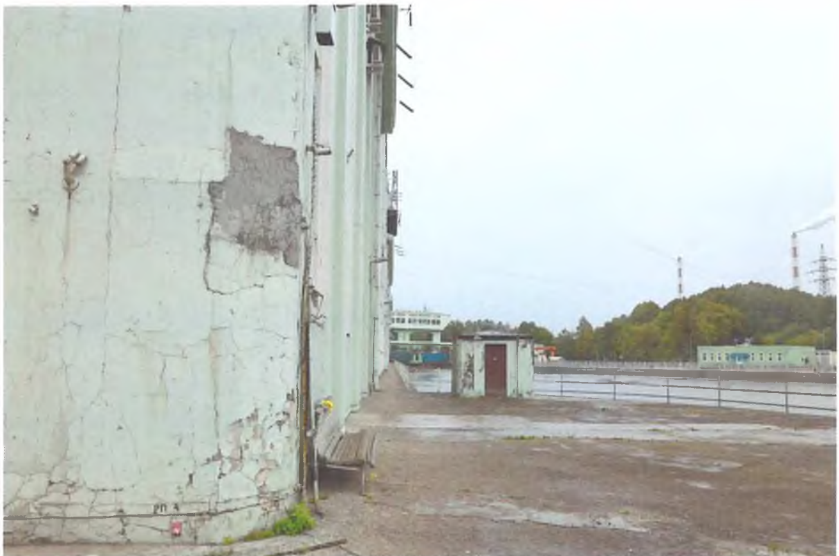
Фото 15. Ленинградская область, г. Волхов, Волховская ГЭС. Площадка у юго-восточного фасада. Вид с юга.
