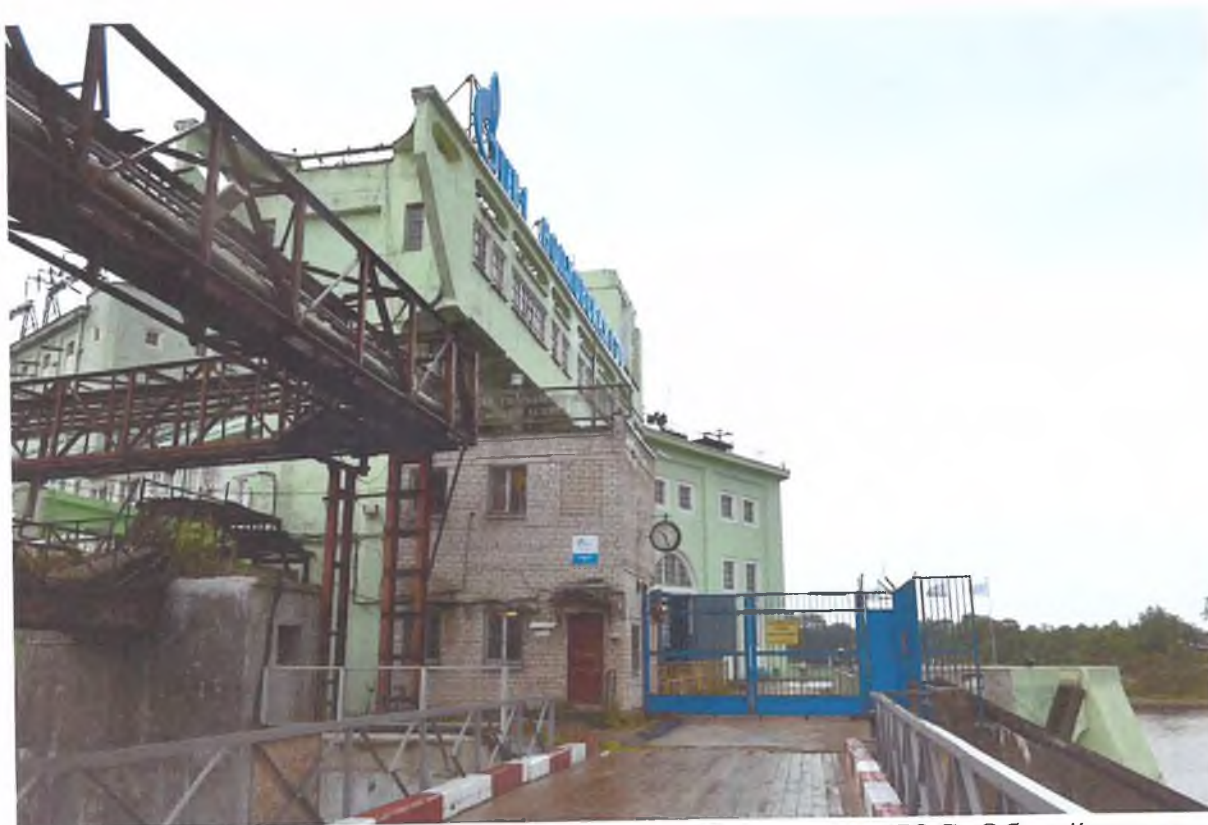
Фото 5. Ленинградская область, г. Волхов, Волховская ГЭС. Общий вид на проходную к Зданию ГЭС.
