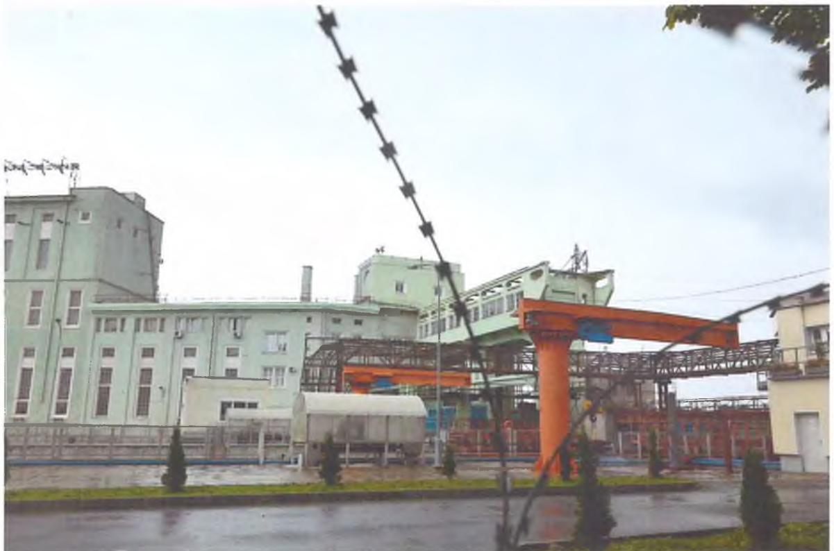
Фото 4. Ленинградская область, г. Волхов, Волховская ГЭС. Общий вид с юго-запада на надземную часть камеры шлюза.
