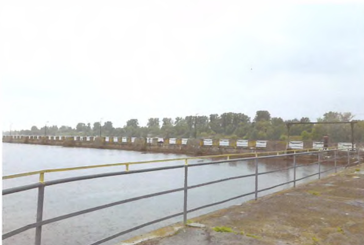
Фото 17. Ленинградская область, г. Волхов, Волховская ГЭС. Ледозащитная стенка. Вид с северо-востока.
