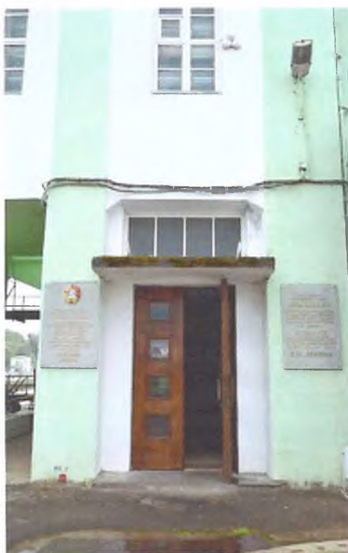
Фото 9. Ленинградская область, г. Волхов, Волховская ГЭС. Фрагмент северо-восточного фасада. Входная группа.
