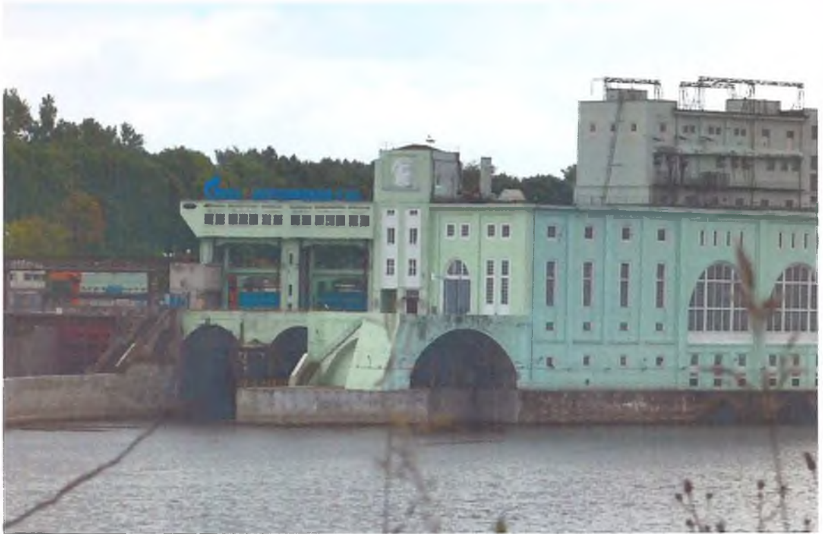
Фото 7. Ленинградская область, г. Волхов, Волховская ГЭС. Северо-восточный фасад. Вид с востока.
