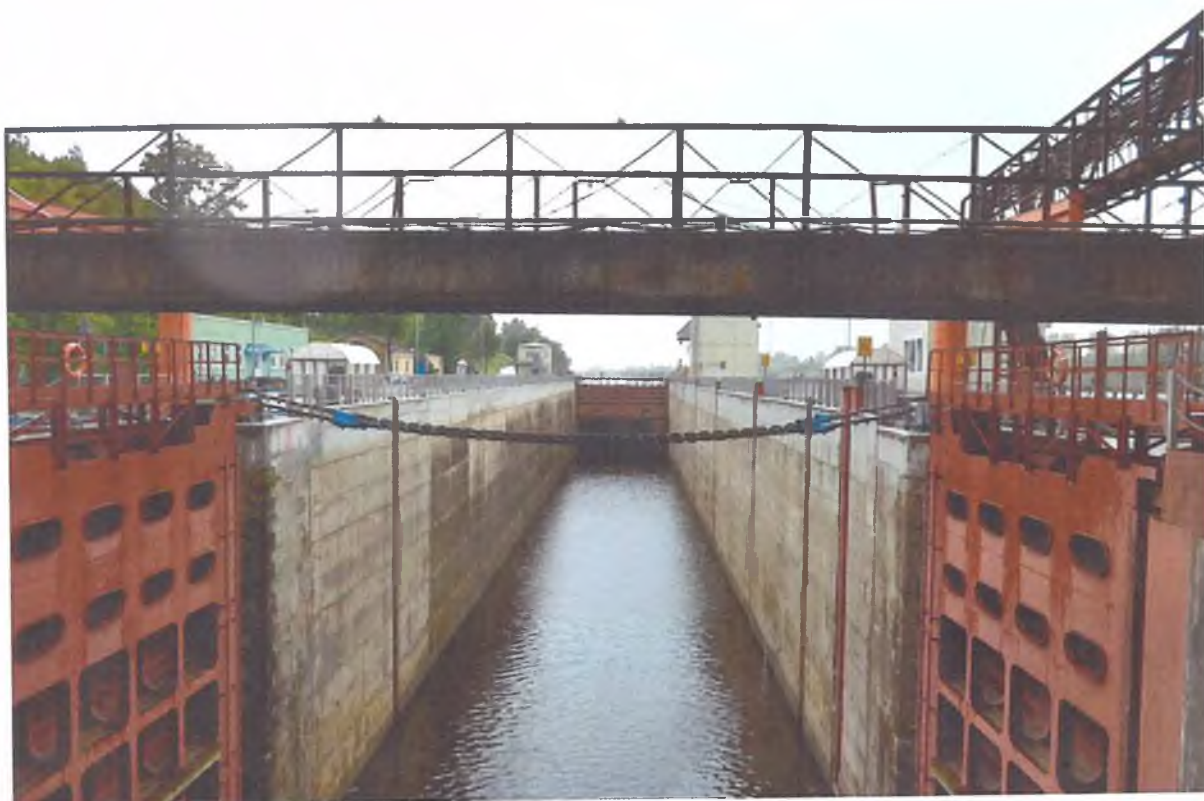
Фото 6. Ленинградская область, г. Волхов, Волховская ГЭС. Вид с севера на камеру шлюза.
