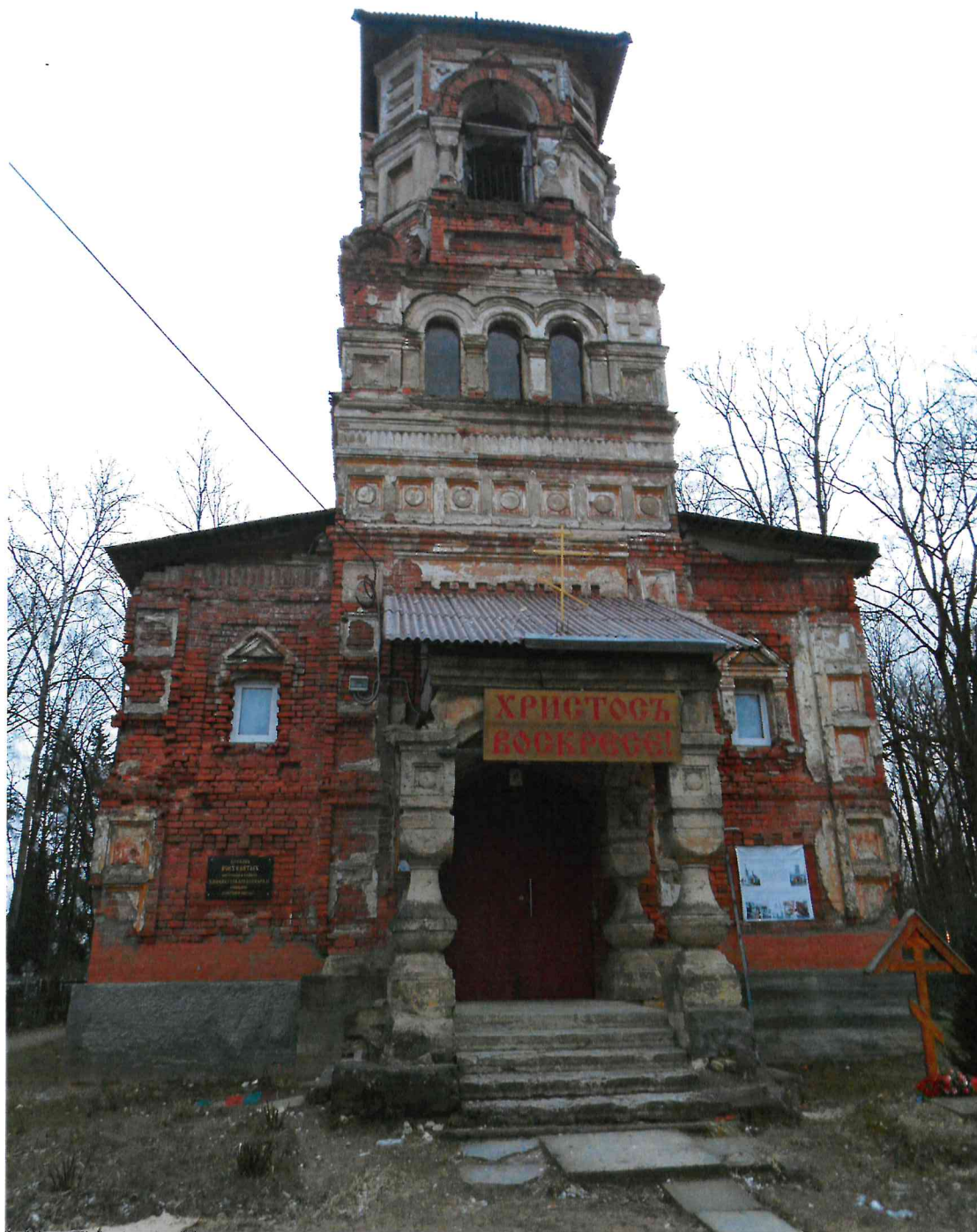
Общий вид, западный фасад. Дата съёмки 05.02.2020 г.
