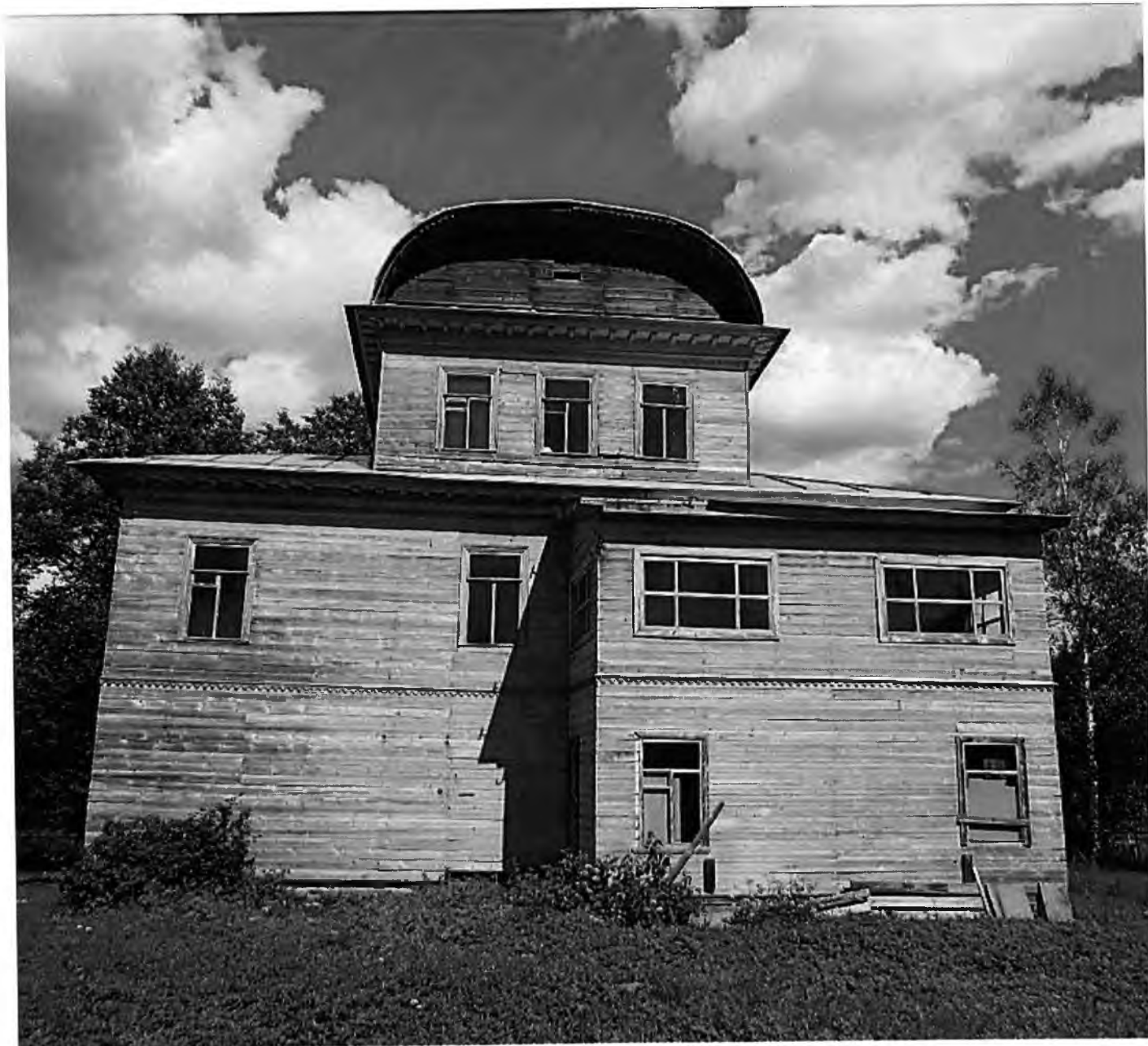
Фотография № 3. Западный фасад.
