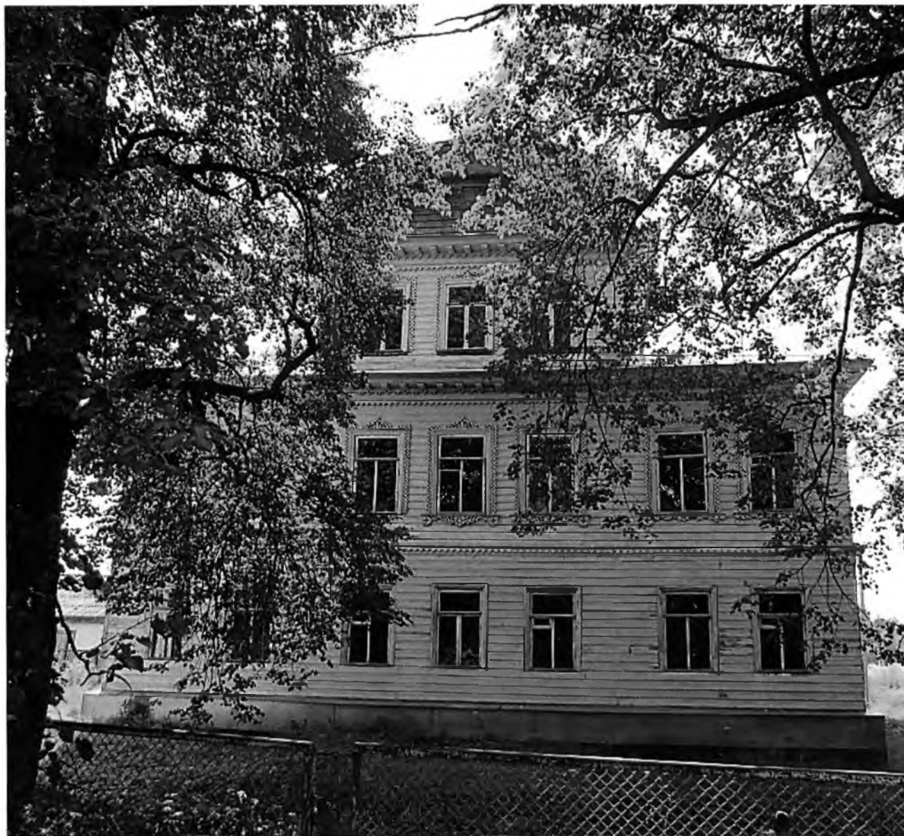
Фотография № 1. Восточный фасад.
