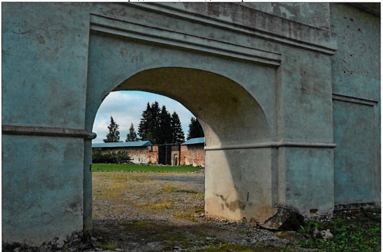
Фото 4. Ленинградская область, Волховский район, пос.Зеленец д.27а. Северные ворота. Общий вид с северо-востока.
