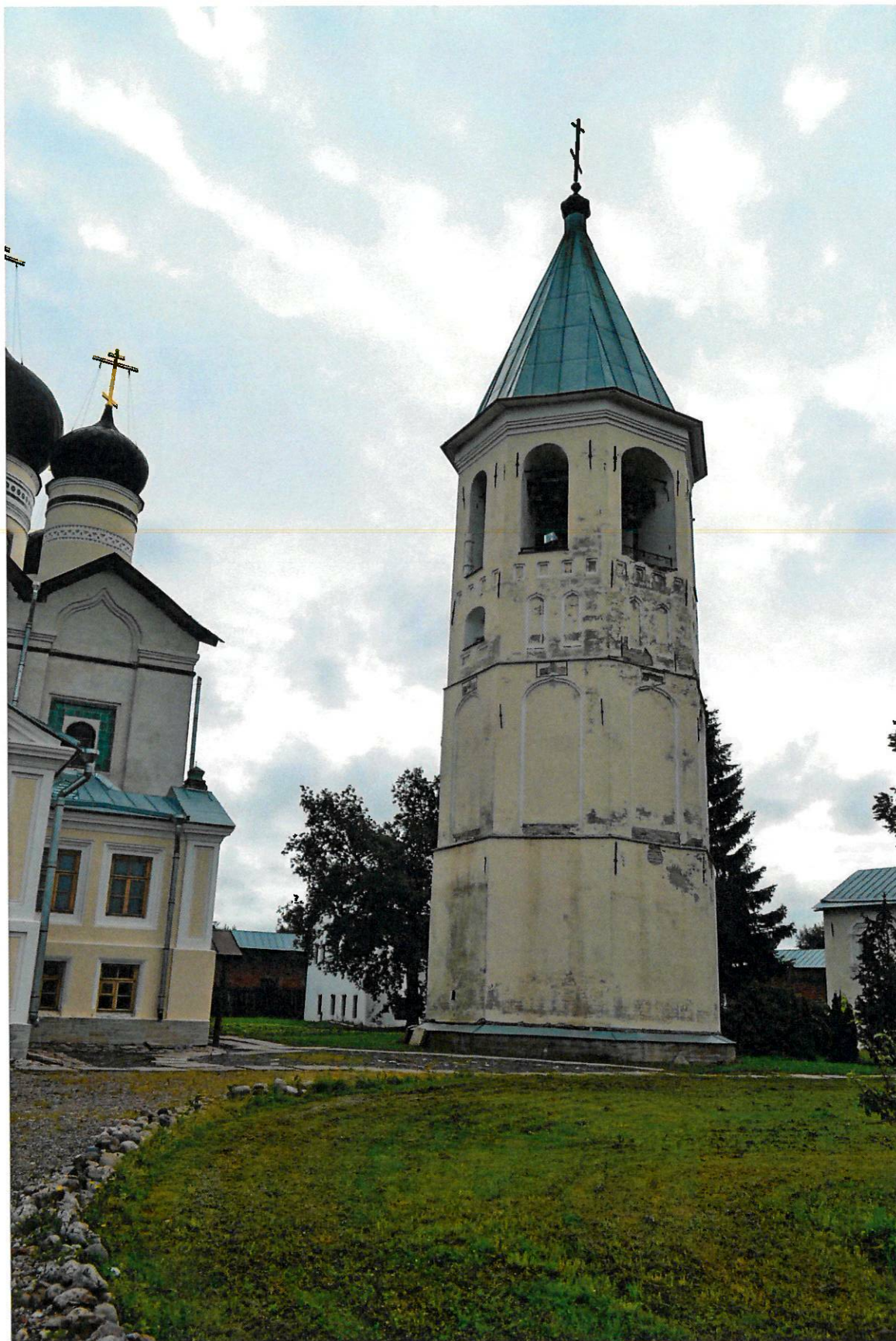
Фото 14. Ленинградская область, Волховский район, пос.Зеленец д.27а. Колокольня. Вид с северо-запада.
