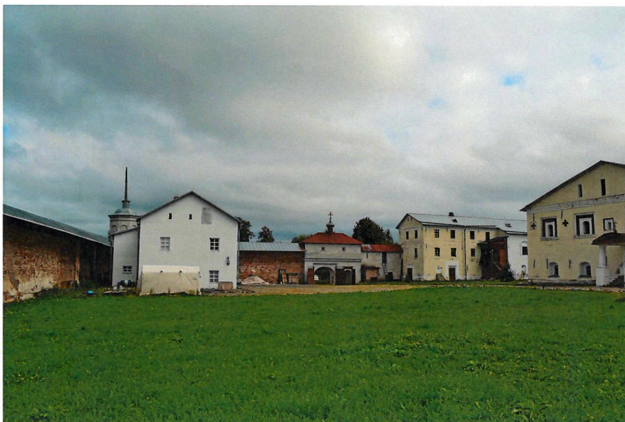
Фото 7. Ленинградская область, Волховский район, пос.Зеленец д.27а. Общий вид с юго-запада.
