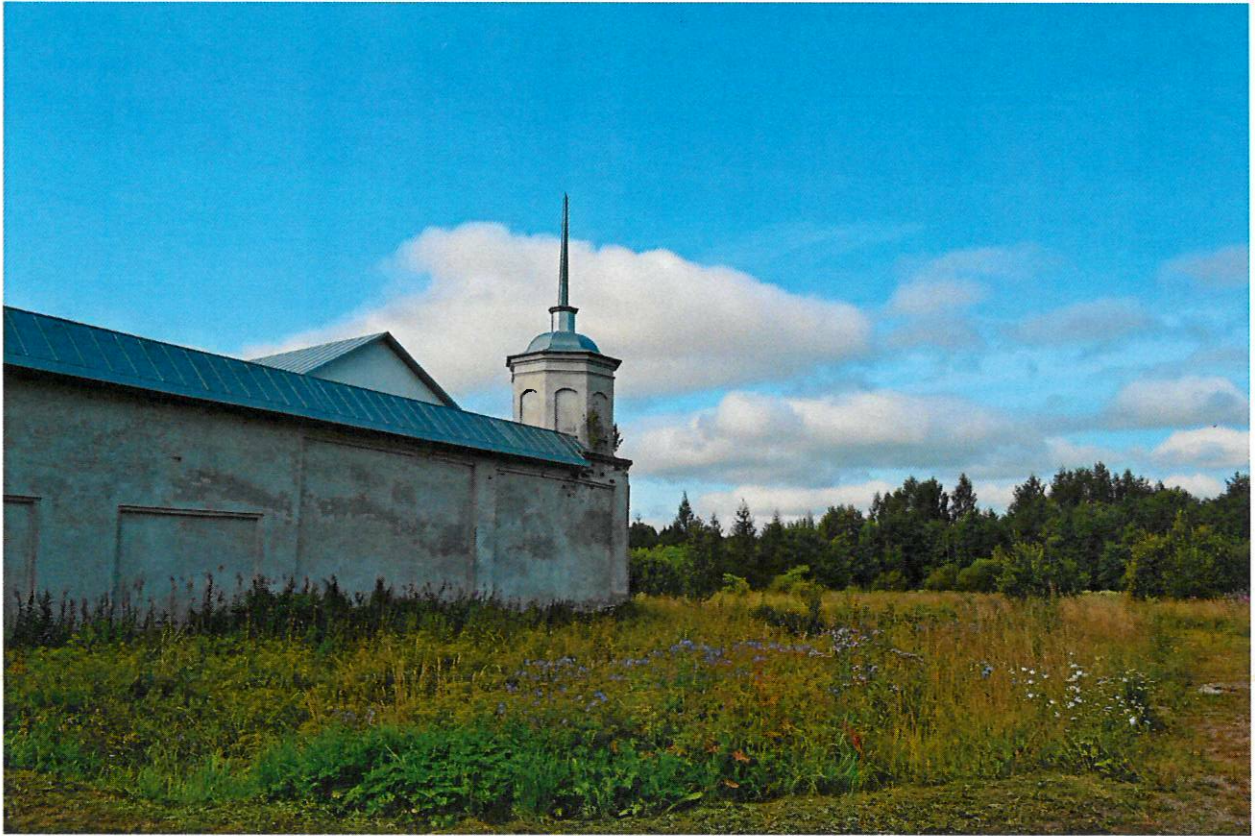
Фото 3. Ленинградская область, Волховский район, пос.Зеленец д.27а. северо-западная башня ограды. Общий вид с северо-востока.
