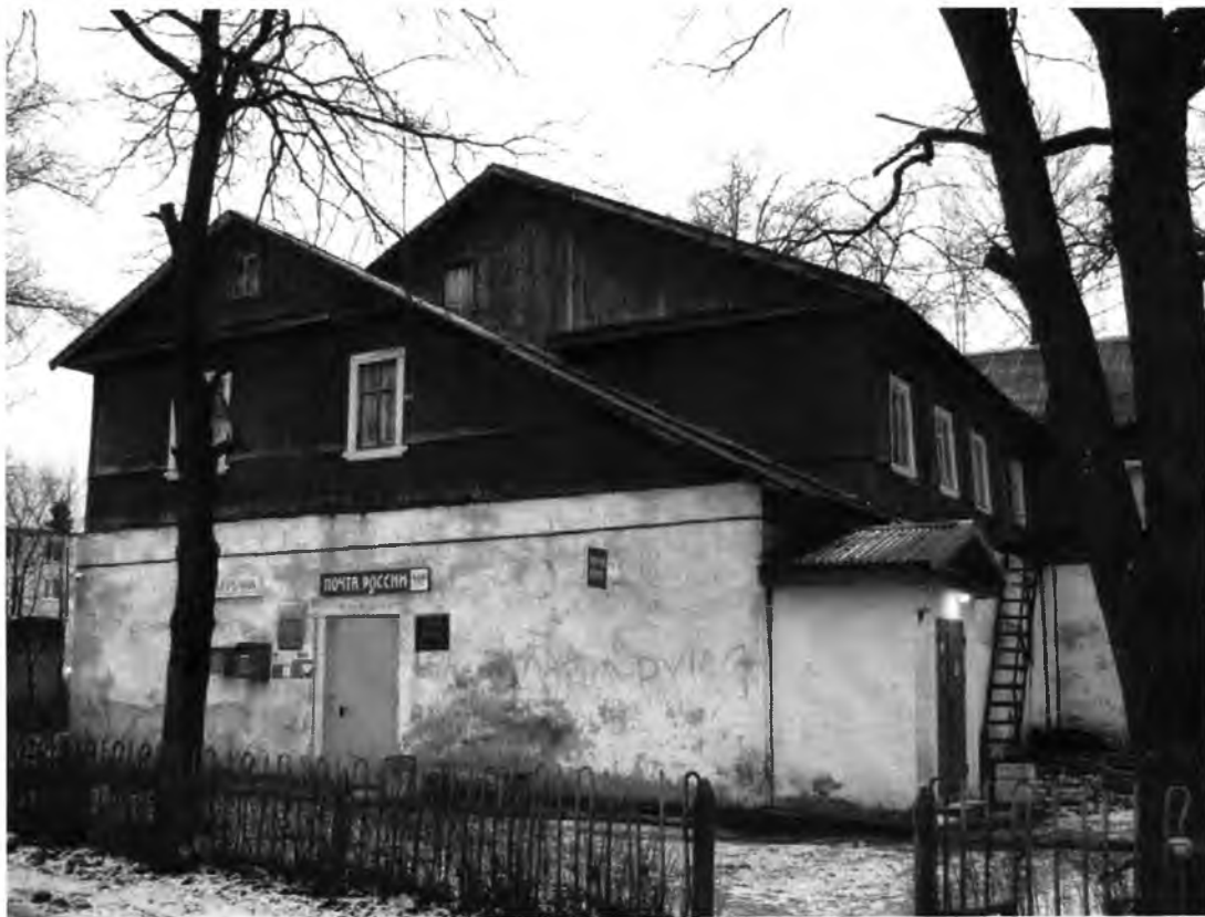
Усадебно-парковый комплекс Н.И.Корфа. Западный флигель (лит. А) Западный фасад.
