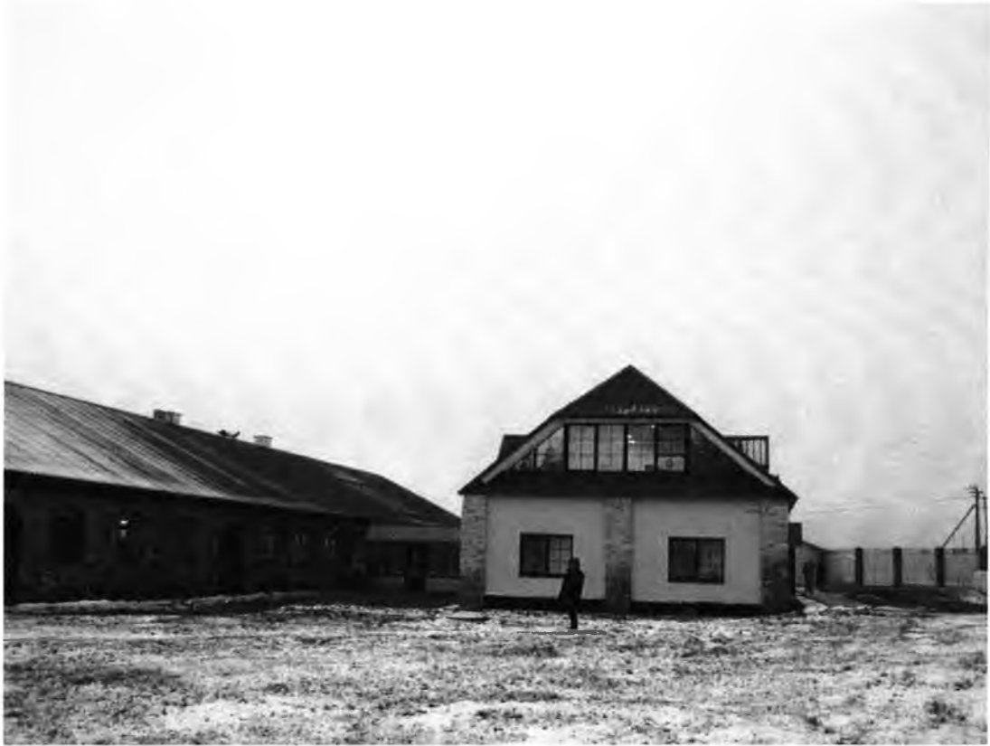
Усадебно-парковый комплекс Н.И.Корфа. . Конюшни (лит. Е и Д). Вид с востока.
