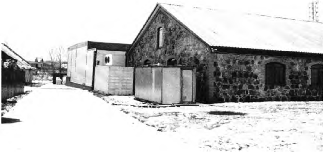
Усадебно-парковый комплекс Н.И.Корфа. Общий вид на территорию с юга. Справа – лит. Е, восточный фасад.
