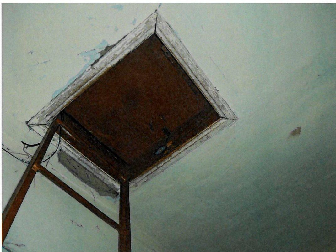
Фото 6. Вход на чердак
