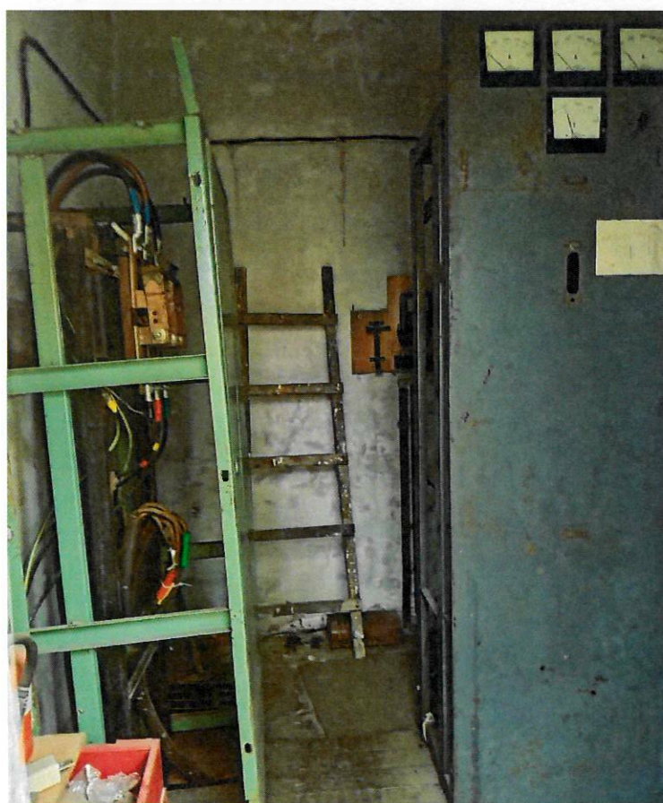
Фото 7. Помещение 1-го этажа
