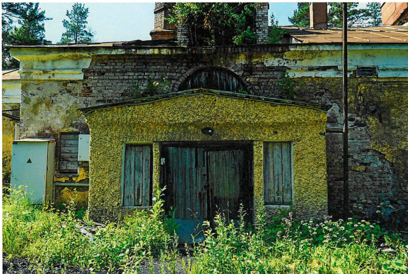
Фото 5. Крыльцо на северо-восточном фасаде. Вид с северо-востока
