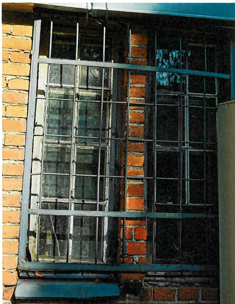
Фото 4. Оконный проем южного фасада
