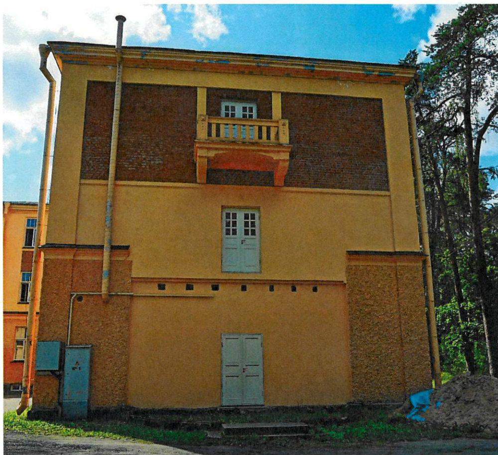
Фото 9. Торцевой северо-восточный фасад. Вид с северо-востока
