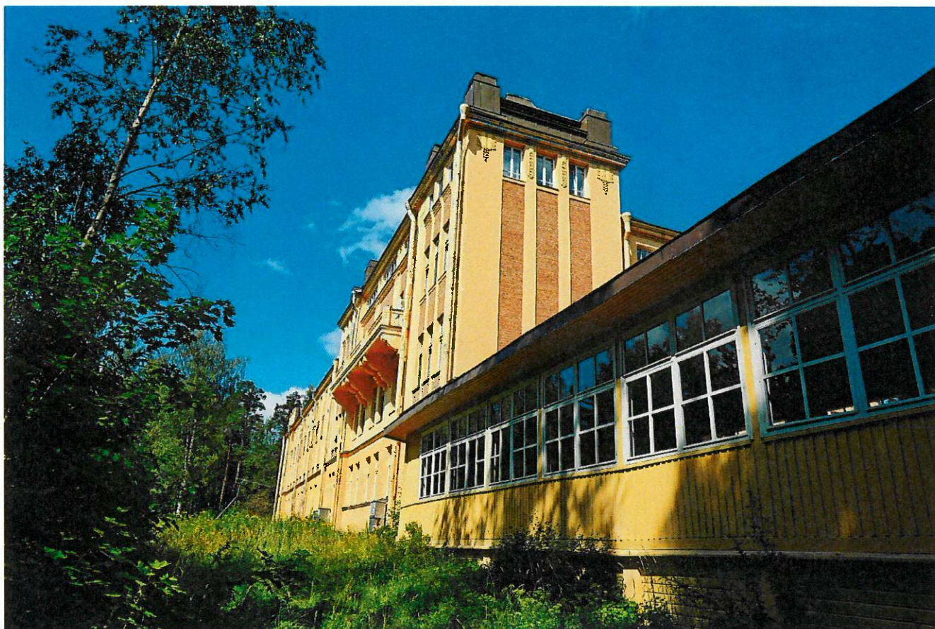
Фото 13. Правая часть юго-западного фасада. Вид с востока
