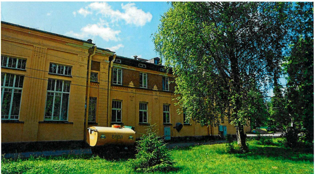
Фото 4. Северо-восточный фасад. Вид с северо-востока
