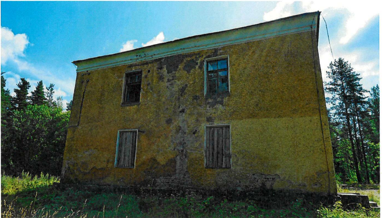
Фото 3. Северо-западный фасад. Вид с северо-запада
