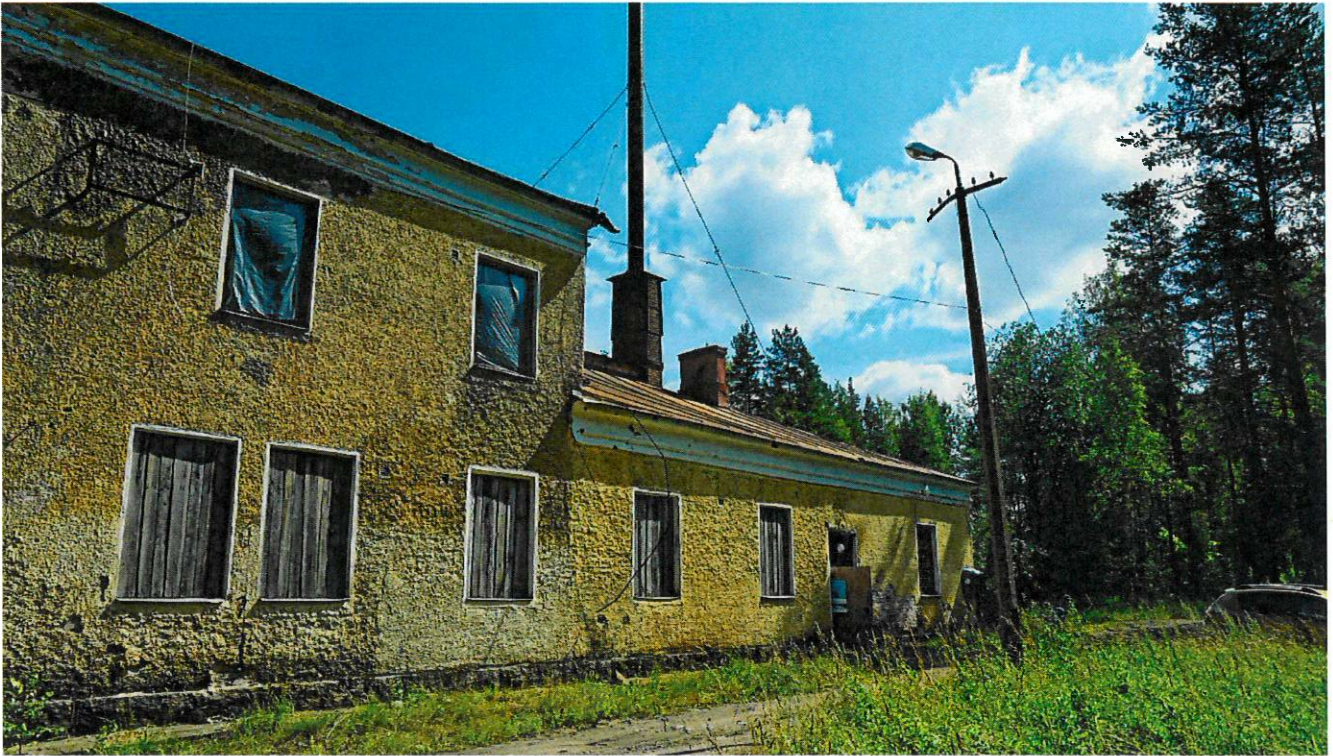
Фото 1. Юго-западный фасад, правая часть. Вид с запада
