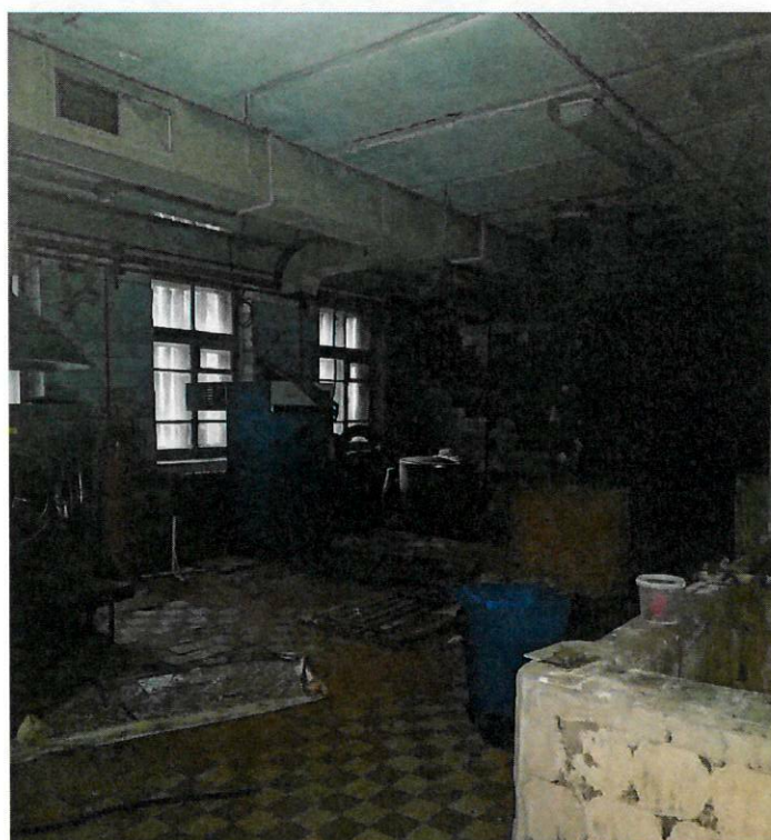
Фото 8. Помещение 1-го этажа
