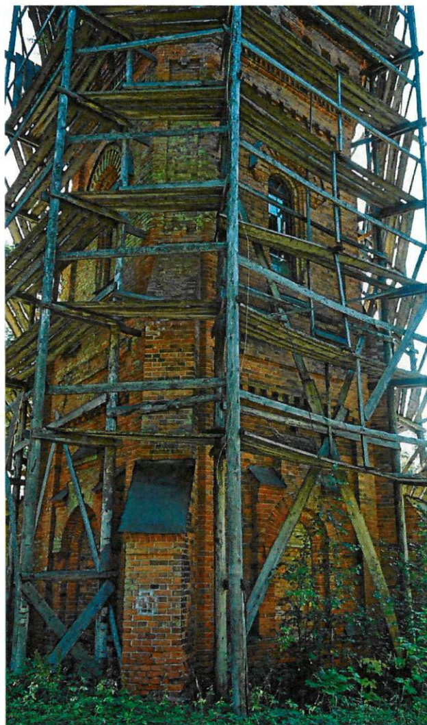
Фото 2. Нижняя часть башни вид с северо-запада
