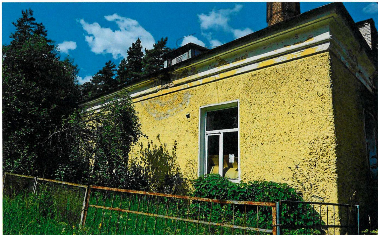
Фото 6. Юго-восточный фасад. Вид с юго-востока
