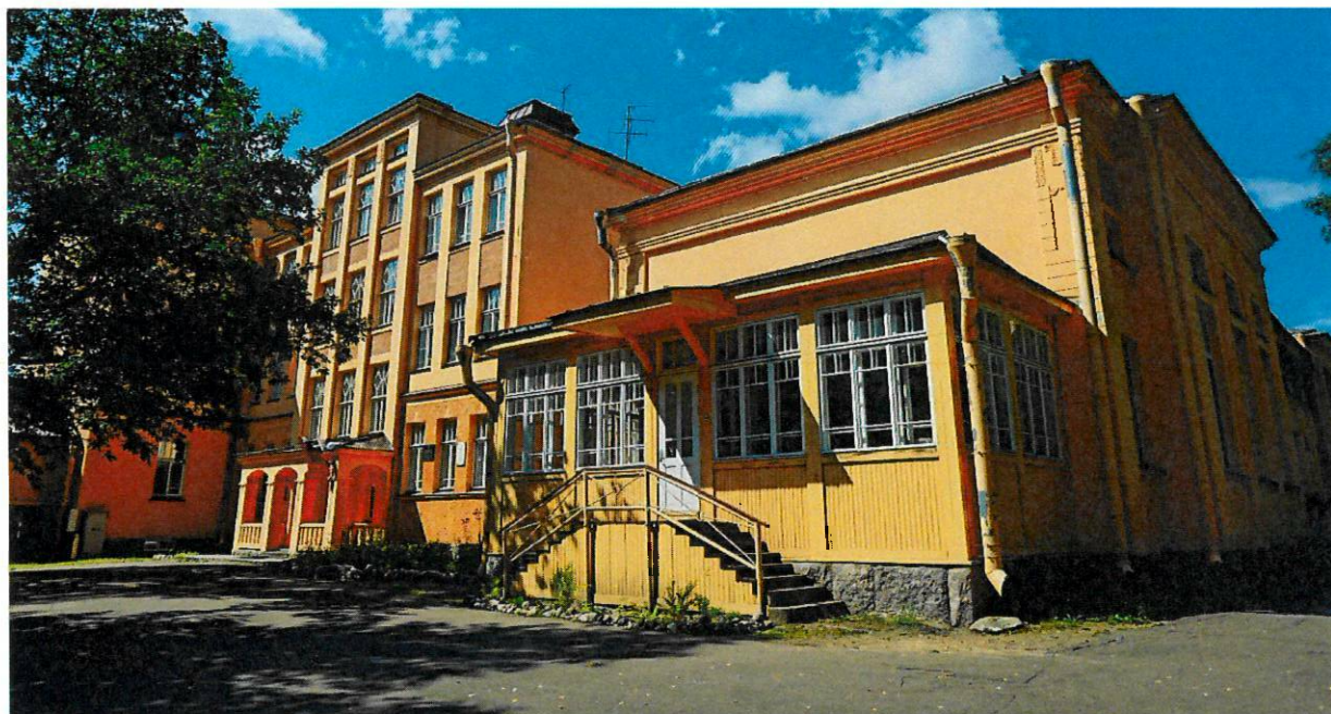
Фото 1. Общий вид на здание санатория с востока
