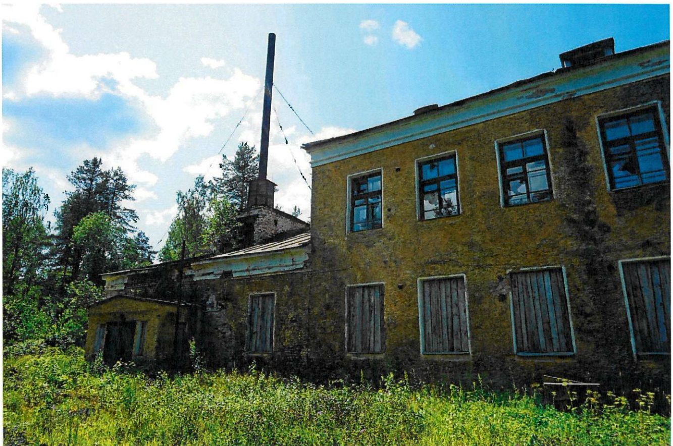
Фото 4. Северо-восточный фасад. Вид с северо-востока
