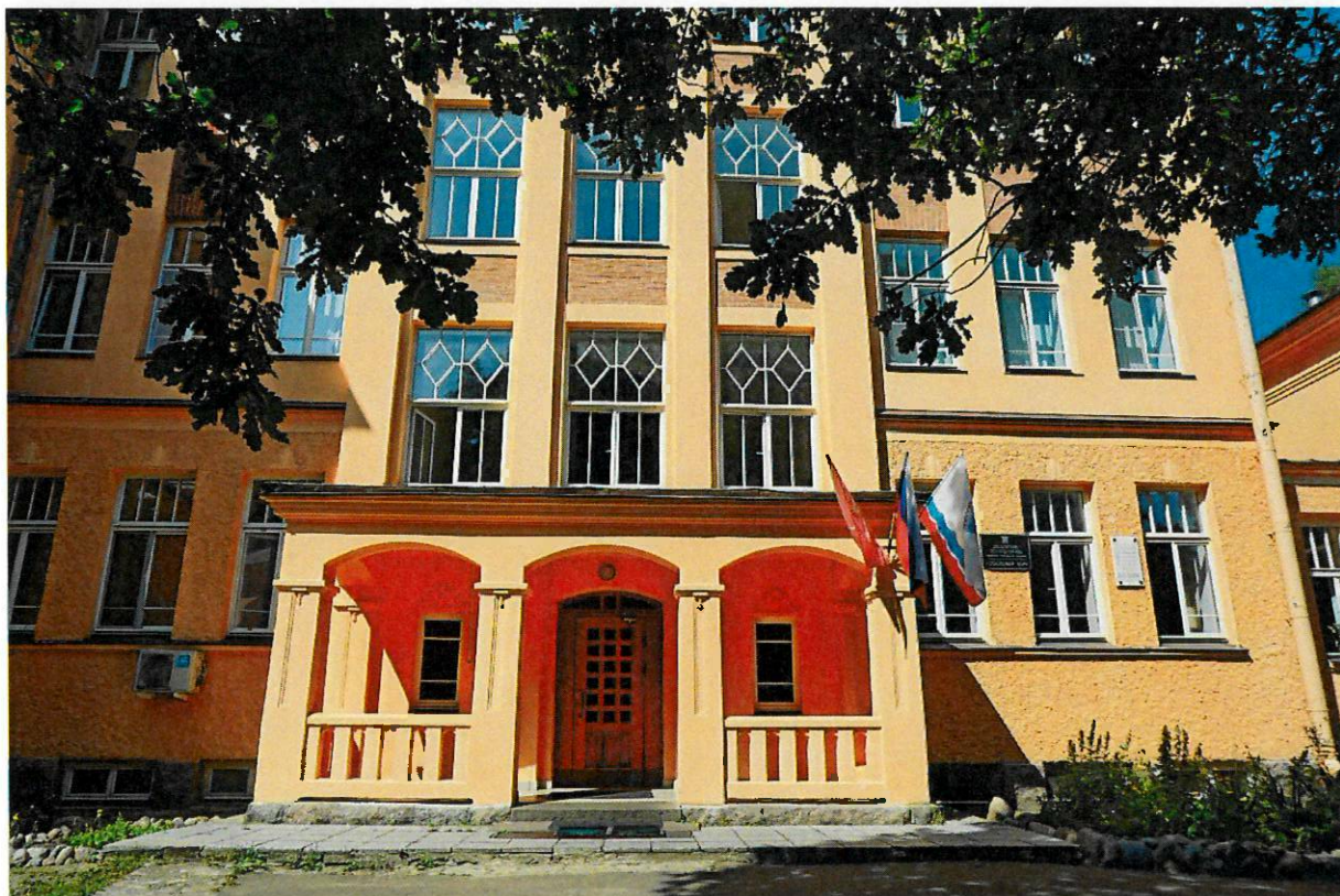
Фото 2. Входная группа. Главный юго-восточный фасад. Вид с юго-востока
