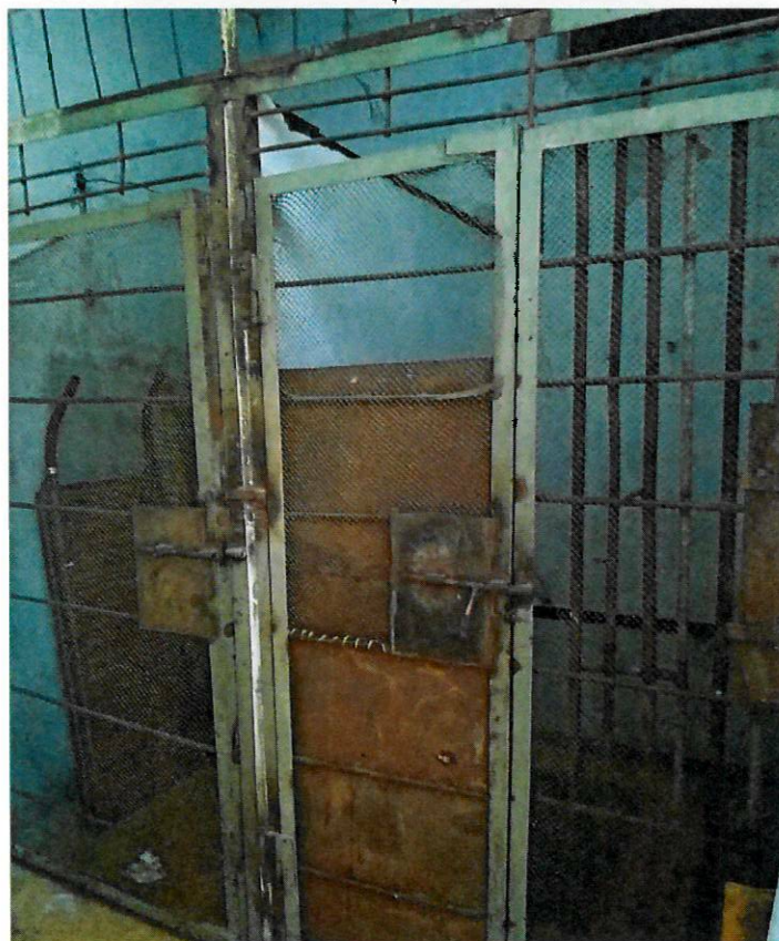
Фото 9. Помещение 1-го этажа
