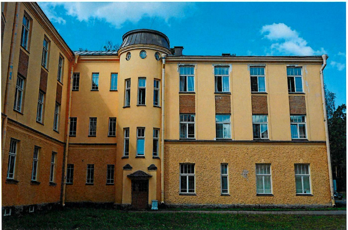
Фото 8. Дворовый юго-восточный фасад. Вид с юго-востока
