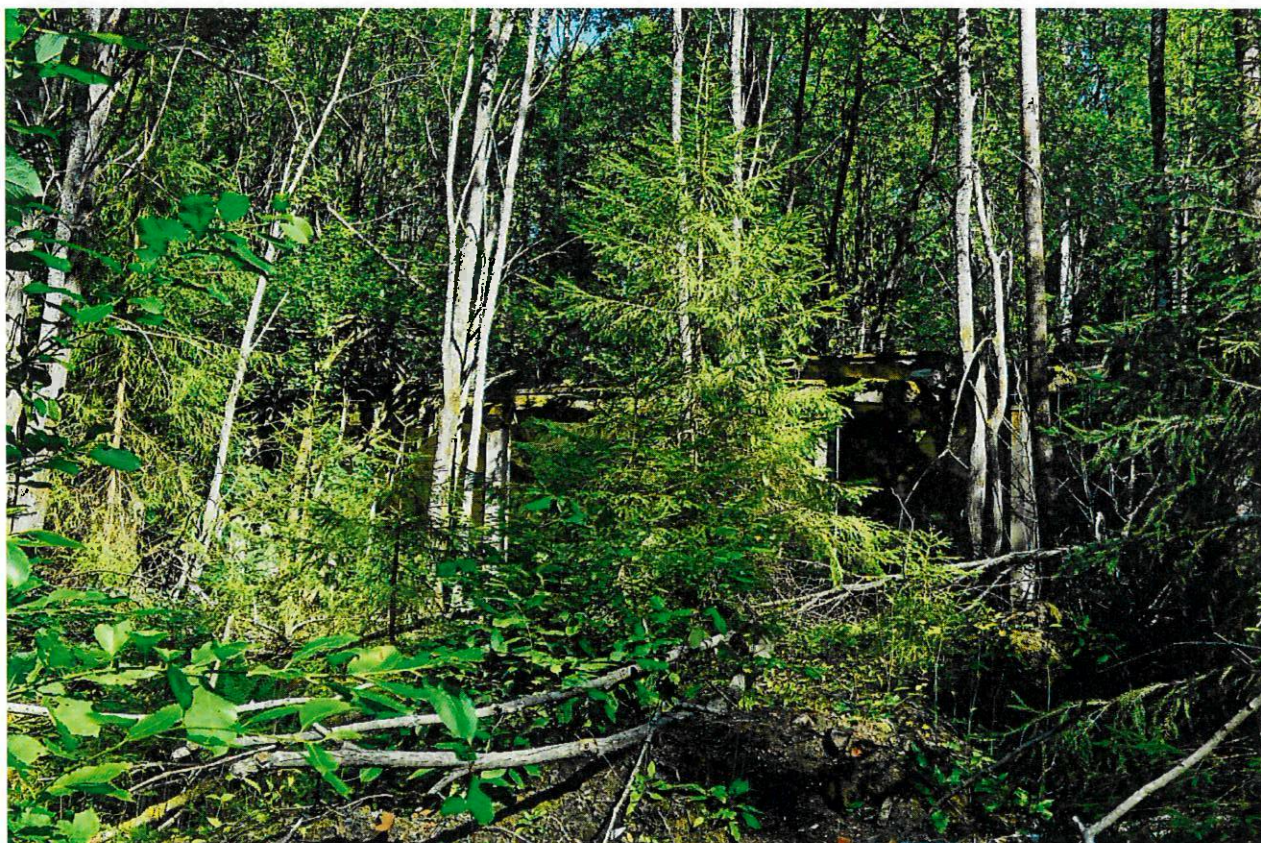
Фото 1. Общий вид с юго-запада
