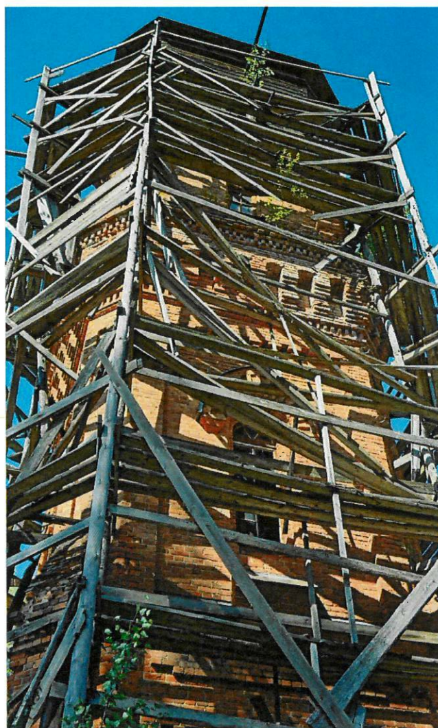
Фото 3. Верхняя часть башни. Вид с юго-востока
