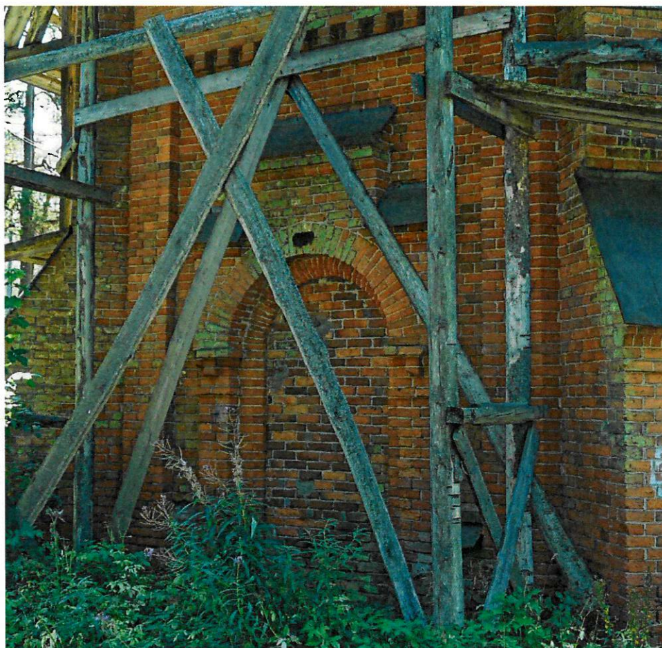
Фото 4. Заложенный дверной проем
