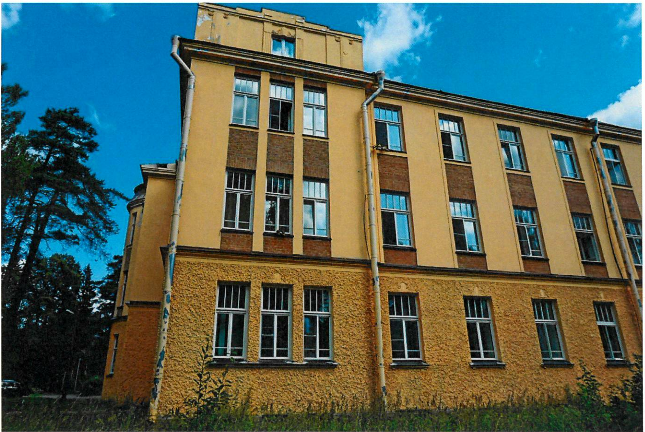
Фото 11. Левая часть юго-западного фасада. Вид с юго-запада
