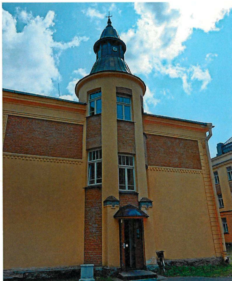
Фото 5. Торцевой северо-западный фасад. Вид с северо-запада
