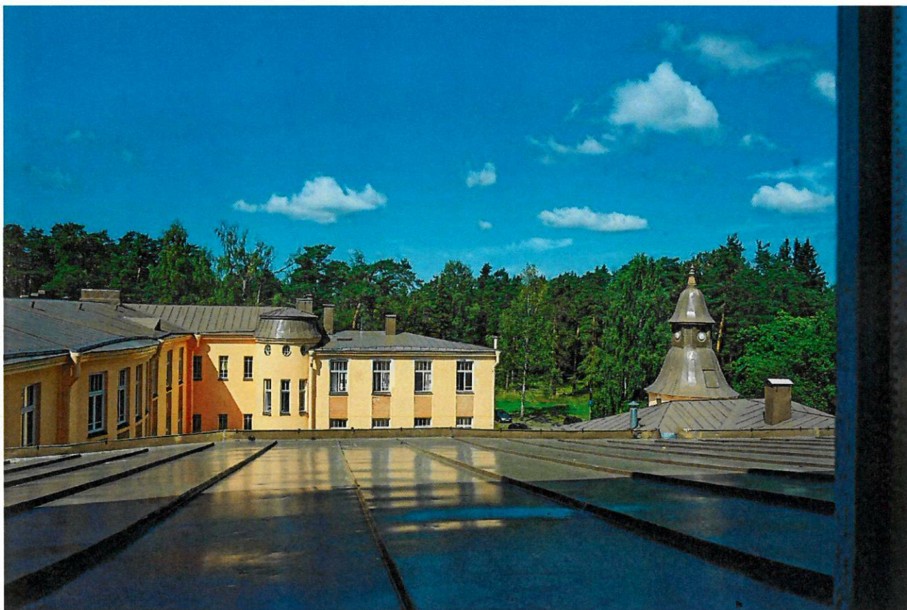
Фото 25. Вид на крышу
