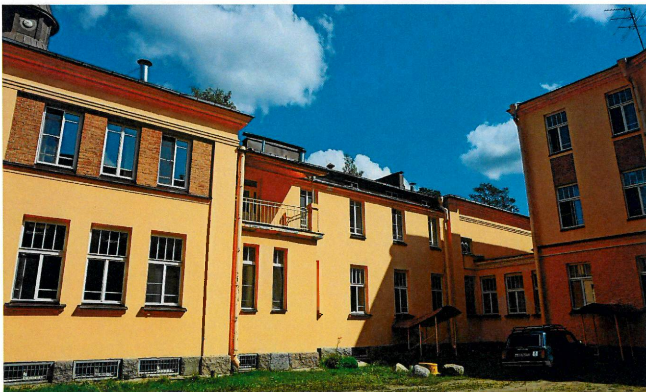
Фото 6. Дворовый юго-западный фасад. Вид с запада
