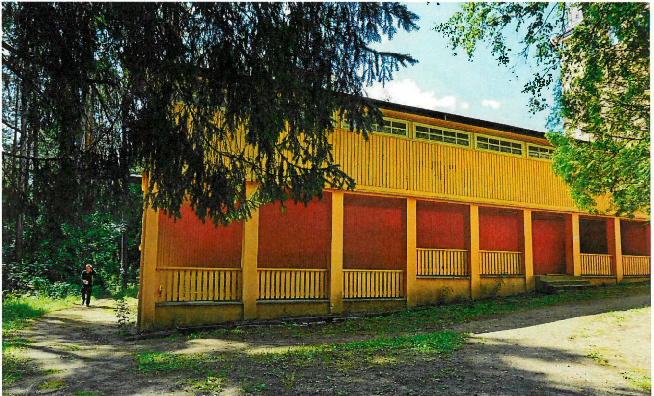
Фото 15. Северо-восточный фасад лодочного флигеля. Вид с северо-востока
