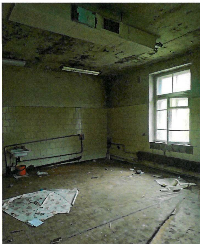
Фото 7. Помещение 1-го этажа
