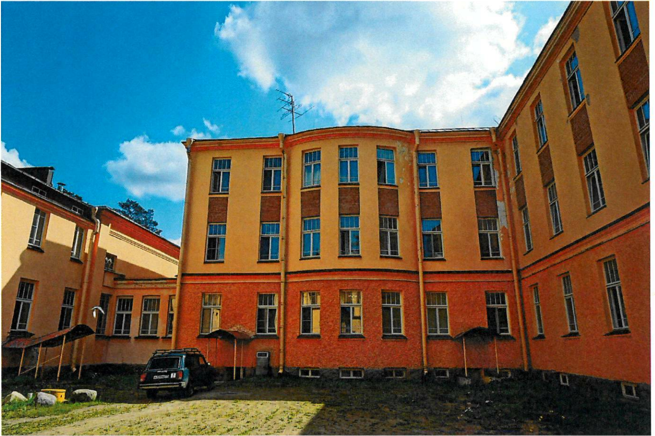
Фото 7. Дворовый северо-западный фасад. Вид с северо-запада
