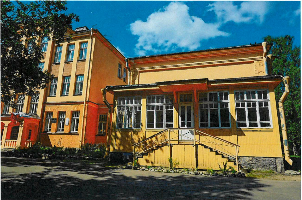
Фото 3. Главный юго-восточный фасад. Деревянное крыльцо в правой части фасада. Вид с юго-востока
