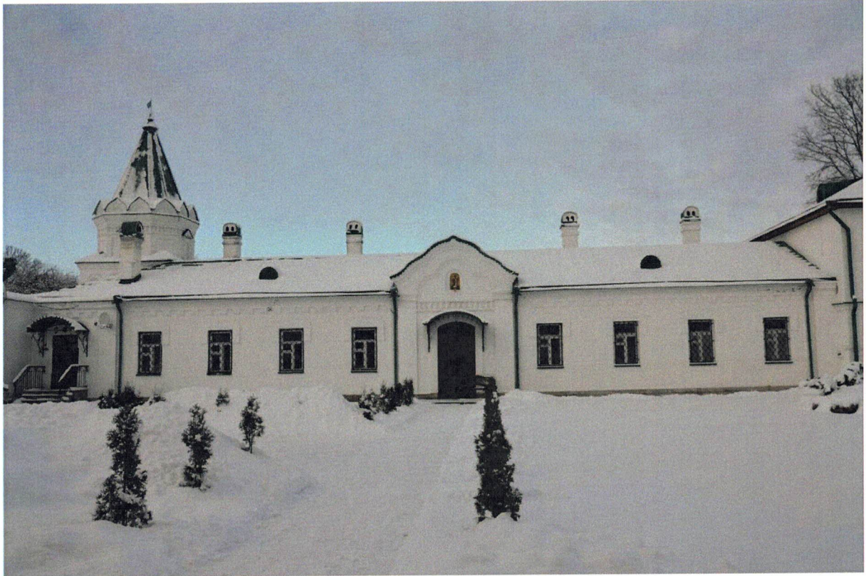
Фото 5. Корпус келейный северо-западный (одноэтажный).
