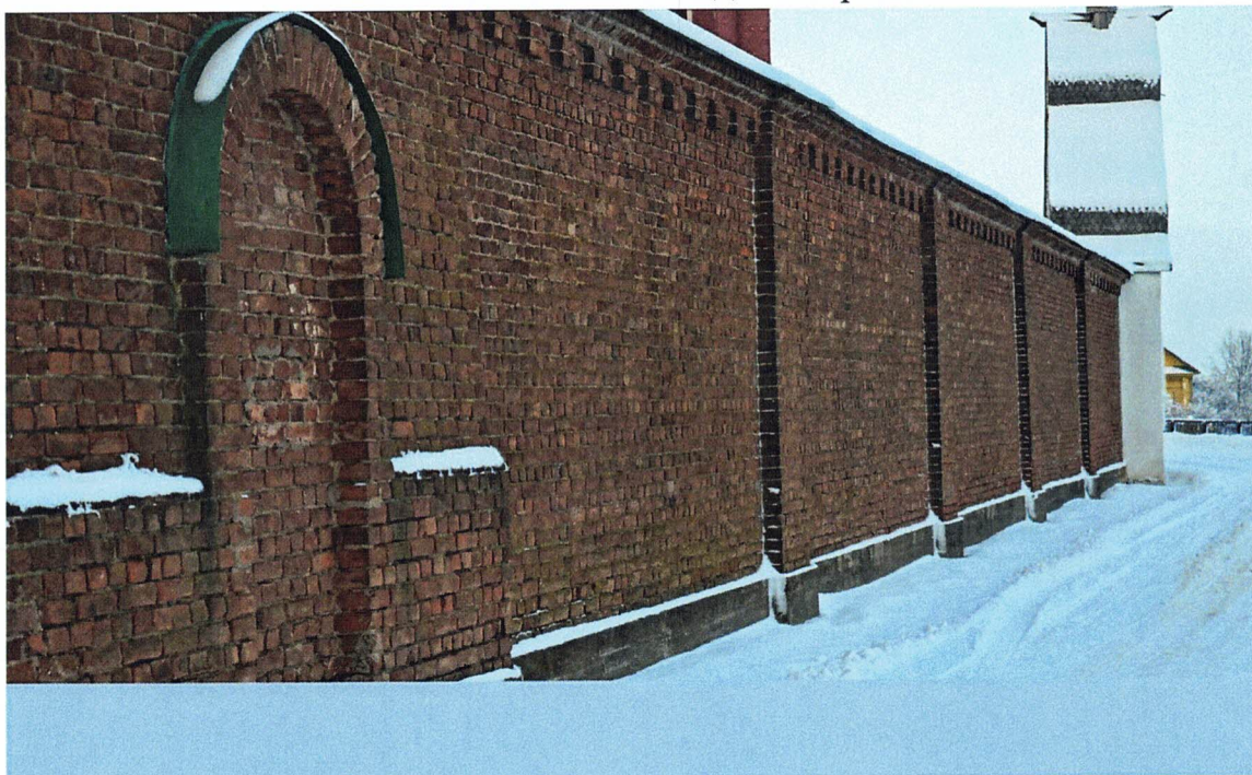
Фото 14. Стены. Восточная ограда.
