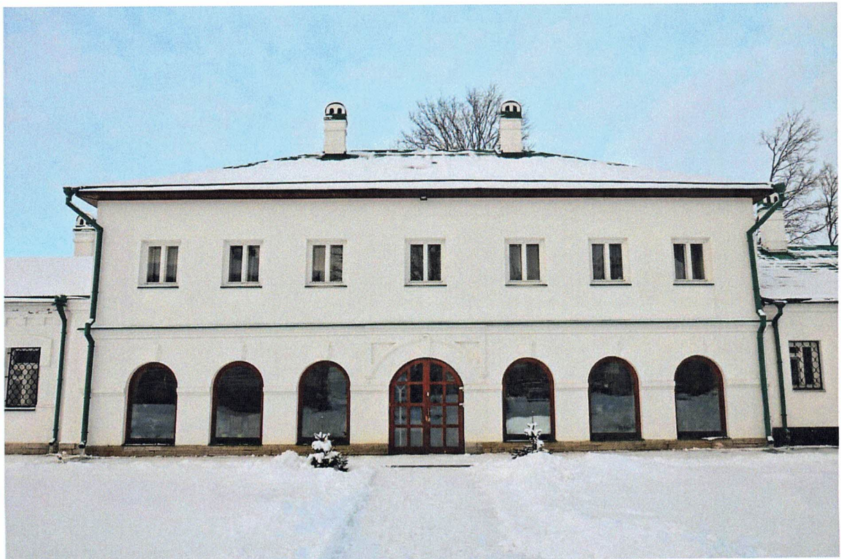
Фото4. Корпус келейный северный центральный (братский).
