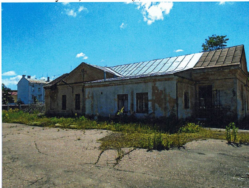
Фото 17. Кухня, столовая (дата съемки 17.06.2020)
