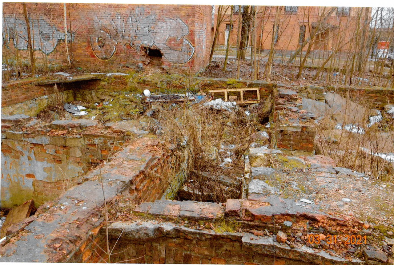
Фото 3. Дом в котором находился в 1919 – 1920 гг. Гатчинский УКОМ РКСМ. Фрагмент фундаментов дома. Разуvalов О.М., 31.03.2021 г.
