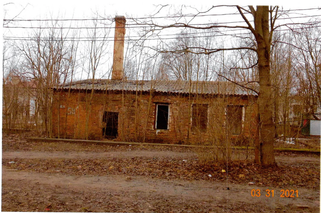
Фото 6. Дом в котором находился в 1919 – 1920 гг. Гатчинский УКОМ РКСМ. Прачечная, вид с юго-востока. Разувалов О.М., 31.03.2021 г.
