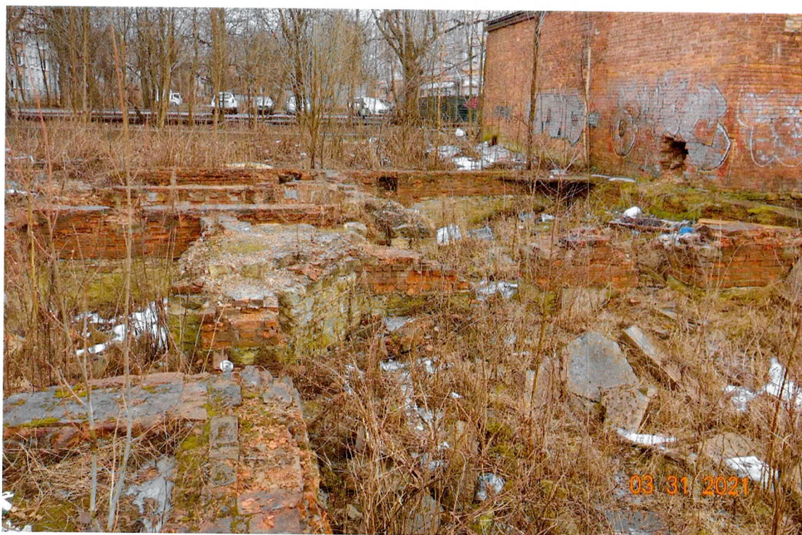
Фото 2. Дом в котором находился в 1919 – 1920 гг. Гатчинский УКОМ РКСМ. Фрагмент фундаментов дома. Разувалов О.М., 31.03.2021 г.
