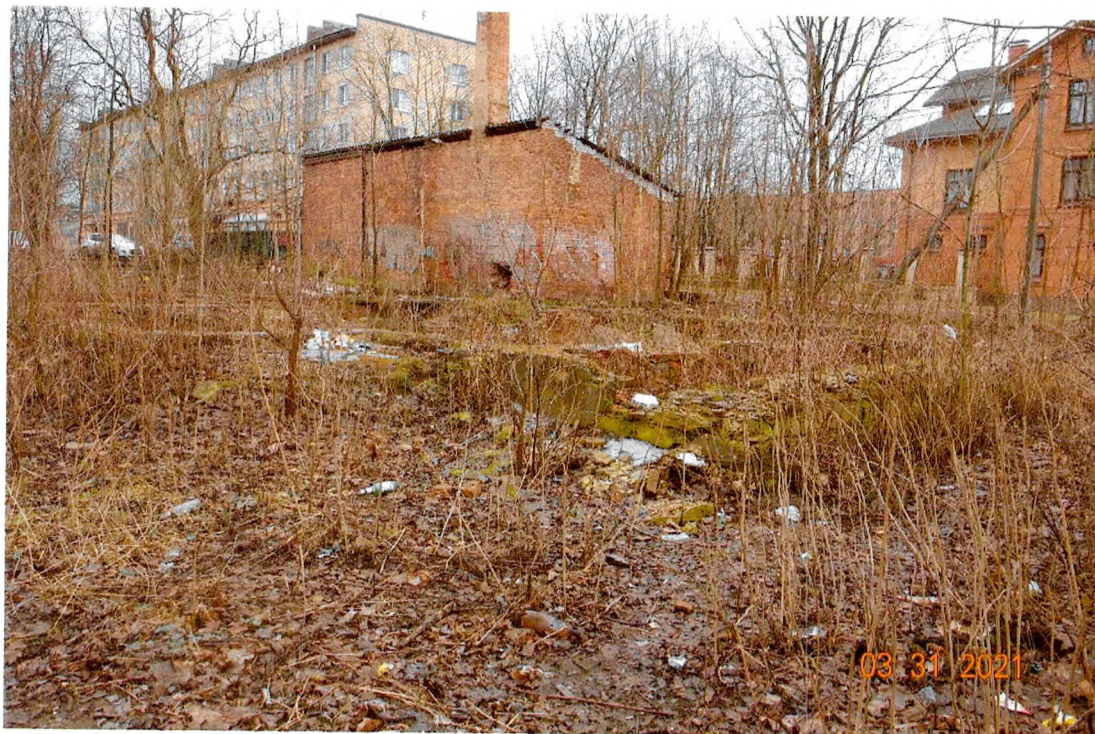
Фото 1. Дом в котором находился в 1919 – 1920 гг. Гатчинский УКОМ РКСМ. Вид с северо-запада. Разувалов О.М., 31.03.2021 г.
