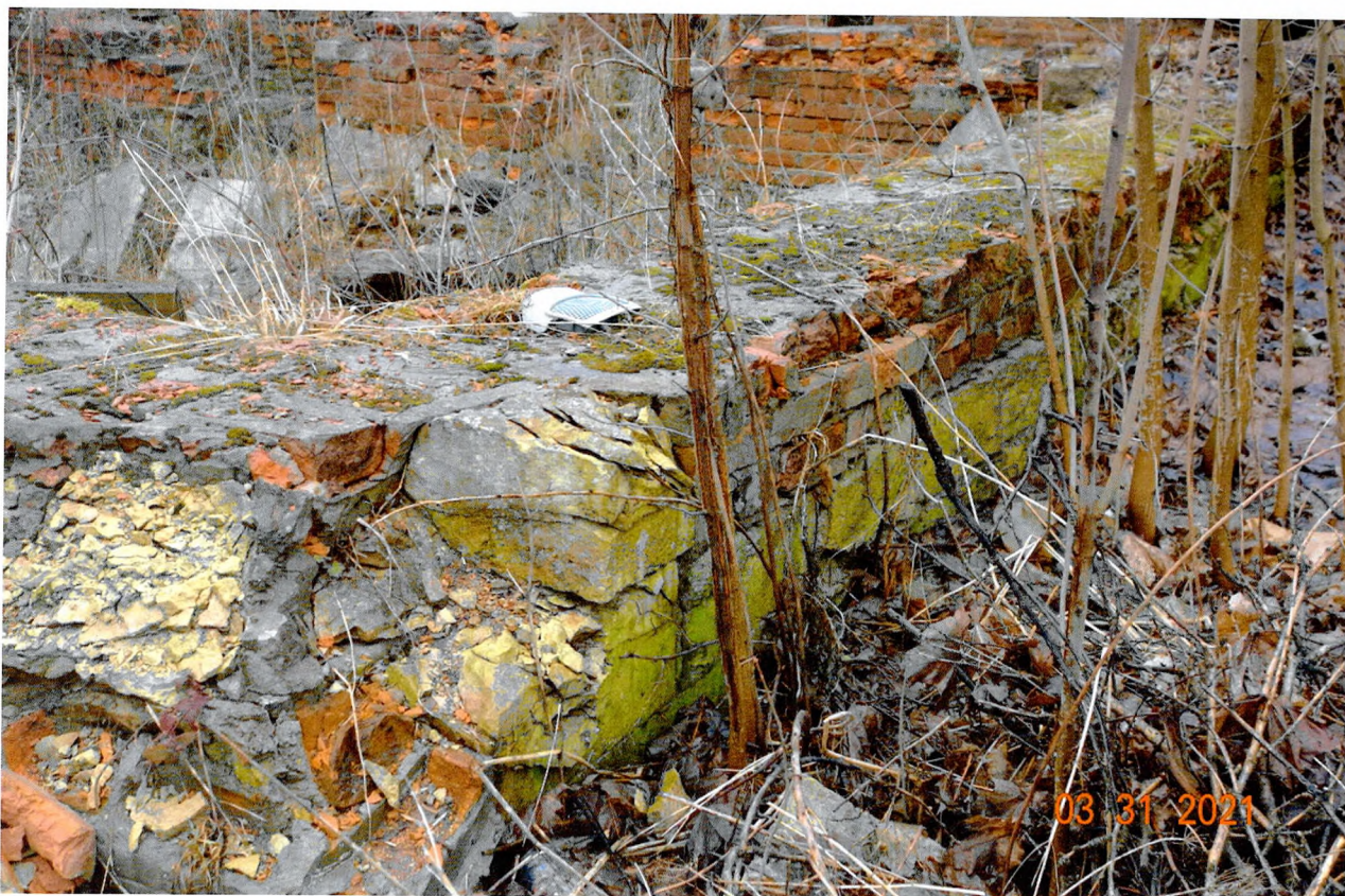
Фото 11. Дом в котором находился в 1919 – 1920 гг. Гатчинский УКОМ РКСМ. Фрагмент фундамента дома. Разувалов О.М., 31.03.2021 г.
