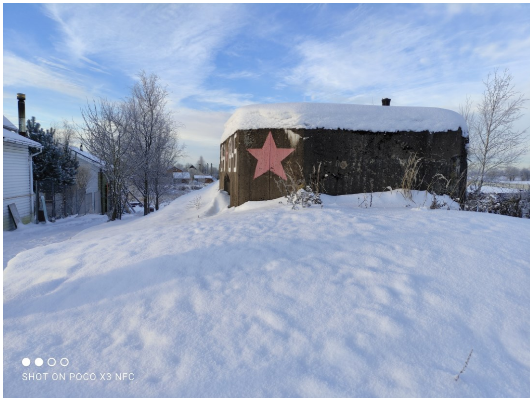
Фото 1. ДОТ с восточной стороны.
