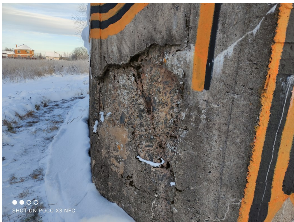
Фото 2. ДОТ с западной стороны. 10.12.2021
