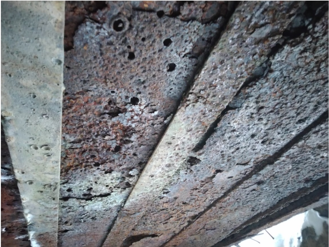
Фото 5. Перекрытие ДОТа. Металлические элементы. 10.12.2021.
