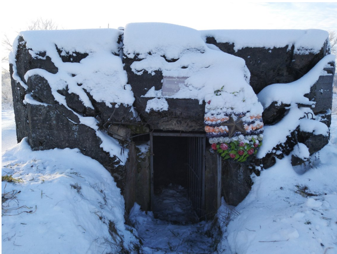
Фото 3. Северная часть ДОТа. 10.12.2021.
