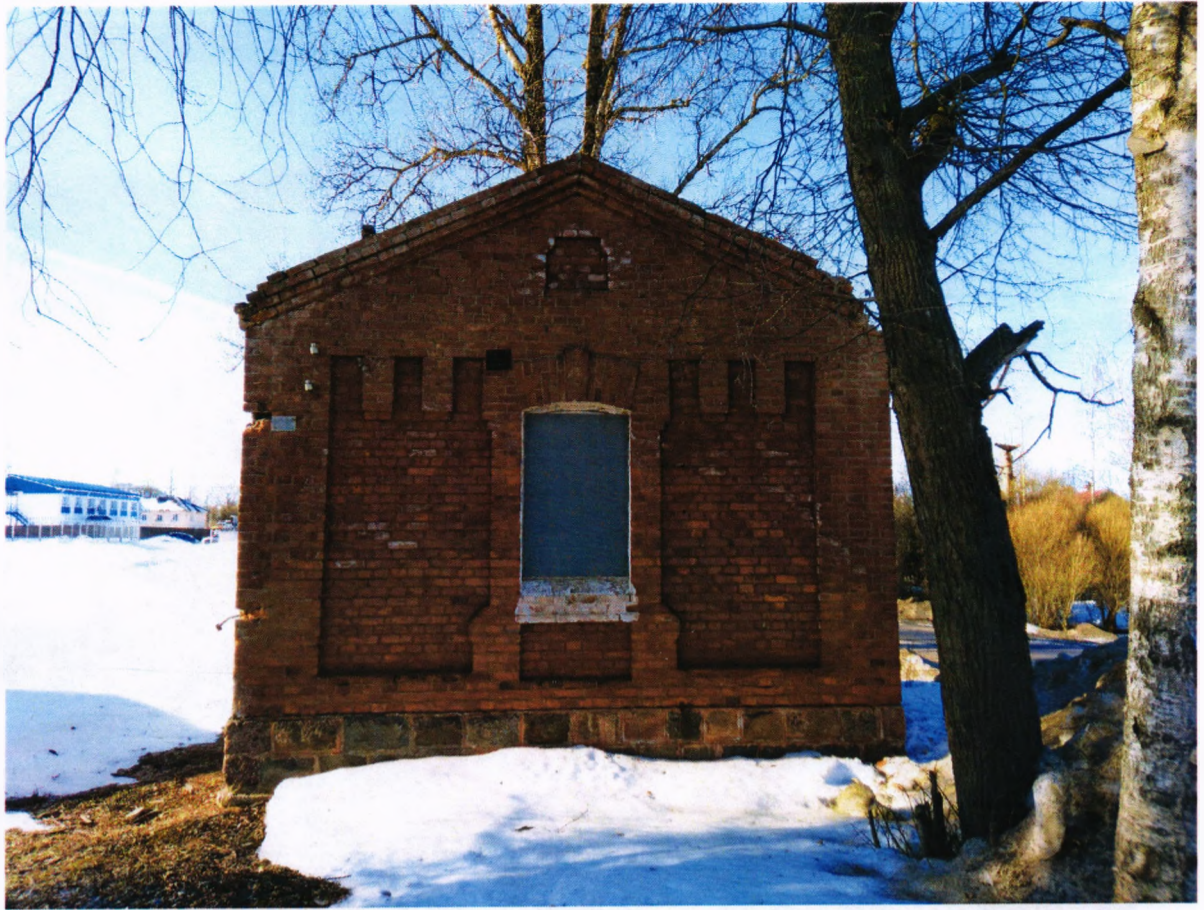
Фото 4. Северо-восточный фасад здания.
