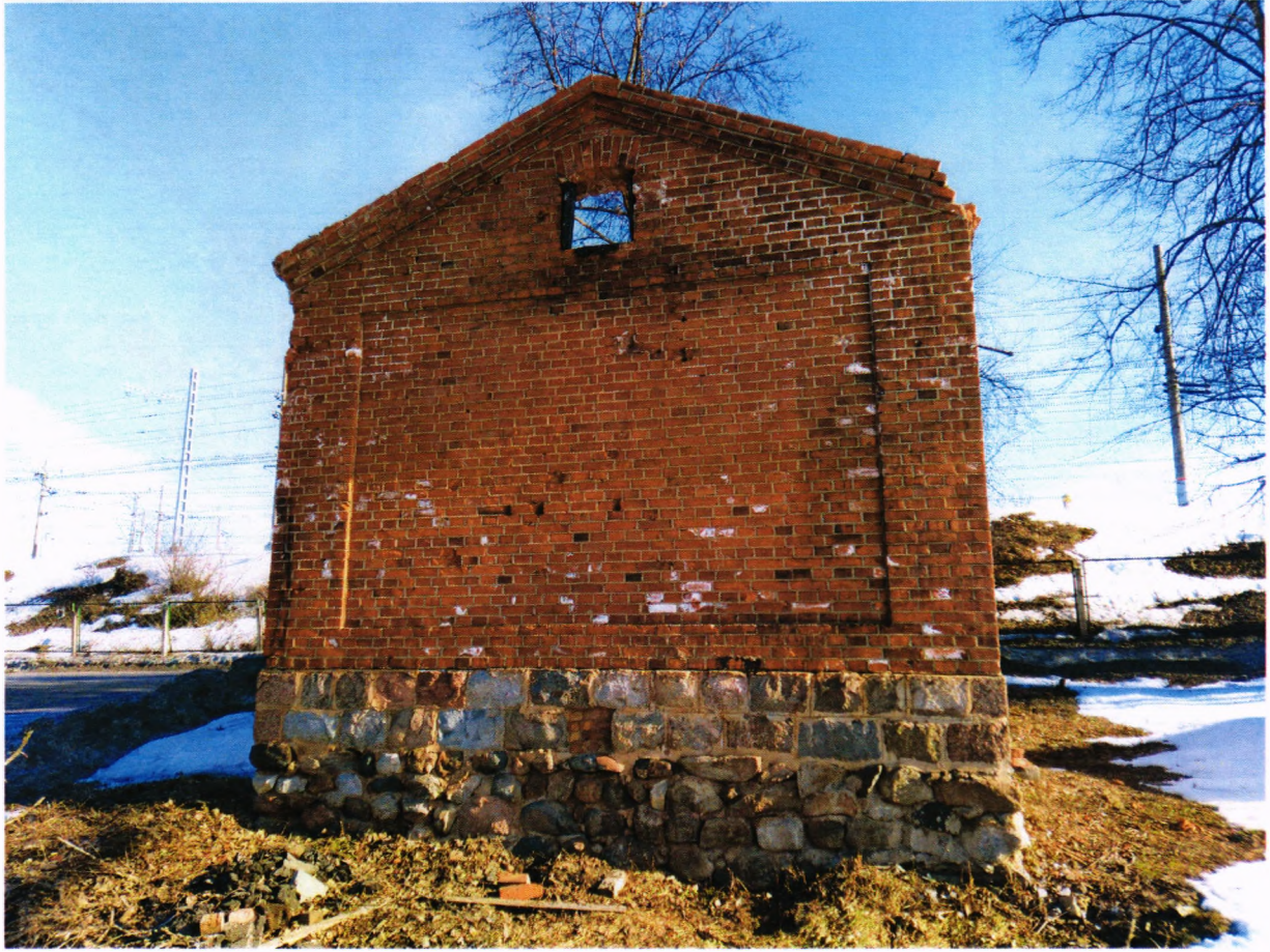
Фото 2. Юго-западный фасад здания.
