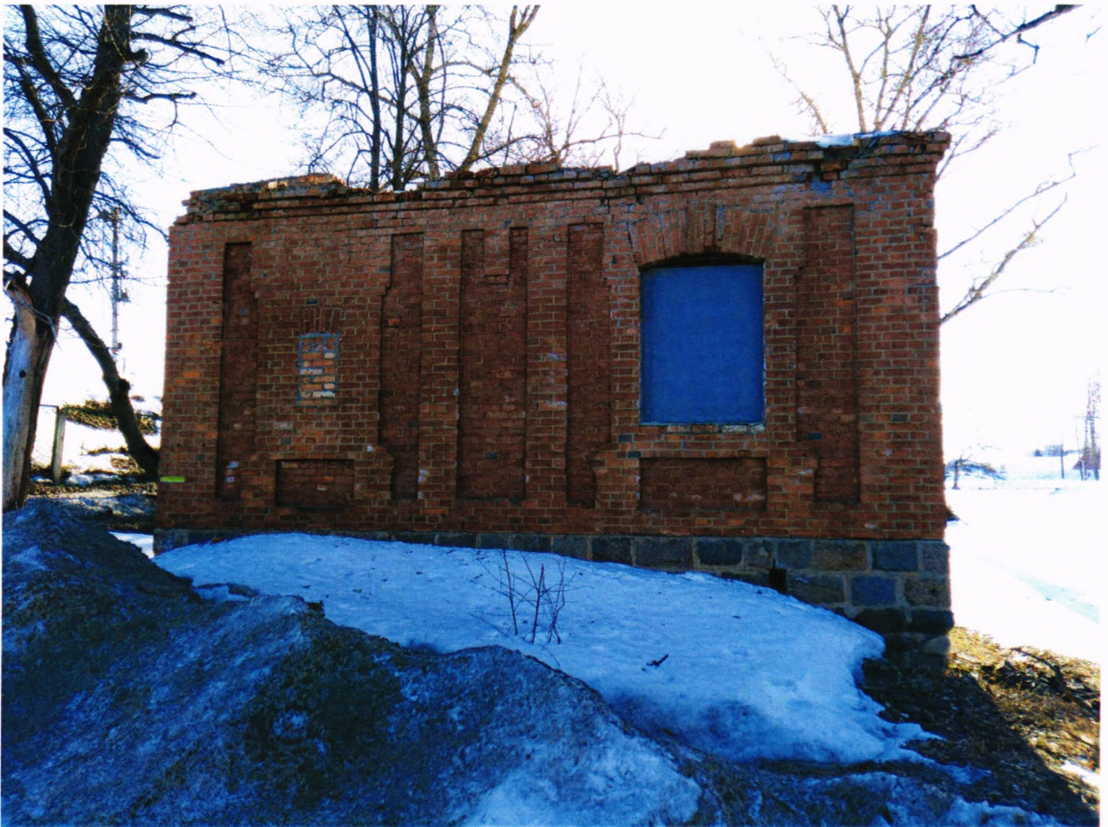
Фото 3. Северо-западный фасад здания.
