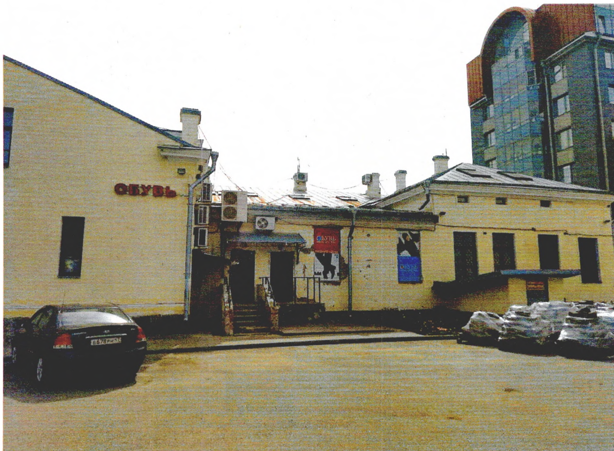
Фото 5. Северо-западный (дворовый) фасад объекта культурного наследия
