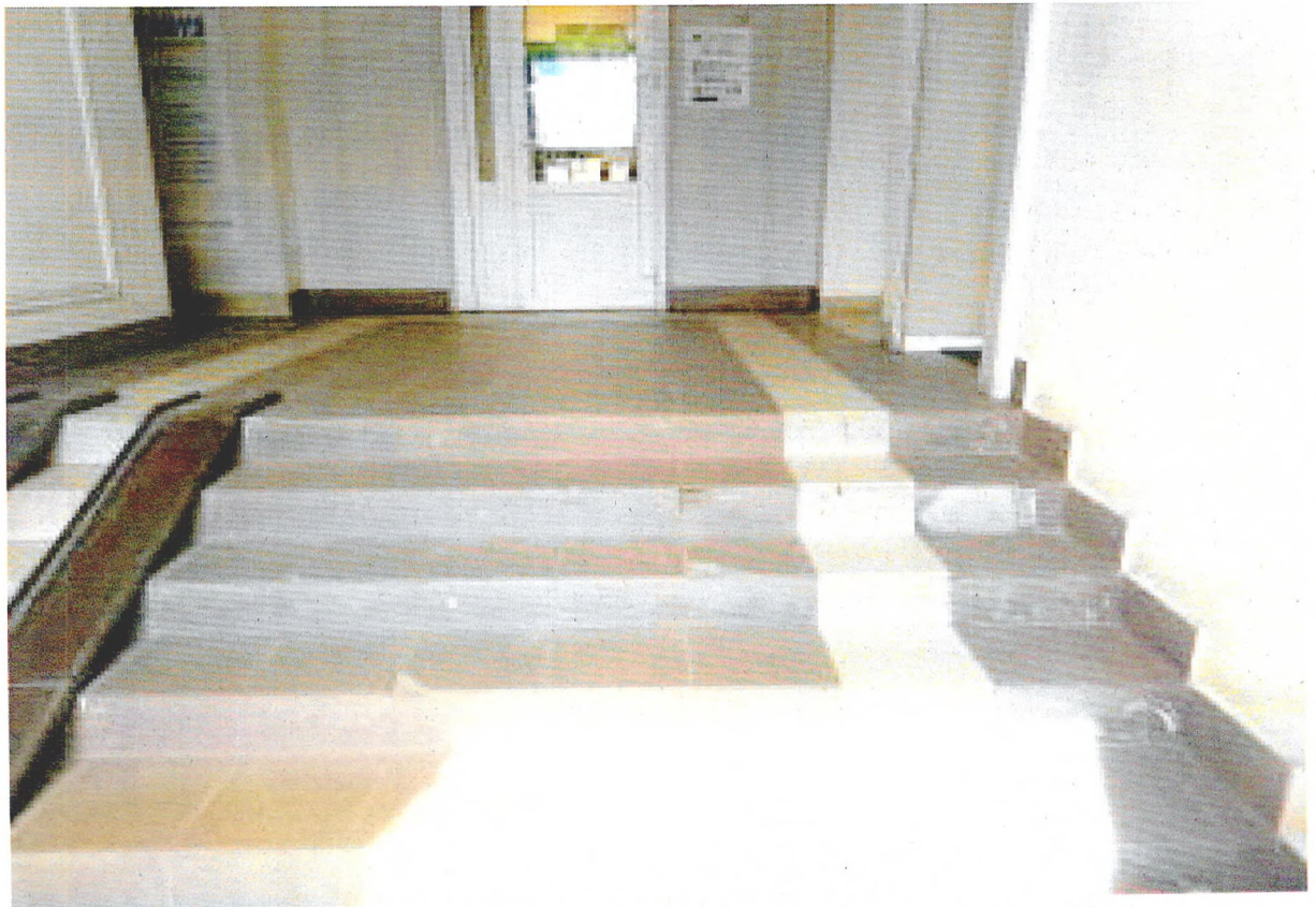
Фото 8. Ступени главного входа в объект культурного наследия
