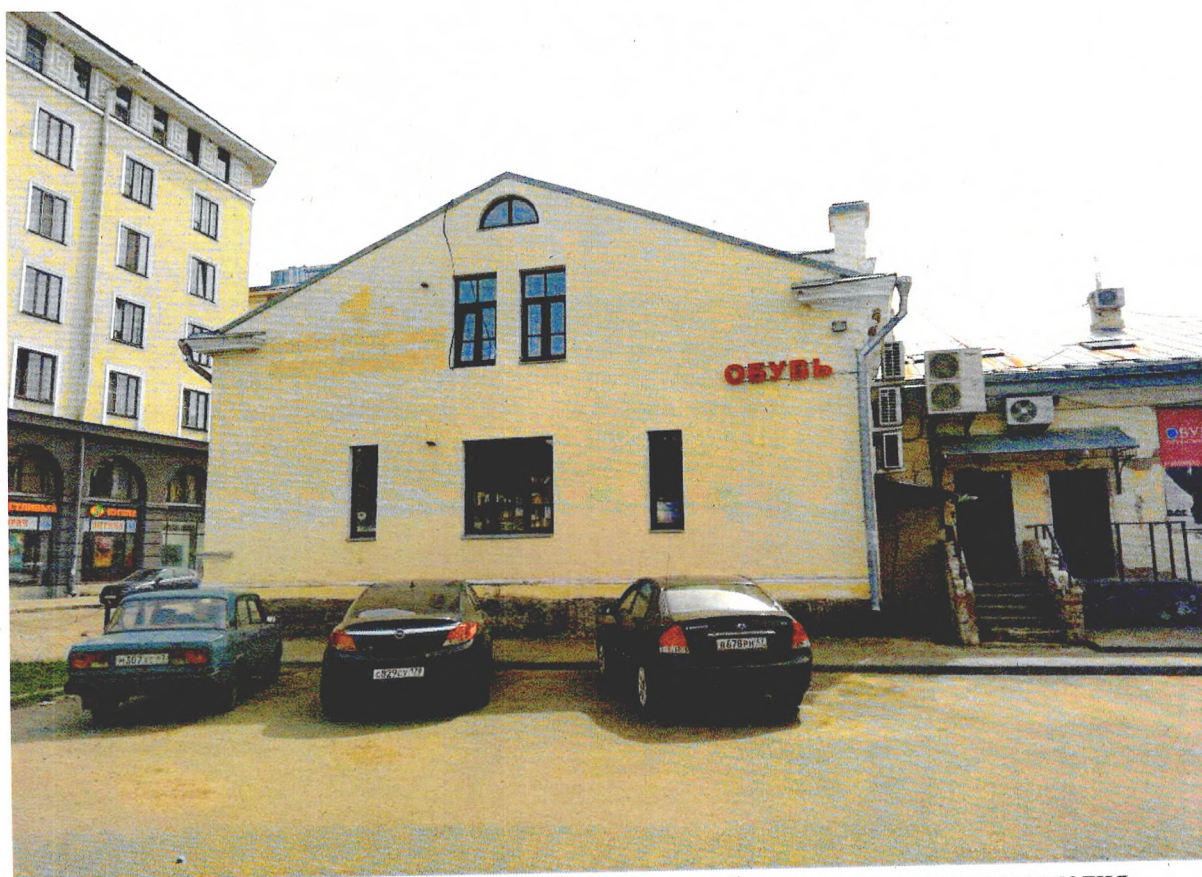
Фото 4. Северо-западный (дворовый) фасад объекта культурного наследия
