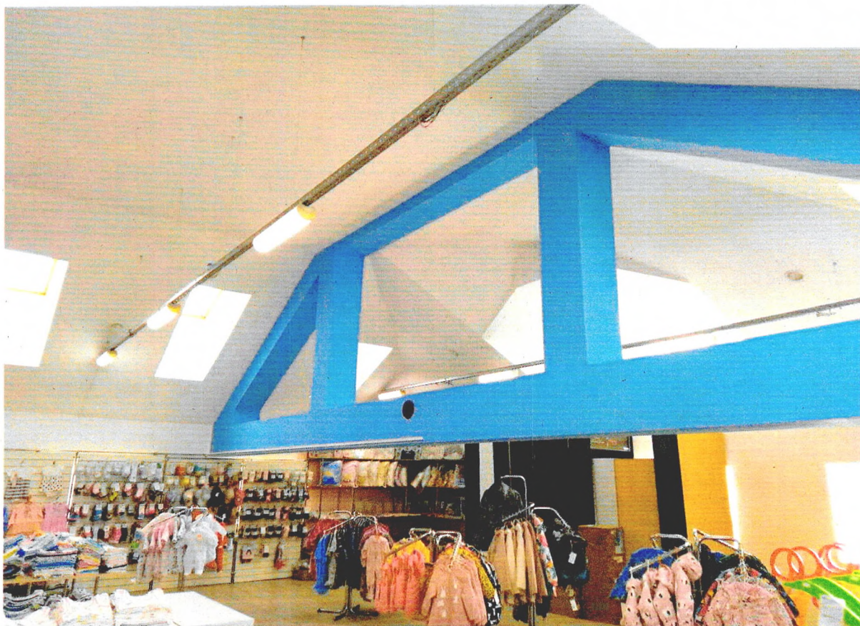
Фото 9. Мансардное помещение объекта культурного наследия
