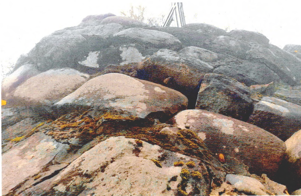
Фото 1. «Памятник-стела Петру I, установленный в честь посещения им здешних мест в 1712–1716 гг.» Выволы каменных блоков из пазухов. 29.09.2022 г.
