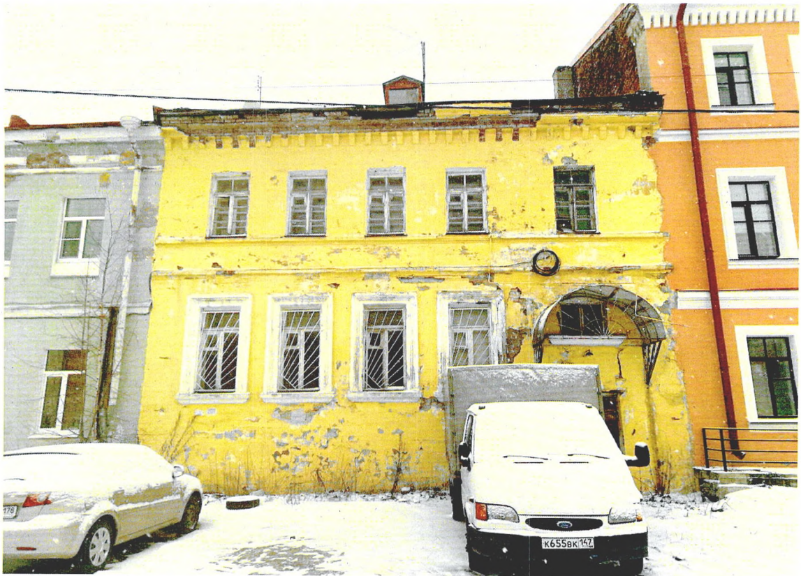
Фото 1. «Дом жилой купеческий» лицевой фасад со стороны Красной площади. 24.01.2023г.
