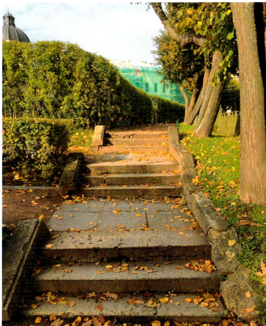
Фото 3. «Терраса Собственного садика и металлическая ограда». Каменные лестницы.
