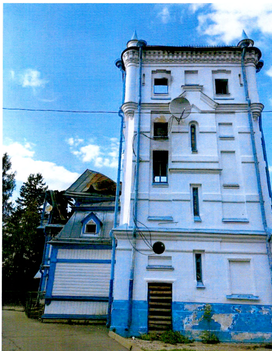
Фото 1. «Главный дом» Кирпичная пристройка с восточной стороны.
