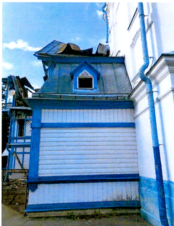
Фото 8. «Главный дом» сохранившаяся часть здания.
