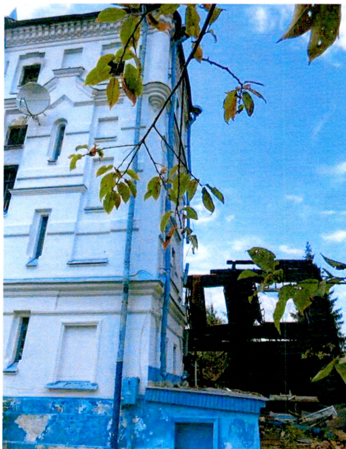
Фото 2. «Главный дом» Кирпичная пристройка с восточной стороны.
