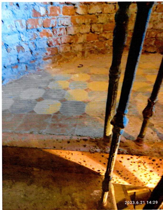
Фото 6. «Осиновецкий маяк» металлические балясины перильного ограждения.
