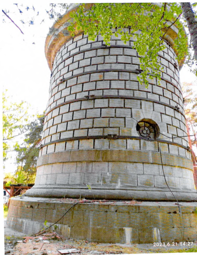
Фото 5. «Осиновецкий маяк» гранитный цоколь сооружения, зафиксированы высолы между гранитными блоками облицовки, биопоражения на блоках.
