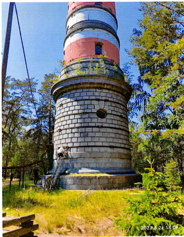
Фото 1. «Осиновецкий маяк» общий вид восточного фасада сооружения.
