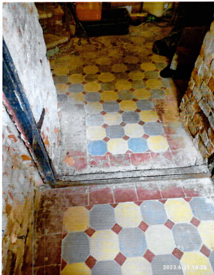
Фото 6. «Осиновецкий маяк» площадка цокольного этажа.
