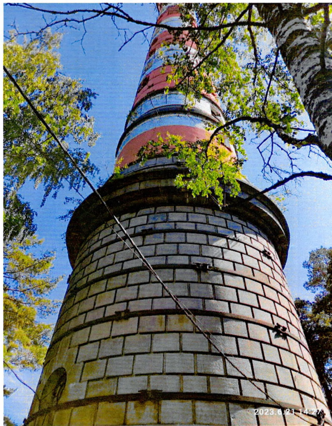
Фото 4. «Осиновецкий маяк» общий вид северного фасада сооружения.
