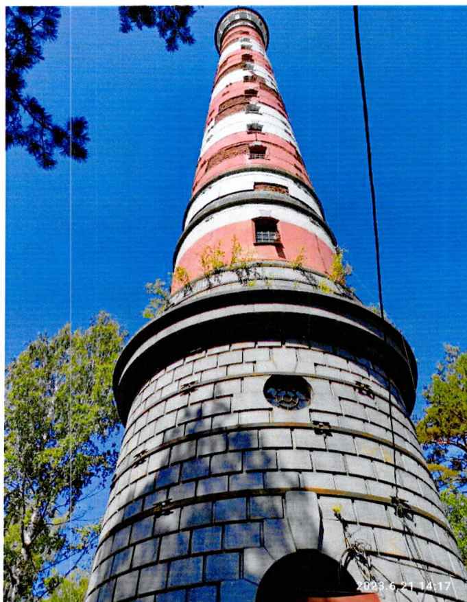
Фото 2. «Асиновецкий маяк» общий вид южного фасада сооружения.
