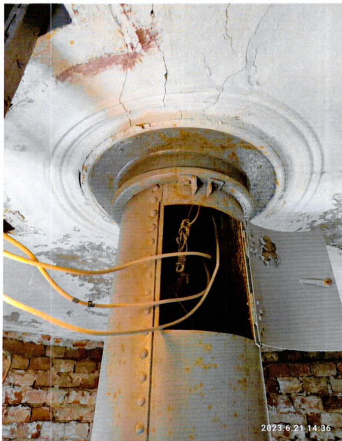
Фото 8. «Осиновецкий маяк» перекрытие верхнего яруса, металлическое оборудование маяка.
