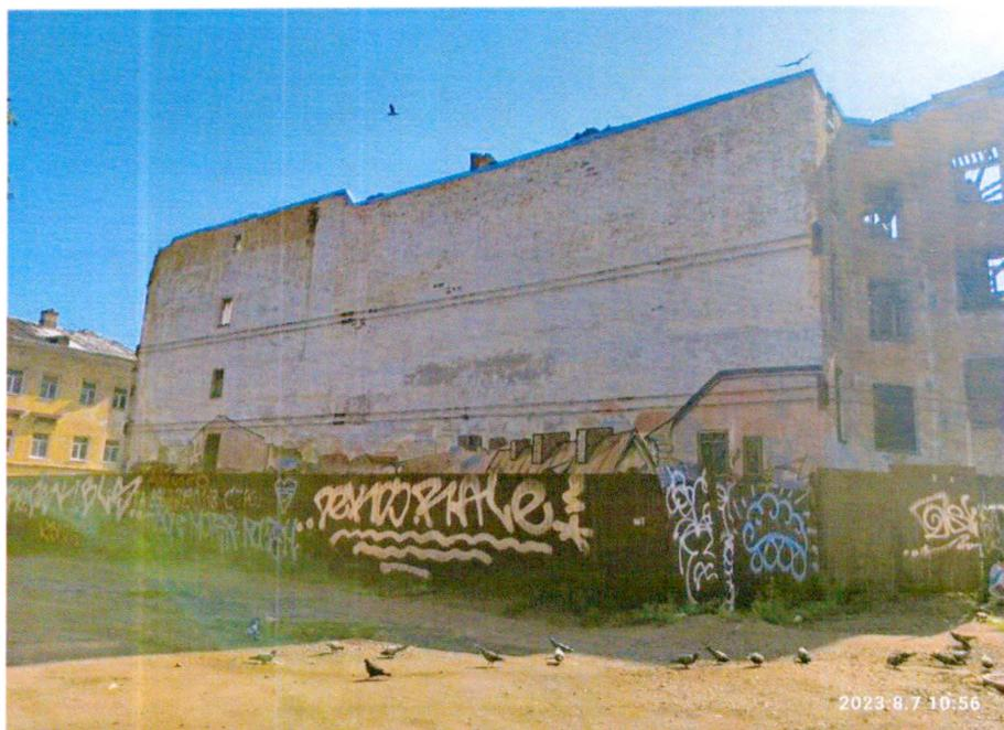
Фото 1. «Жилой дом» западный фасад, по периметру установлено металлическое ограждение коричневого цвета для ограничения доступа на территорию посторонних лиц, на фасаде и защитном ограждении здания зафиксированы следы граффити.
