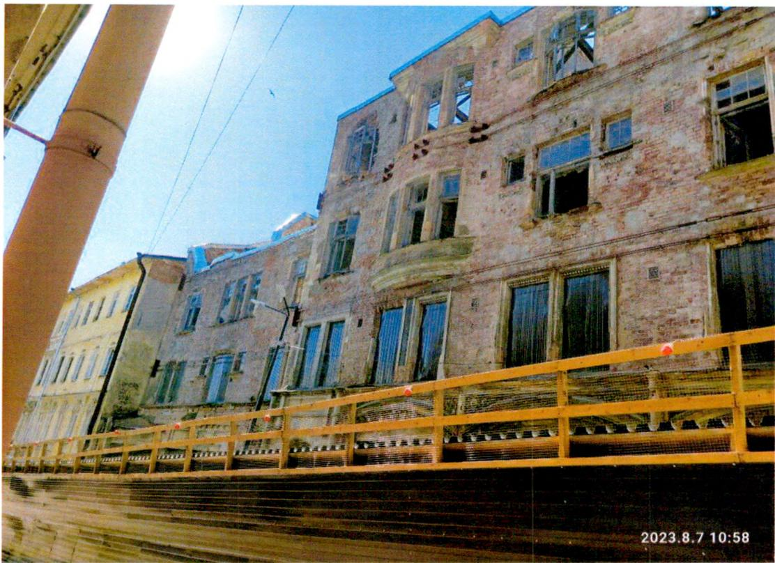
Фото 7. «Жилой дом» северный фасад по улице Крепостной, стены четвёртого этажа покрыты кровельным железом.
