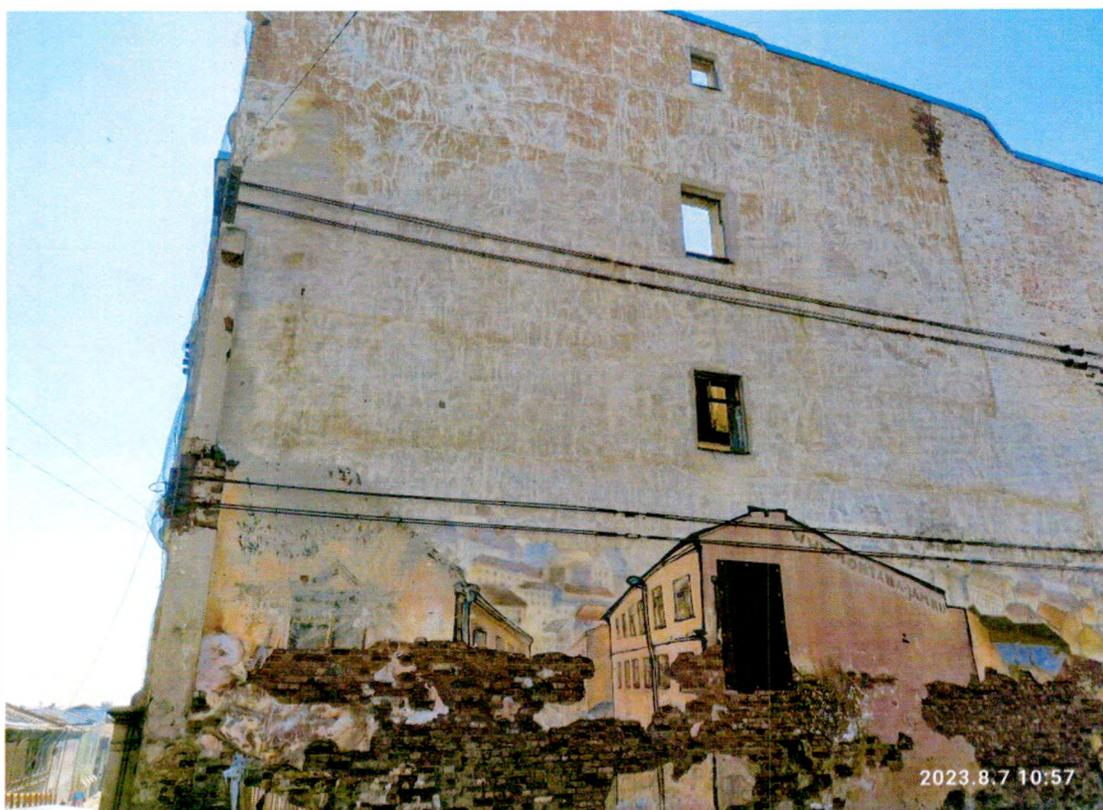
Фото 4. «Жилой дом» западный фасад, зафиксировано разрушение кирпичной кладки.
