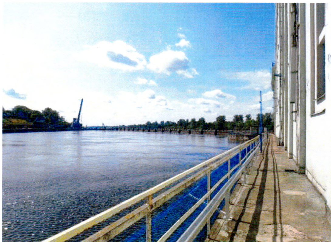
Фото 14. Волховская ГЭС. Ледозащитная стенка. Вид с северо-востока.
