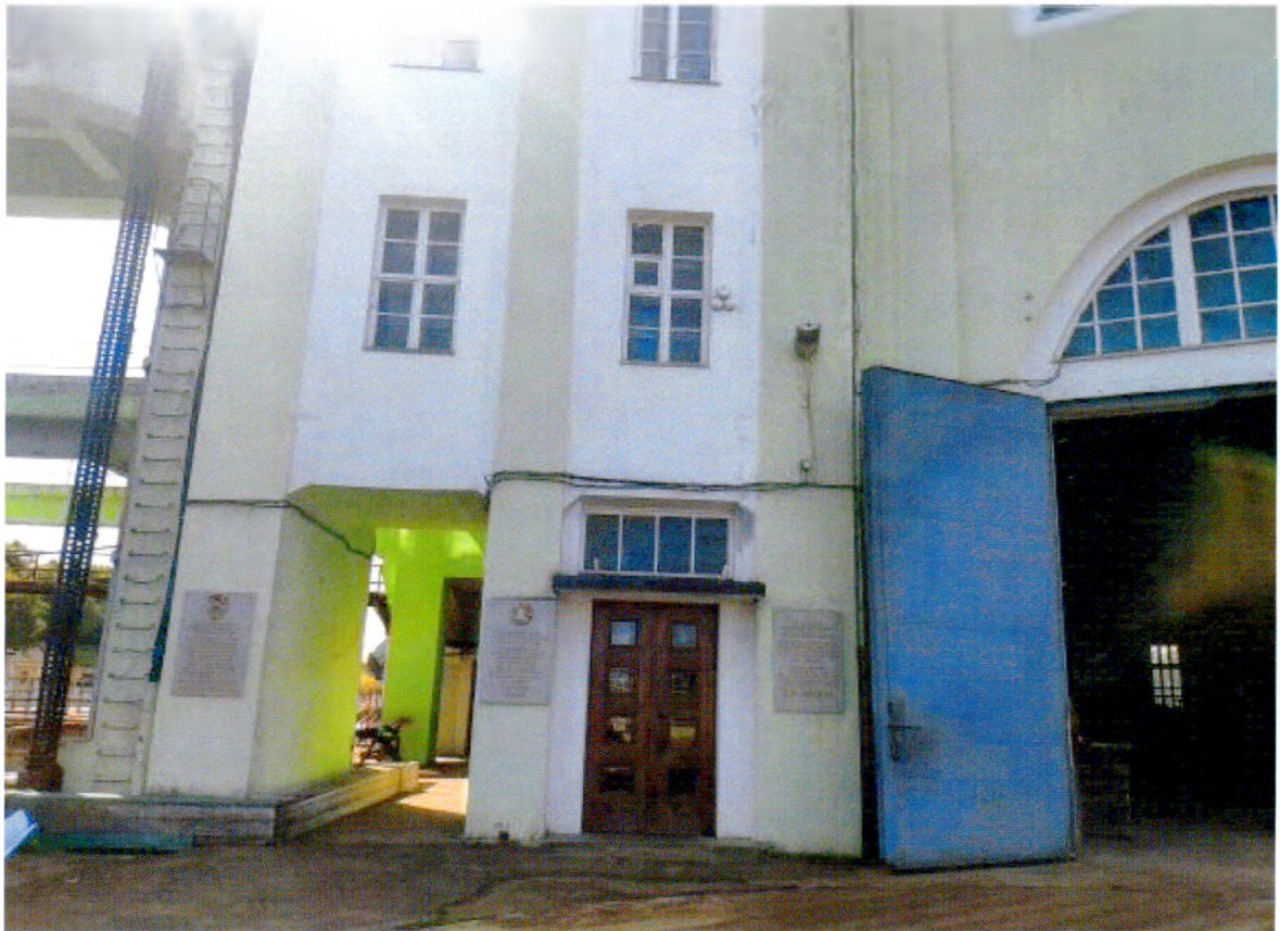
Фото 7. Волховская ГЭС. Фрагмент северо-восточного фасада. Входная группа.
