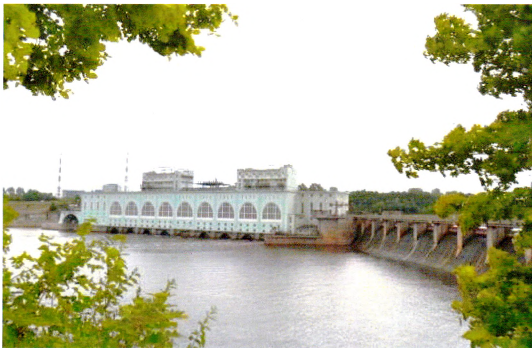
Фото 1. Волховская ГЭС. Общий вид с востока.
