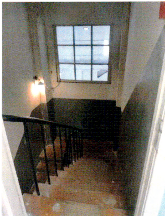
Фото 25. Волховская ГЭС. «Чёрная» лестница. Общий вид.
