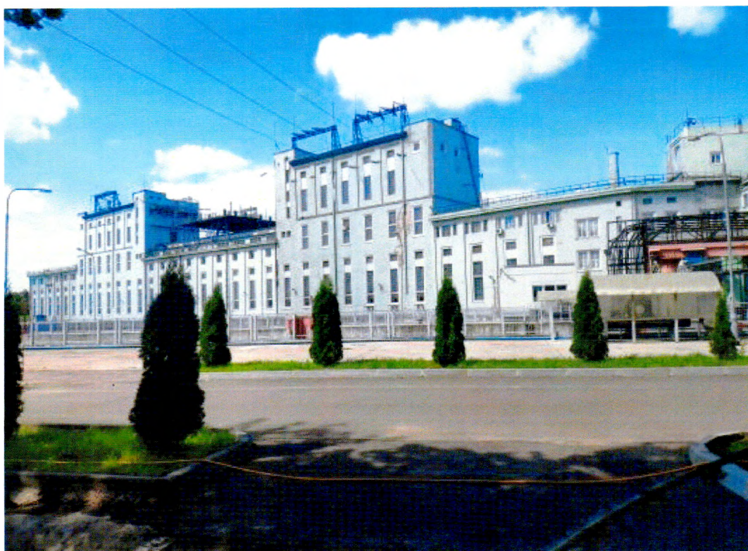
Фото 2. Волховская ГЭС. Юго-западный фасад, вид с запада.
