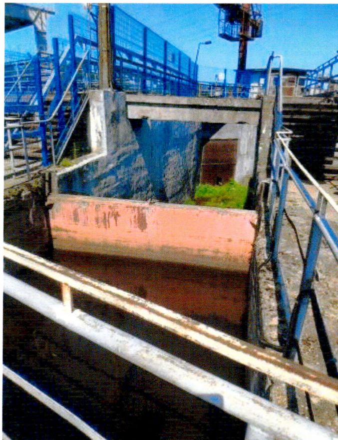
Фото 15. Волховская ГЭС. Рыбоходное сооружение
