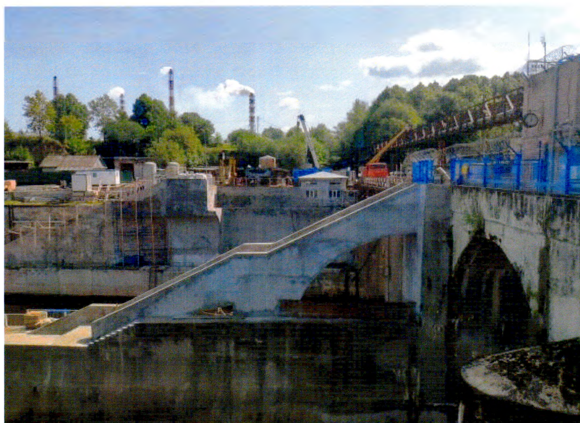
Фото 4. Волховская ГЭС. Общий вид с юго-запада на надземную часть камеры шлюза.
