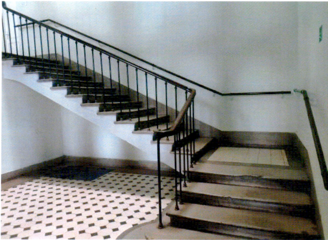
Фото 19. Волховская ГЭС. Первый этаж. Парадная лестница. Вид с северо-востока.
