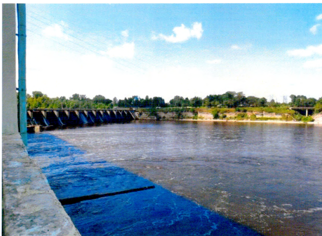
Фото 12. Волховская ГЭС. Водосборная плотина.
