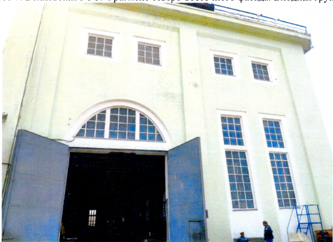
Фото 9. Волховская ГЭС. Фрагмент северо-восточного фасада. Входная группа.
