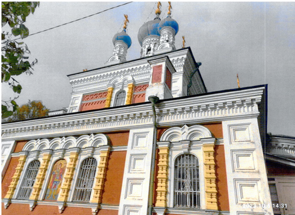
Фото 6. «Церковь Егерской слободки». Южный фасад.
