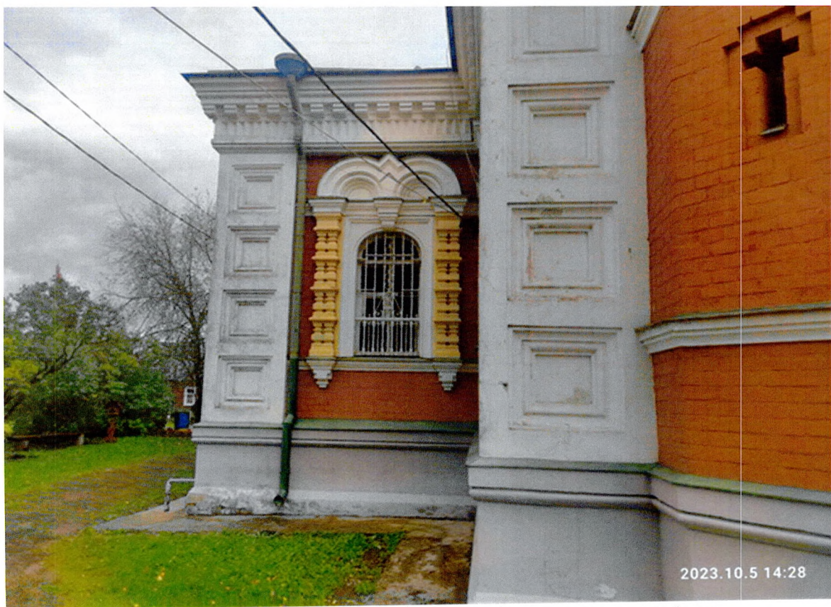
Фото 3. «Церковь Егерской слободки». Северо-западный фасад.
