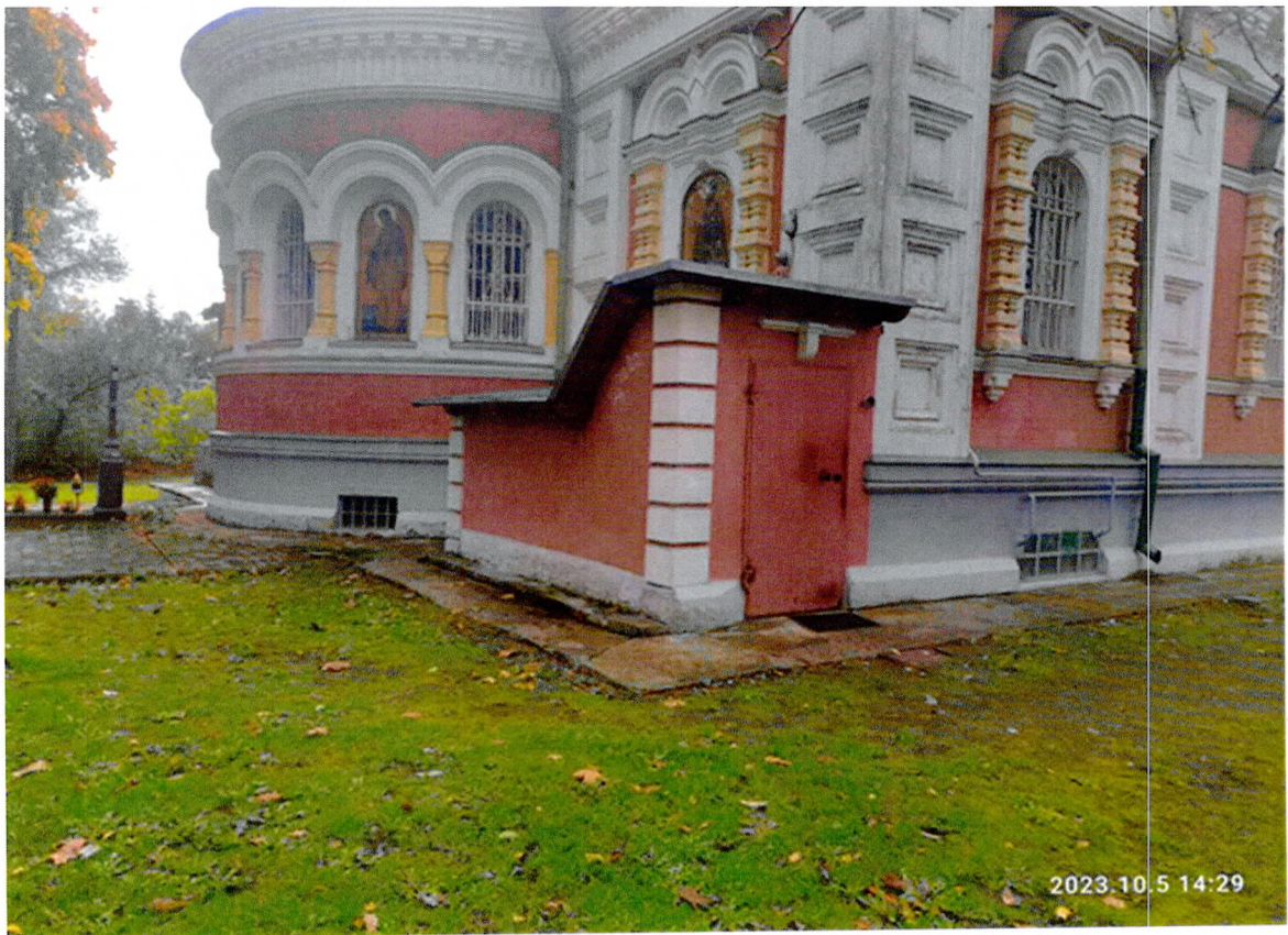
Фото 5. «Церковь Егерской слободки». Прямок цокольного этажа.
