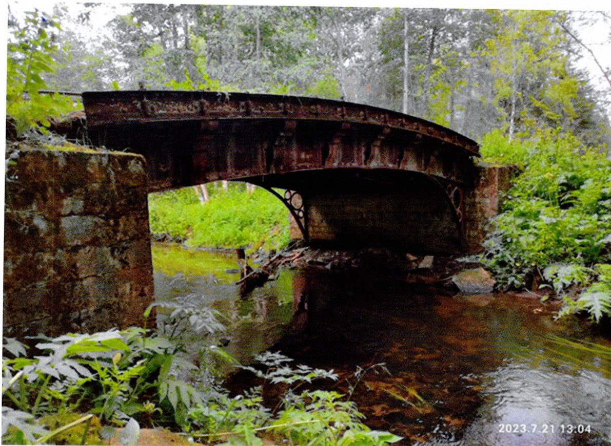
Фото 2. «Мост № 1». Общий вид на верхнюю сторону моста.
