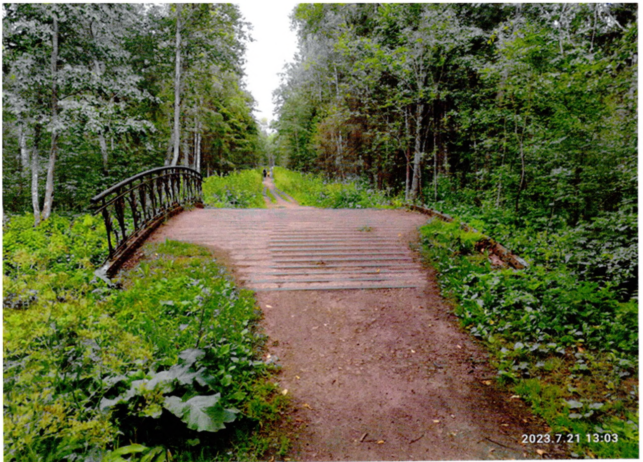
Фото 1. «Мост № 1». Общий вид с левого берега.
