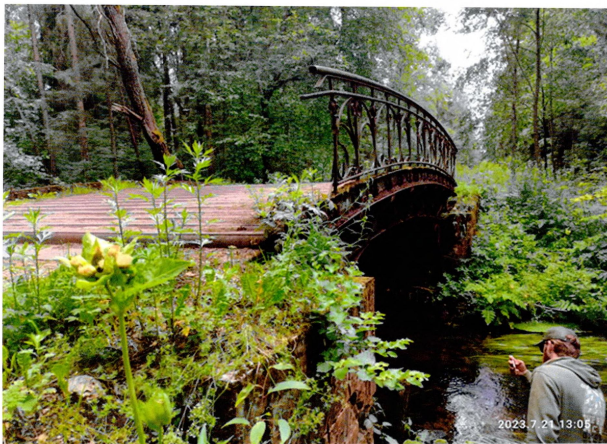
Фото 3. «Мост № 1». Общий вид на низовую сторону моста.
