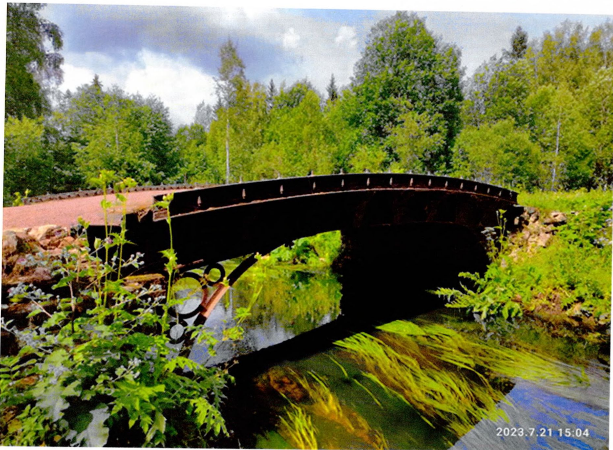
Фото 2. «Красный мост № 1». Общий вид с левого берега
