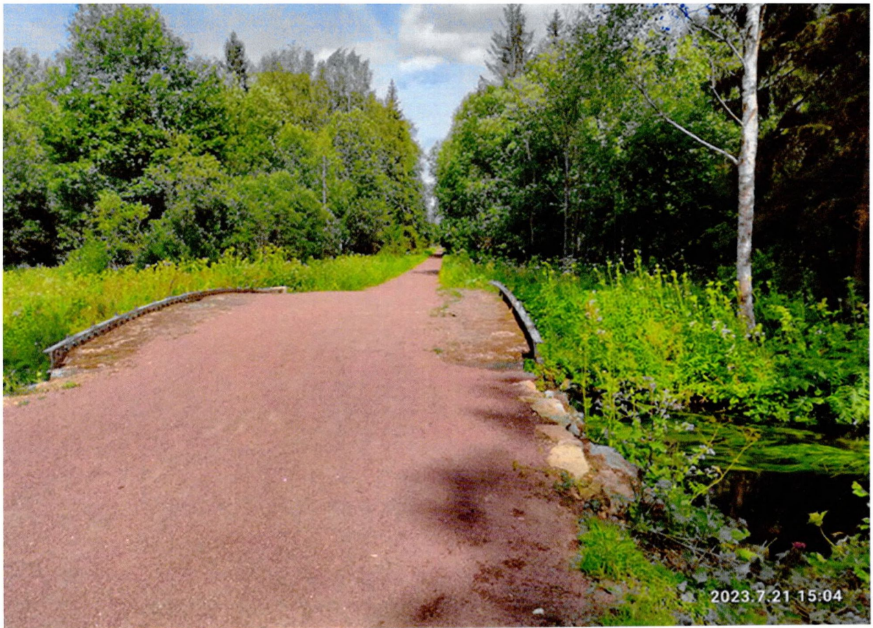
Фото 1. «Красный мост № 1». Общий вид с левого берега.
