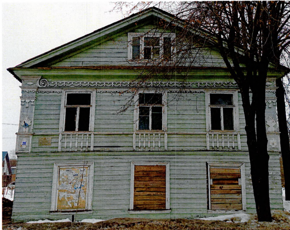
Фото 1. Главный фасад, выходящий на проспект Карла Маркса. Облицован крашеной доской с калевкой. Декор в виде венчающего профилированного карниза, пропиленной резьбы, пилястр, фигурных балясин под окнами второго этажа, наличников оконных проемов.
