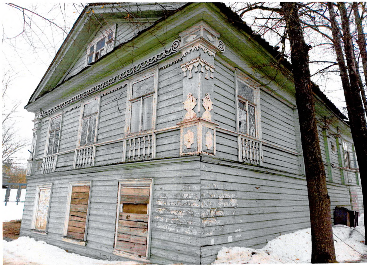
Фото 3. Вид со стороны проспекта Карла Маркса. Наблюдается отслоение красочного слоя.
