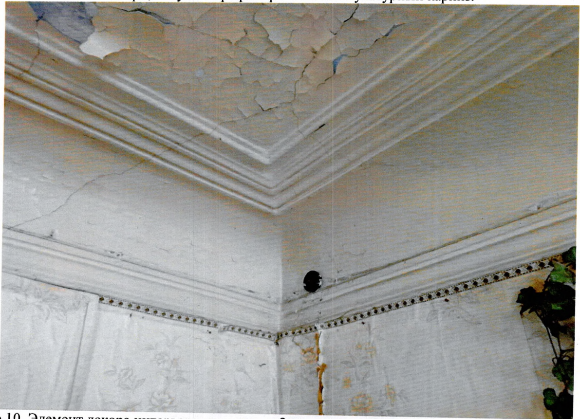
Фото 10. Элемент декора интерьера помещения 2 этажа: тянутый профилированный штукатурный карниз.
