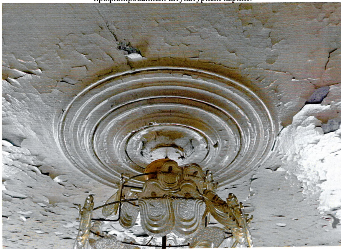
Фото 12. Элемент декора интерьера помещения 2 этажа: декоративная штукатурная розетка.
