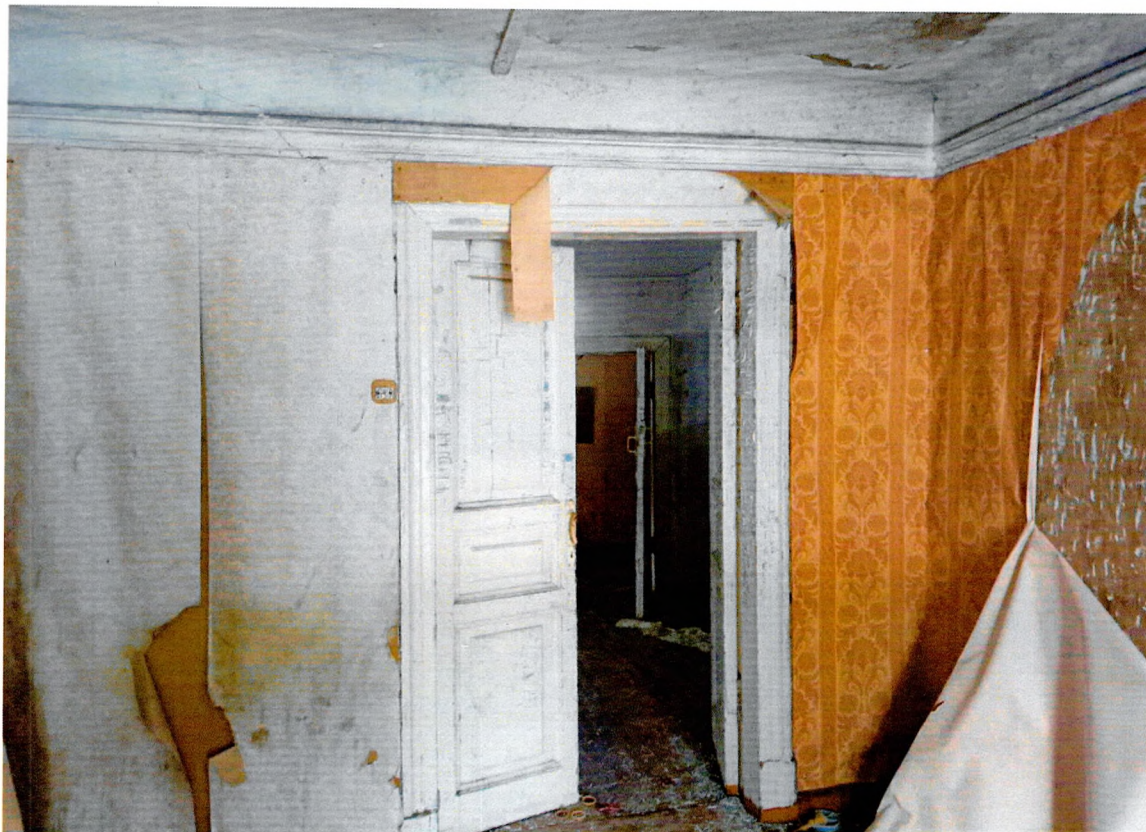
Фото 11. Интерьер помещения 2 этажа. Деревянные филенчатые двери, тянутый профилированный штукатурный карниз.
