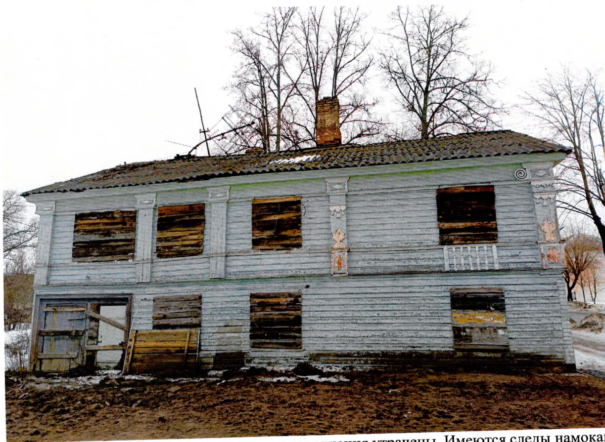
Фото 3. Вид со стороны проспекта Карла Маркса. Наблюдается отслоение красочного слоя.
