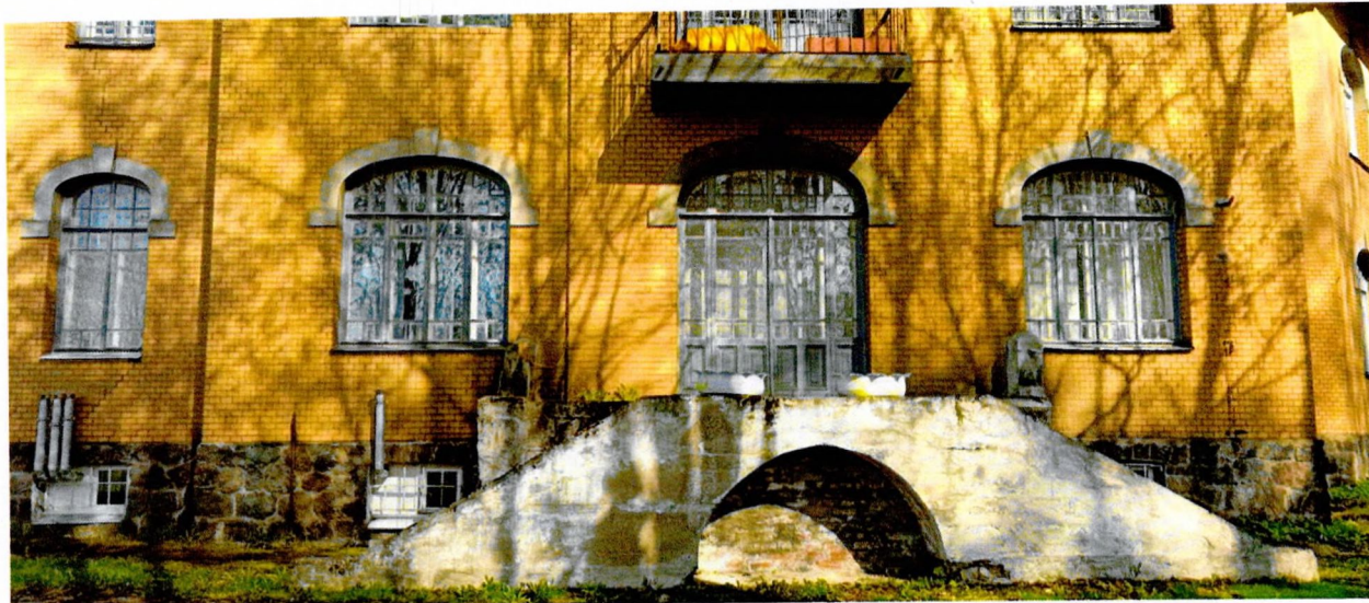
Фото 3. Фрагмент западного фасада, вид на крыльцо западного входа.
