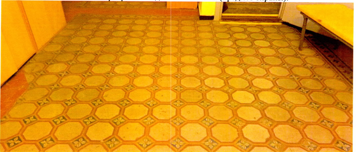
Фото 13. Чистовая отделка пола подвальных помещений – в историческом исполнении, метлахская плитка (предмет охраны).
