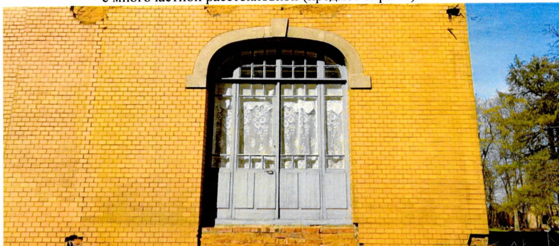
Фото 10. Историческое заполнение проема южного входа – деревянное с многочастной расстекловкой и филенками в нижней части (предмет охраны).
