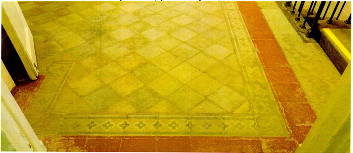
Фото 22. Напольное покрытие помещений 2 этажа – в историческом исполнении: метлахская плитка (предмет охраны).
