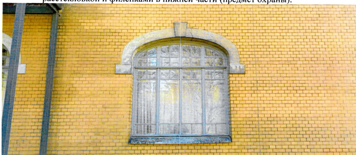
Фото 8. Историческое заполнение оконного проема 1 этажа восточного фасада – деревянное с многочастной расстекловкой. Оконные и дверные проемы с коробовой перемычкой декорированы штукатурными архивольтами с замковым камнем (предмет охраны).
