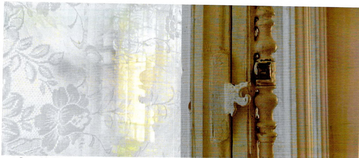
Фото 18. Историческая фурнитура заполнения оконных проемов (предмет охраны). исполнении.
