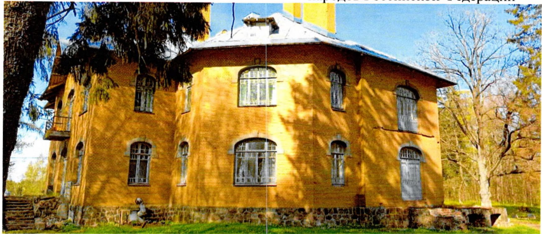
Фото 1. Общий вид с северо-запада. Характер отделки плоскости фасадов – лицевой кирпич с гладкой поверхностью желтого цвета.
