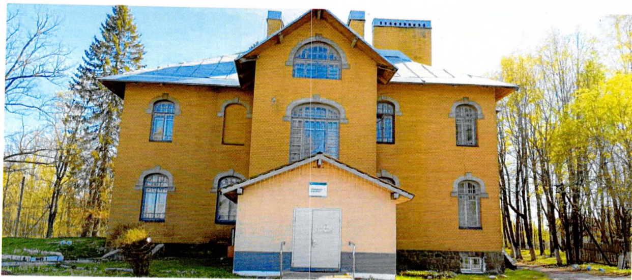
Фото 6. Общий вид северного фасада.
