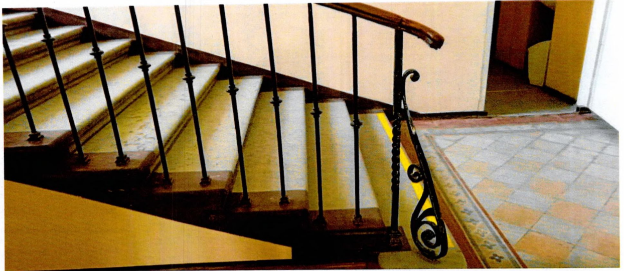
Фото 15. Металлическое ограждение каменной лестницы, ведущей на 2 этаж, - металлические фигурные балясины (предмет охраны).
