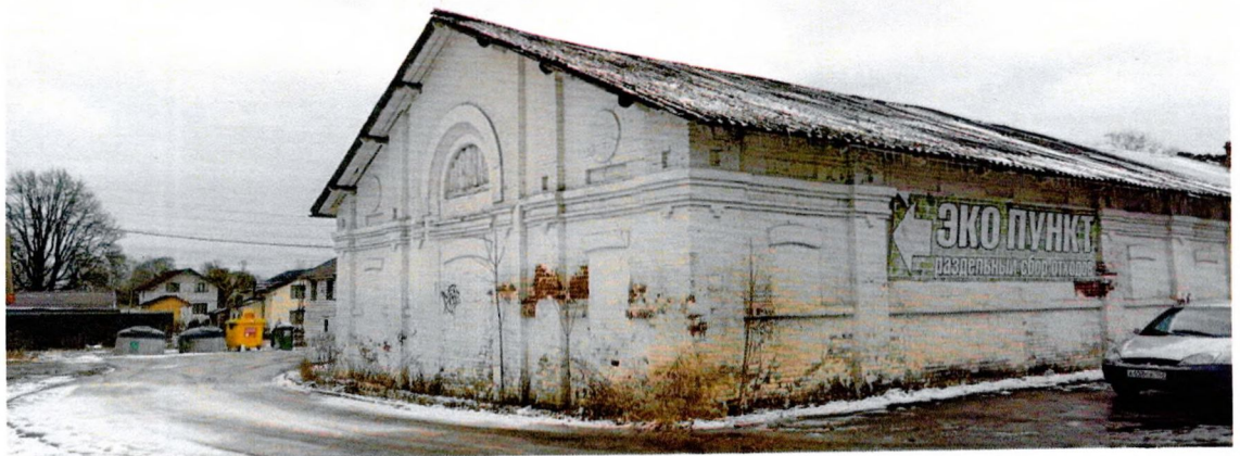
Фото 8. Вид с северо-запада.
