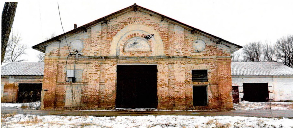
Фото 1. Восточный фасад. Наружные стены – кирпичная кладка. Декоративные элементы в виде кирпичных профилированных карнизов, пилястр, круглых розеток по бокам треугольного фронтона (предмет охраны).
