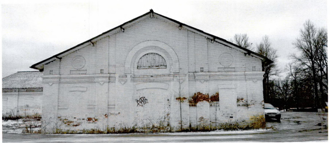
Фото 9. Северный фасад. Декоративные элементы в виде профилированного кирпичного карниза, пилястр. Оконные проемы декорированы сандриками в виде кирпичных клинчатых перемычек (предмет охраны).
