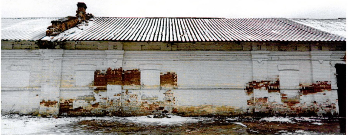
Фото 7. Фрагмент западного фасада. Оконные проемы декорированы сандриками в виде кирпичных клинчатых перемычек (предмет охраны).
