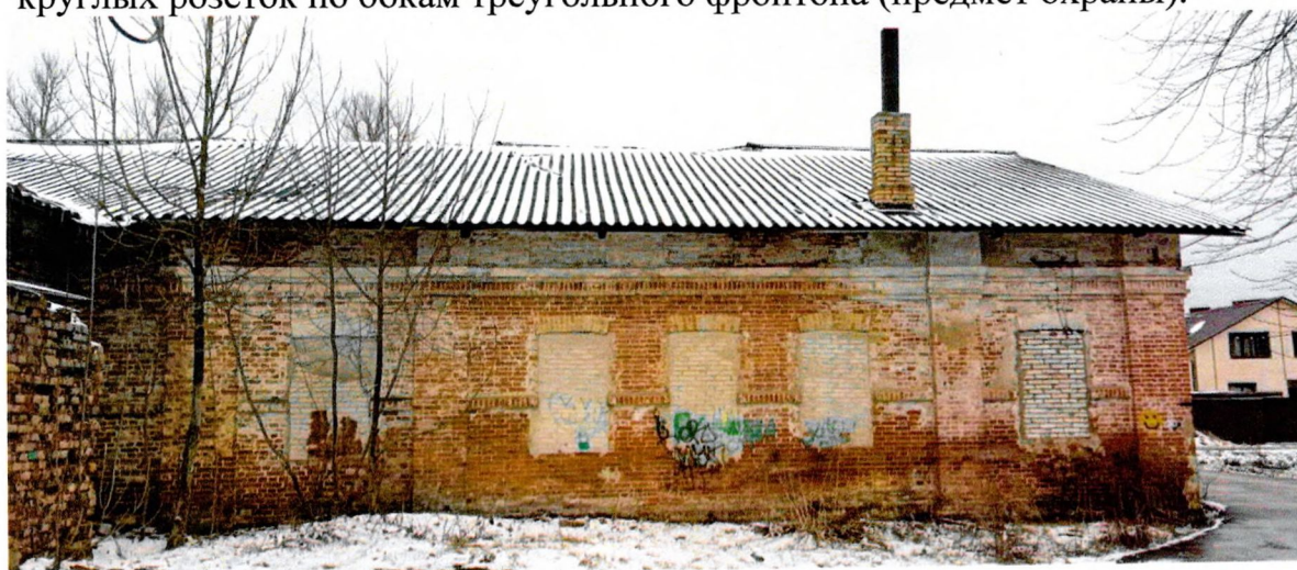
Фото 2. Фрагмент южного фасада.
