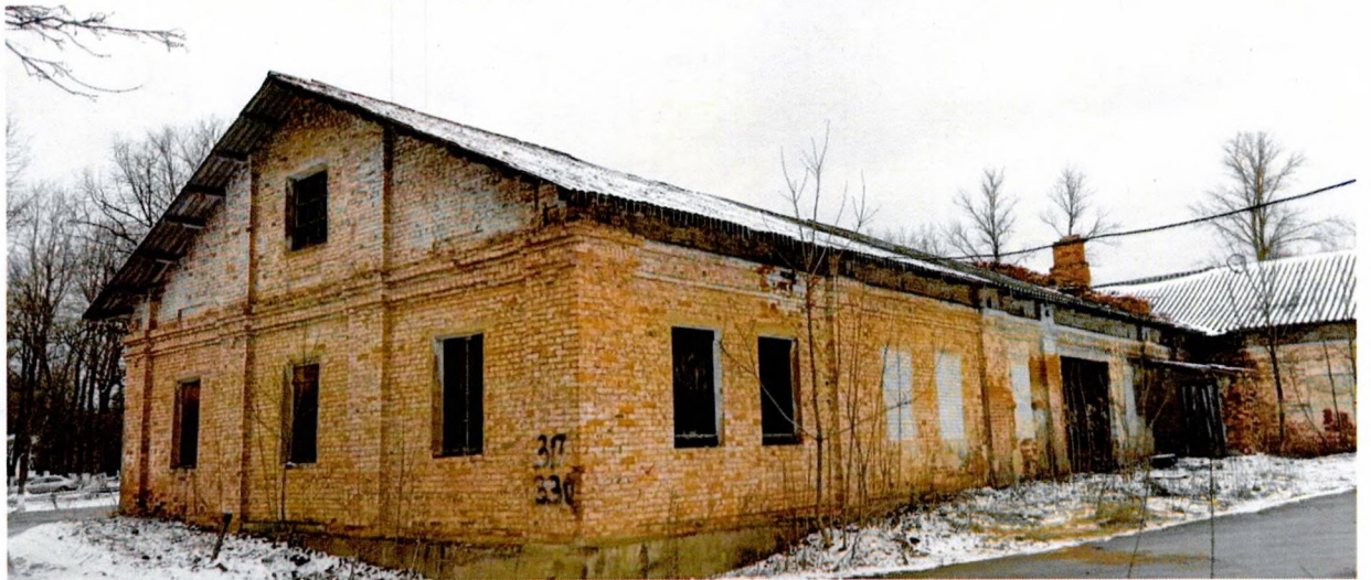
Фото 4. Вид с юго-востока. Декор в виде кирпичного профилированного карниза и пилястр (предмет охраны).
