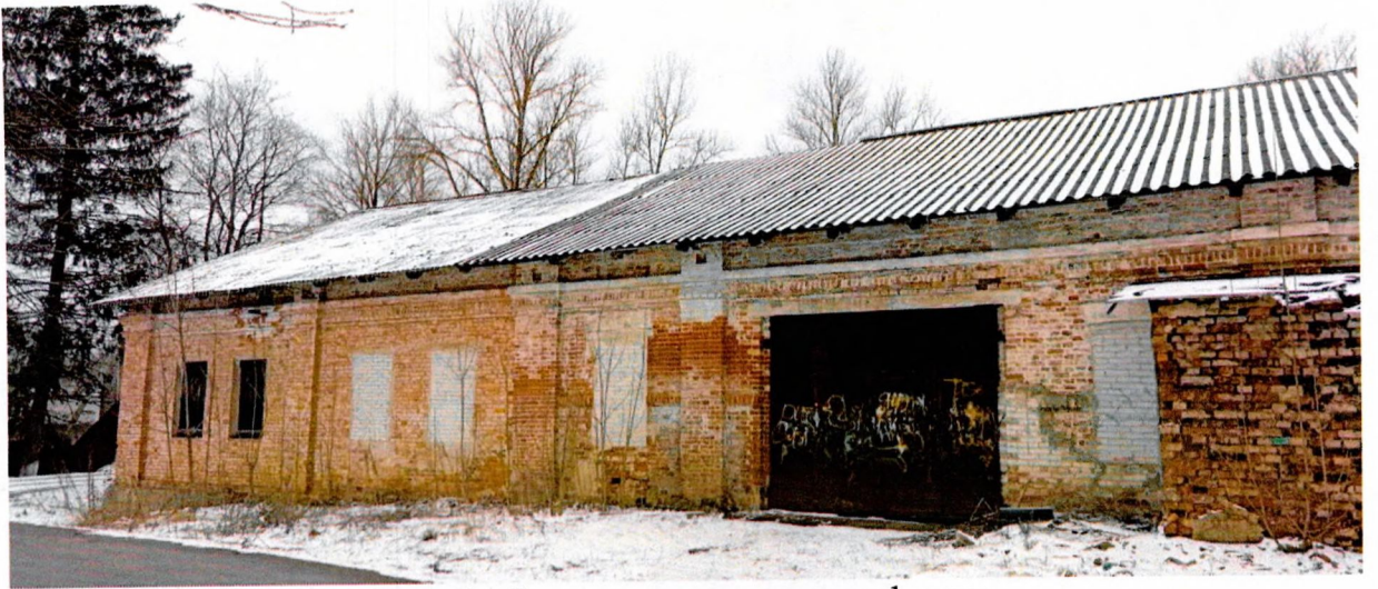
Фото 3. Фрагмент восточного фасада.
