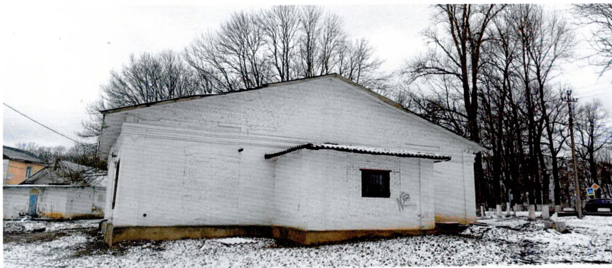
Фото 2. Общий вид восточного фасада.
