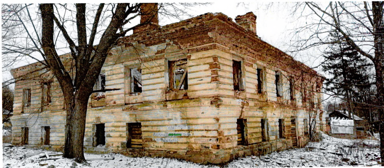
Фото 5. Общий вид с юго-запада.
