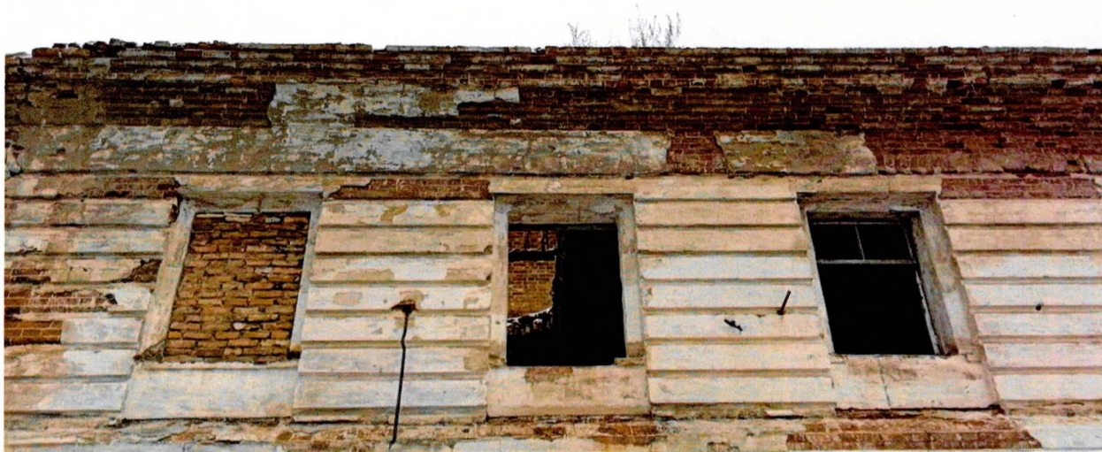
Фото 1. Фрагмент южного фасада. Оконные проемы 2 этажа. Фасад декорирован рустом крупного членения, увенчан кирпичным профилированным карнизом широкого выноса.
