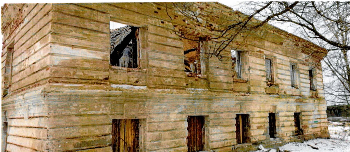
Фото 3. Вид на западный фасад. В уровне 1 и 2 этажей фасад декорирован рустом крупного членения, межэтажным профилированным карнизом. Фасад увенчан профилированным карнизом. Поверхность фасада гладкая штукатурная.
