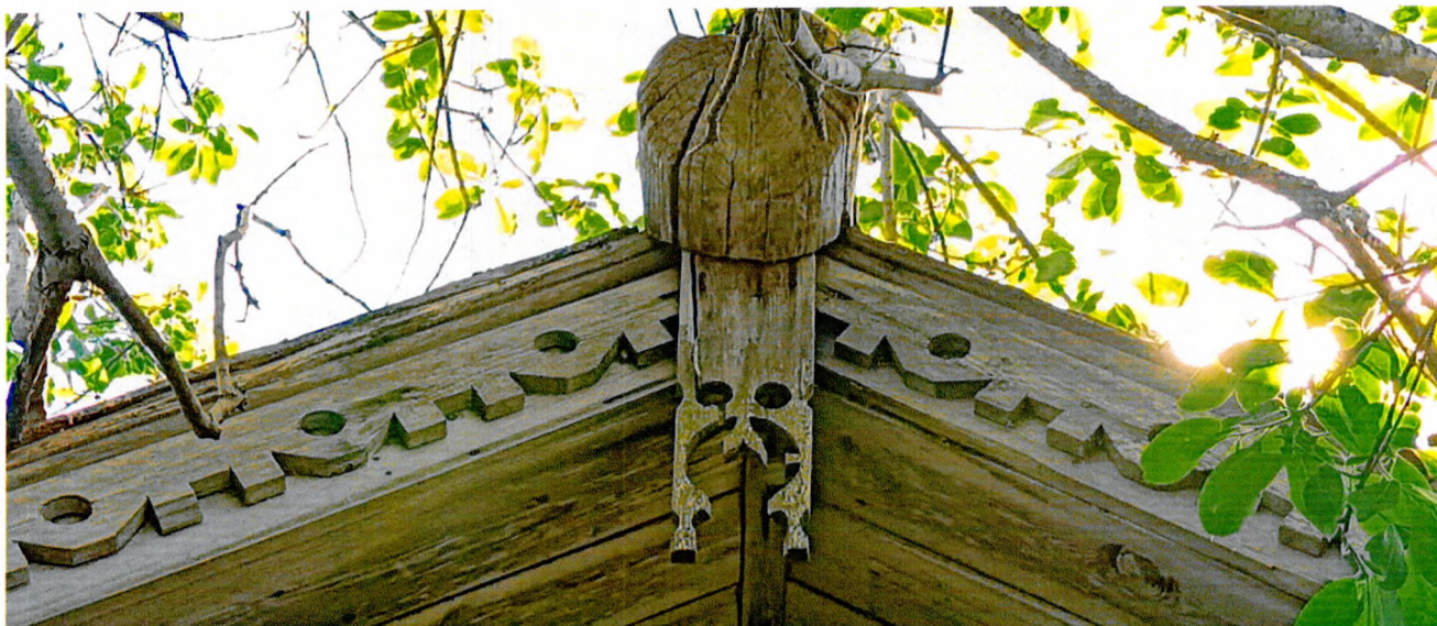
Фото 3. Стык двух скатов кровли по северному фасаду жилой части декорирован деревянным полотенцем с прорезной резьбой (предмет охраны).
