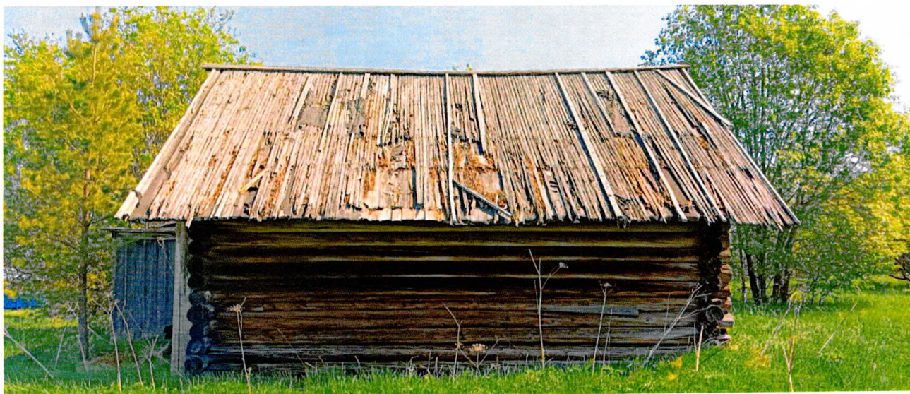
Фото 1. Общий вид восточного фасада хозяйственной части.
