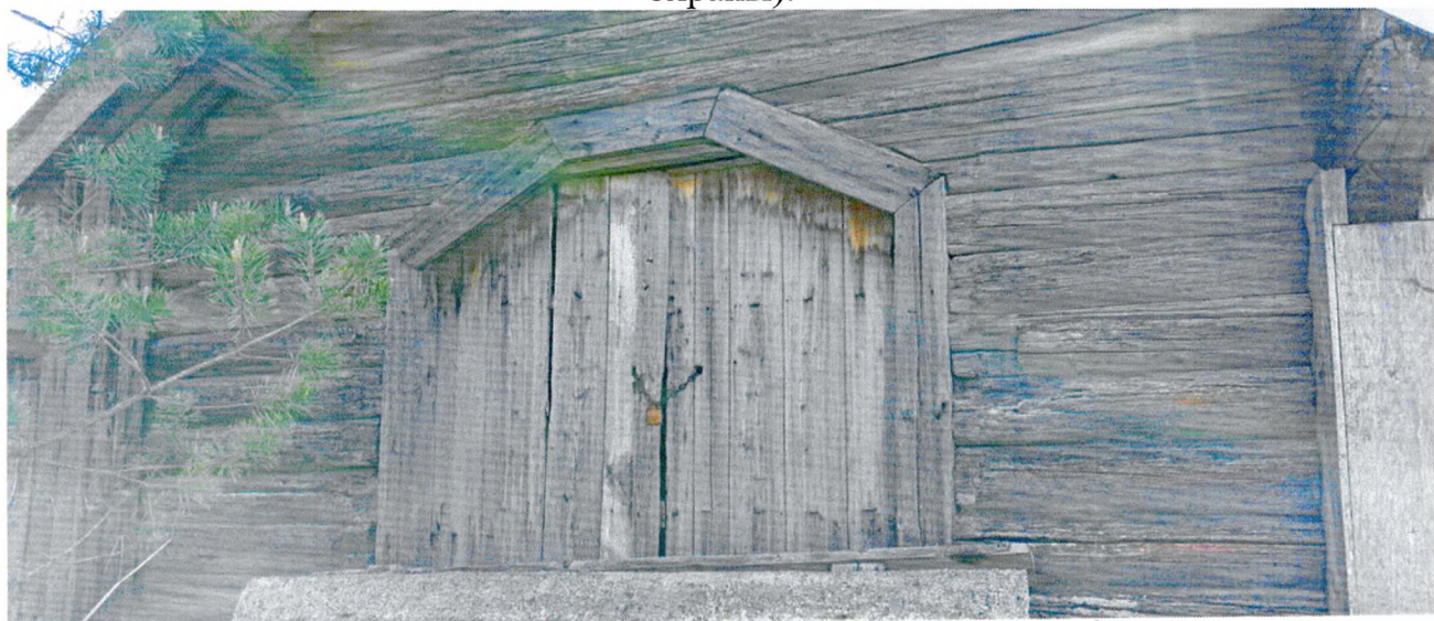
Фото 6. Фрагмент северного фасада хозяйственной части. Въездные ворота трапециевидной формы.
