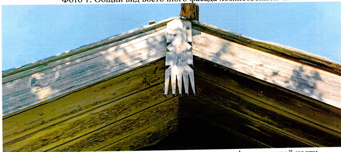
Фото 2. Стык двух скатов кровли по южному фасаду жилой части декорирован простым резным деревянным полотенцем с зубчатым краем (предмет охраны).
