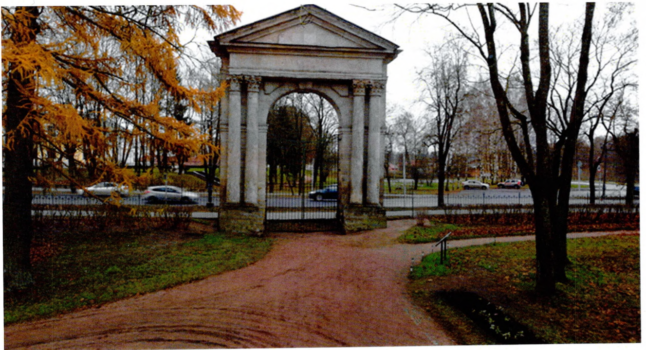
Фото 1. «Адмиралтейские ворота». Общий вид с северо-запада.
