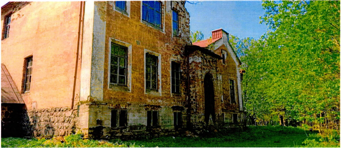
Фото 9. Прилегающая территория к северному фасаду.
