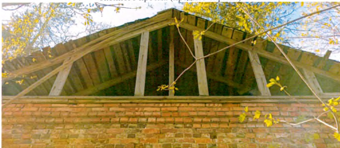
Фото 9. Вид на конструкцию кровли со стороны восточного фасада.
