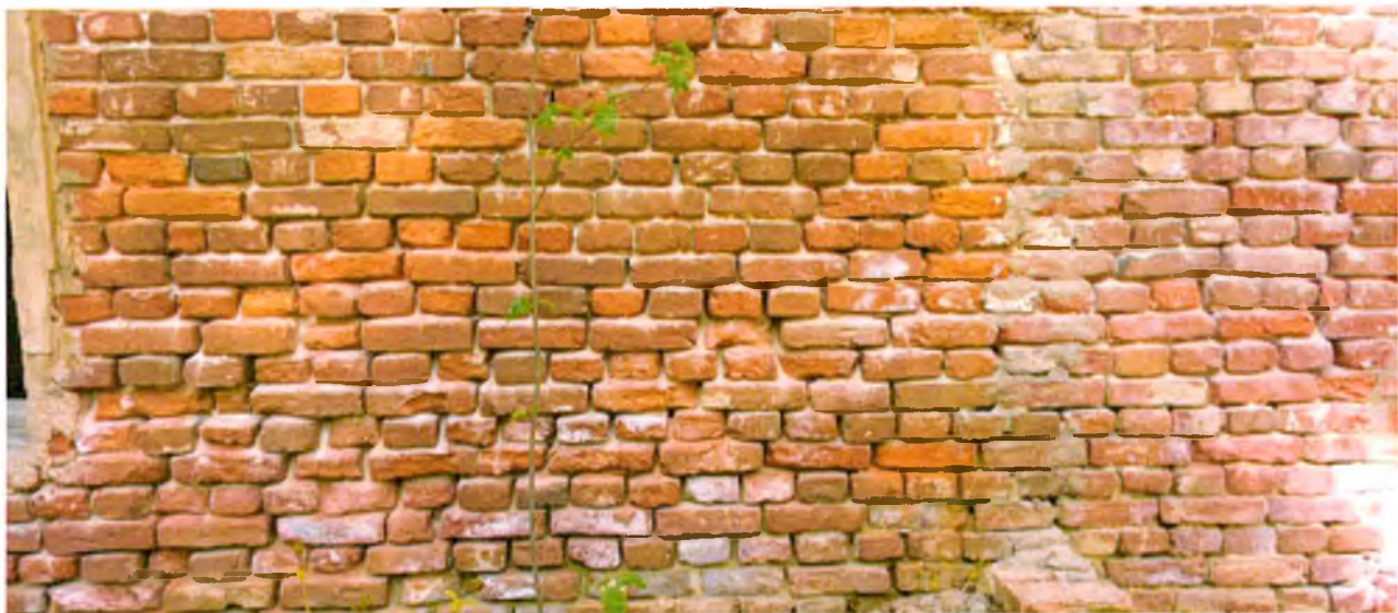
Фото 7. Фрагмент кирпичной кладки южного фасада.
