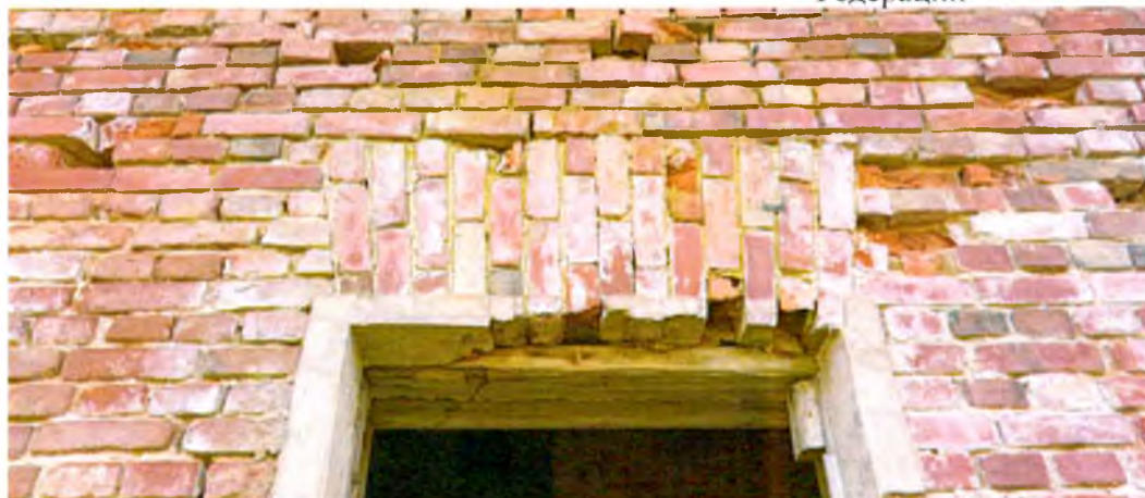
Фото 1. Вид на клинчатую кирпичную перемычку оконного проема северного фасада (предмет охраны).
