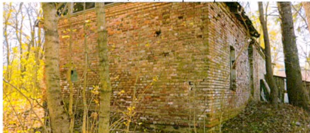
Фото 3. Вид на восточный фасад.
