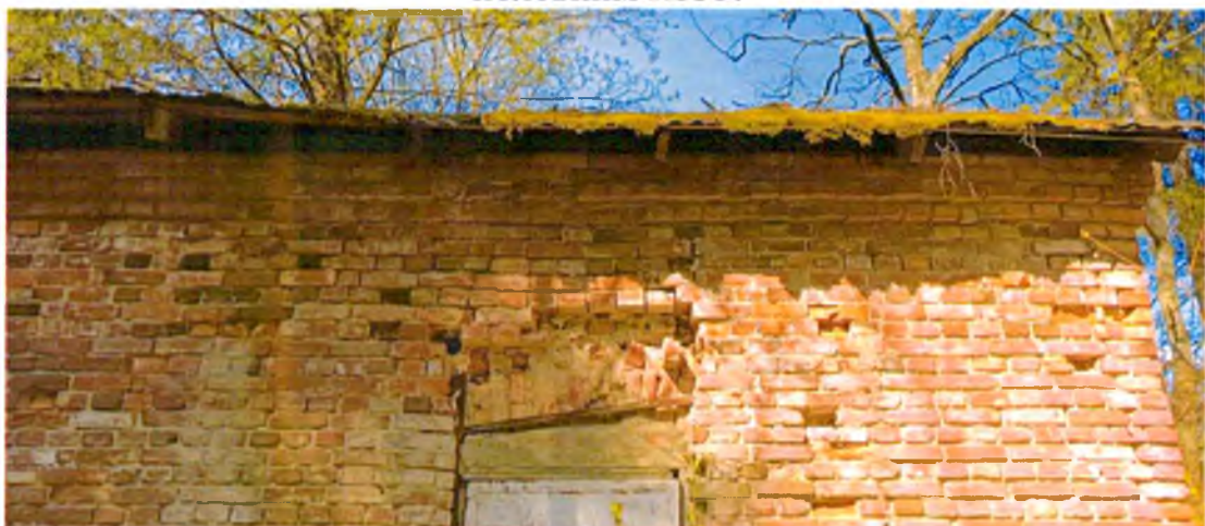
Фото 6. Фрагмент южного фасада. Вид на кирпичную клинчатую перемычку дверного проема (предмет охраны).
