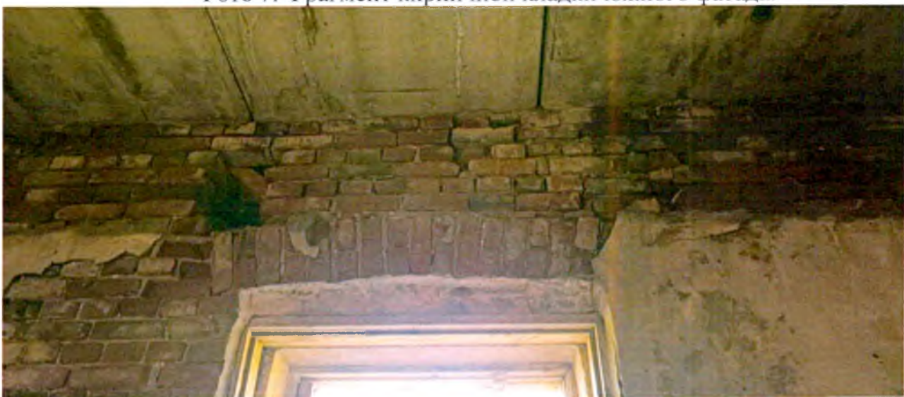
Фото 8. Вид со стороны помещения на клинчатую кирпичную перемычку оконного проема (предмет охраны).
