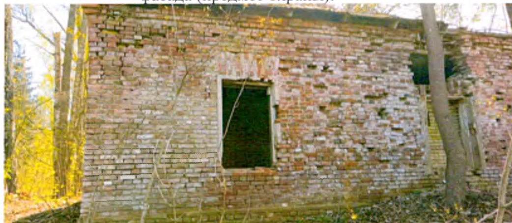
Фото 2. Общий вид северного фасада.
