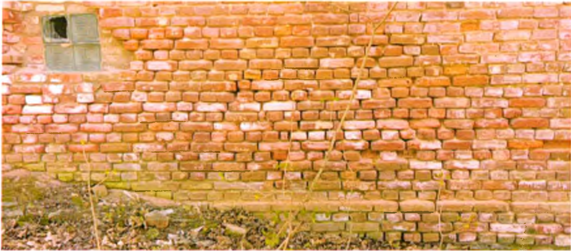
Фото 4. Кирпичная кладка восточного фасада.
