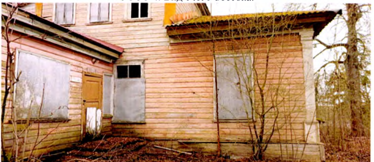
ФОТО 5. Фрагмент восточного фасада.
