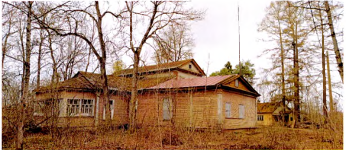
ФОТО 9. Общий вид с юго-востока.
