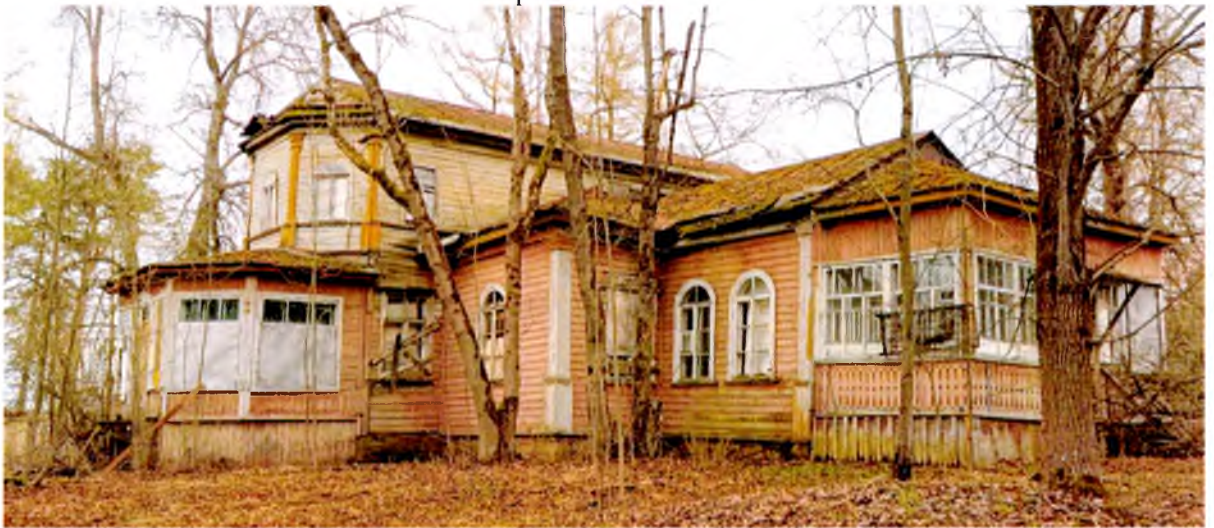
ФОТО 7. Общий вид с юго-запада.
