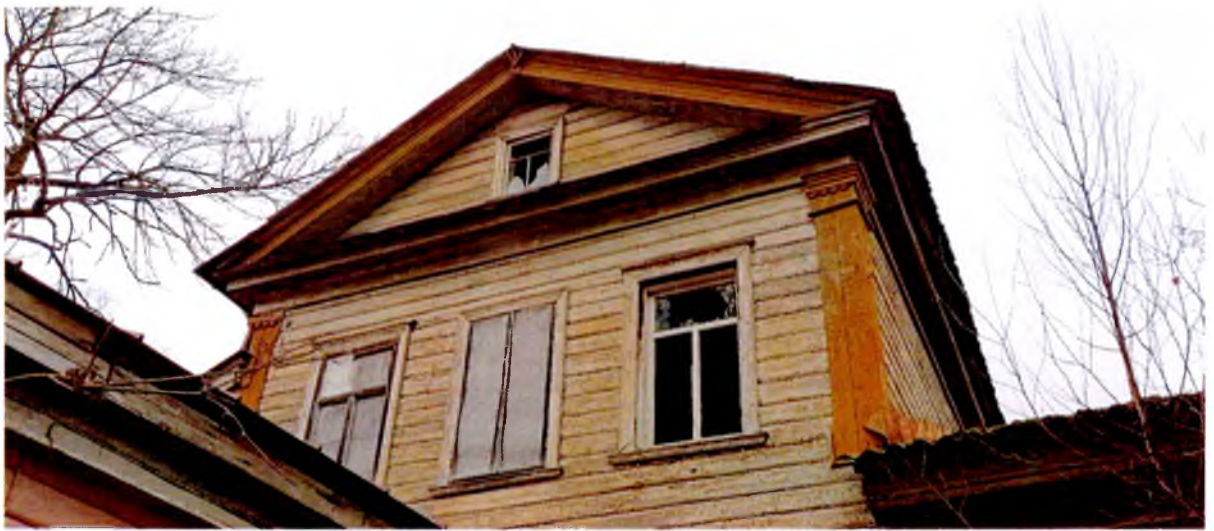
ФОТО 6. Вид с востока на мезонин. Углы декорированы деревянными пилястрами. Треугольный фронтон отделен деревянным профилированным карнизом.
