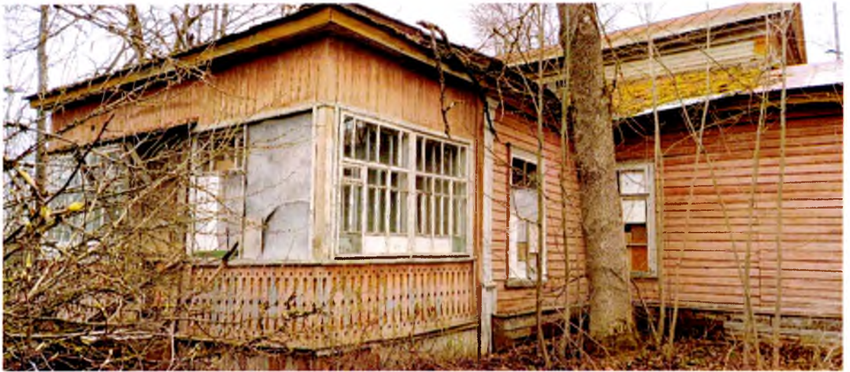
ФОТО 3. Терраса южного фасада. Историческое заполнение оконных проемов с многочастной расстекловкой.
