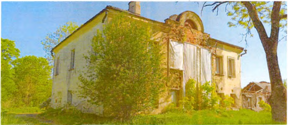
ФОТО 4. Вид с северо-запада.
