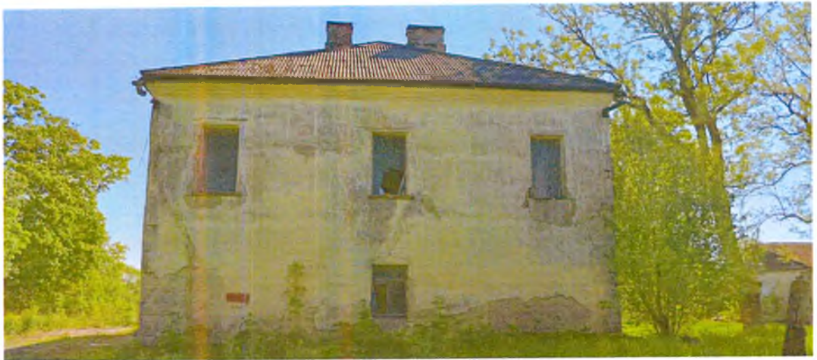
ФОТО 6. Общий вид западного фасада.
