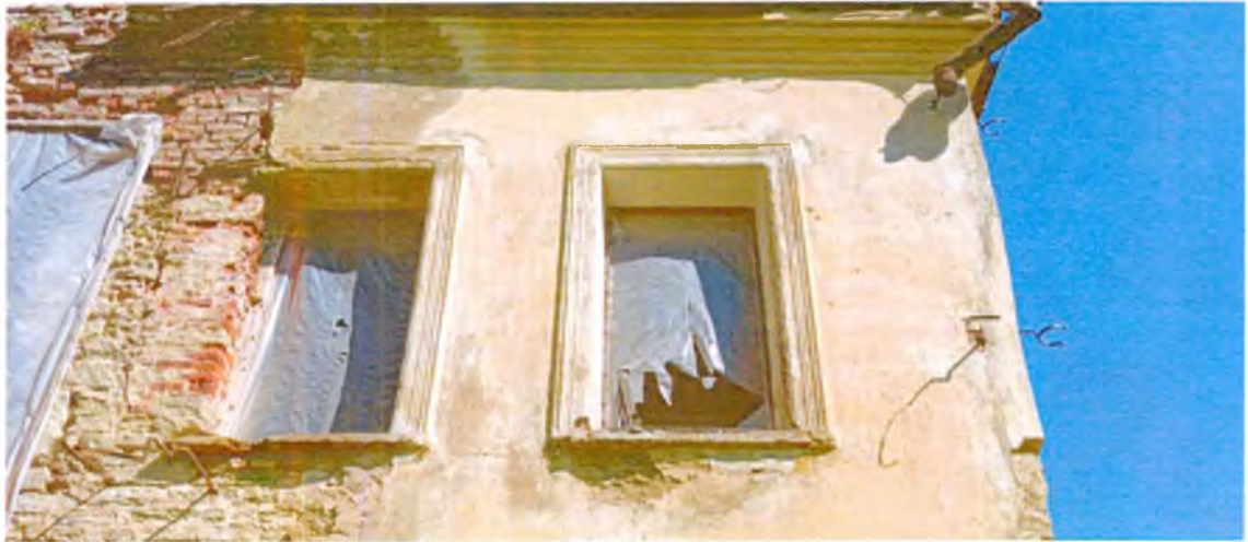
ФОТО 1. Вид на оконные проемы 2 этажа южного фасада. Декор в виде рамочных штукатурных профилированных наличников. Фасад увенчан кирпичным профилированным наличником с оштукатуриванием.
