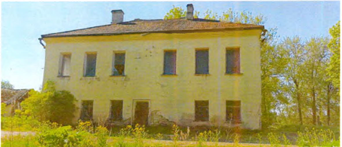
ФОТО 5. Общий вид северного фасада.
