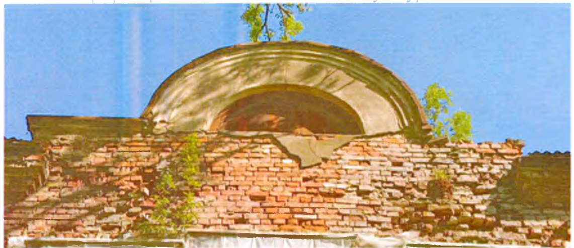
ФОТО 2. Фрагмент южного фасада. Полуциркульный фронтон выполнен из кирпичной кладки с оштукатуриванием.
