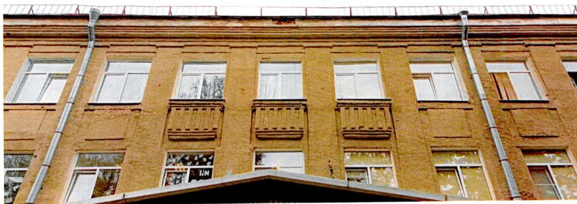
ФОТО 5. Фрагмент южного фасада. Оконные проемы фланкированы пилястрами со штукатурной поверхностью.
