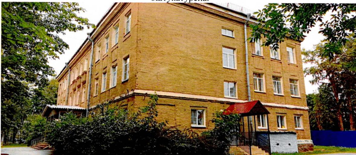
ФОТО 4. Общий вид с юго-востока. Поверхность стен оштукатурена. 1 этаж отделен профилированным карнизом.
