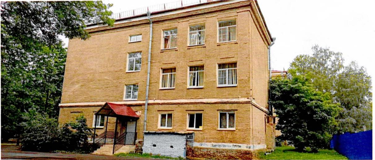
ФОТО 6. Общий вид с северо-востока. Поверхность стен оштукатурена. 1 этаж отделен профилированным карнизом.
