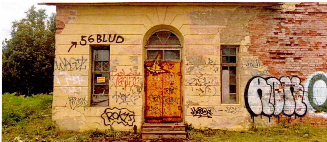
ФОТО 5. Вид на левый флигель. Вход имеет арочное завершение и фланкирован прямоугольными оконными проемами. Заполнение проемов с многочастной расстекловкой. Плоскость фасада декорирована рустом, арочное завершение декорировано веерным рустом.
