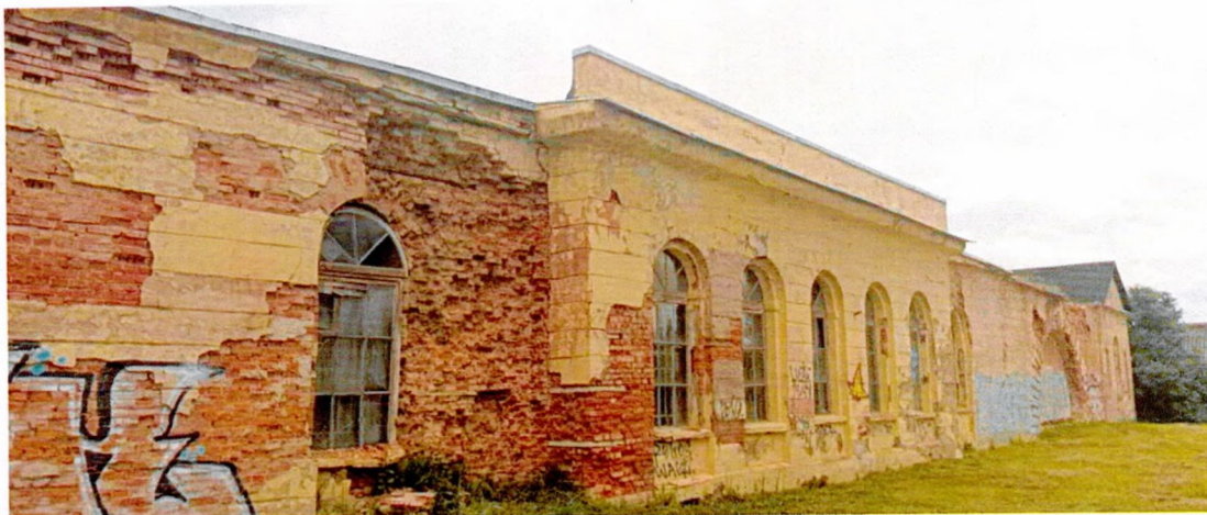
ФОТО 3. Вид на лицевой фасад главного дома. Центральный ризалит в 5 световых осях увенчан карнизом широкого выноса и простым прямоугольным аттиком.
