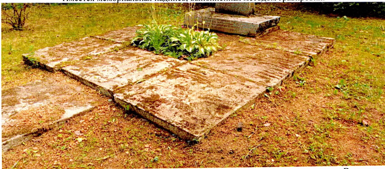
ФОТО 2. Вид на мощение, выполненное из железобетонных квадратных плит. В центре, перед памятником расположена прямоугольная клумба с декоративной растительностью.
