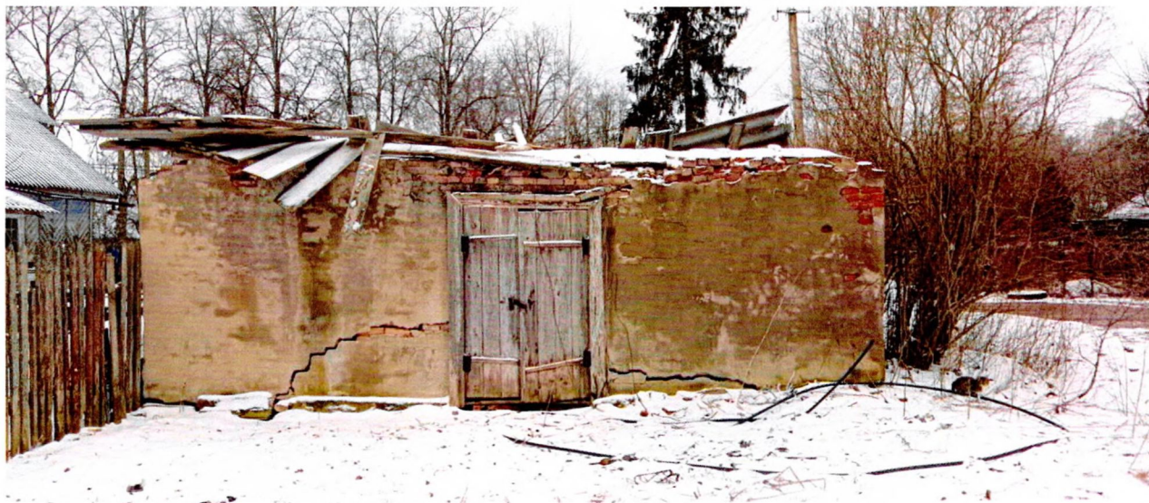
ФОТО 1. Общий вид главного фасада.
