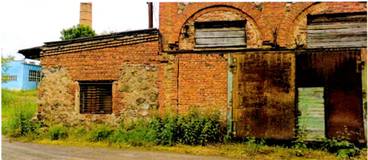
ФОТО 6. Фрагмент северного фасада, вид на восточный одноэтажный корпус. Часть кладки наружных стен выполнена из гранитных валунов на связующем известковом растворе, часть стен представляет собой кирпичную кладку.
