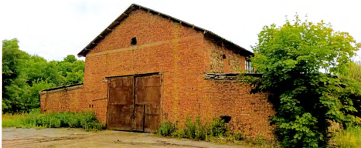
ФОТО 8. Вид на южный фасад. В центральной двухуровневой части располагаются въездные ворота.
