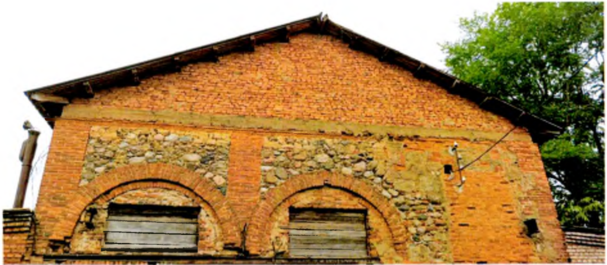
ФОТО 5. Фрагмент северного фасада, вид на фронто́н. Прямоугольные оконные проемы декорированы кирпичными архивольтами. Плоскость фасада имеет текстуру необработанного камня и декорирована кирпичными пилястрами.
