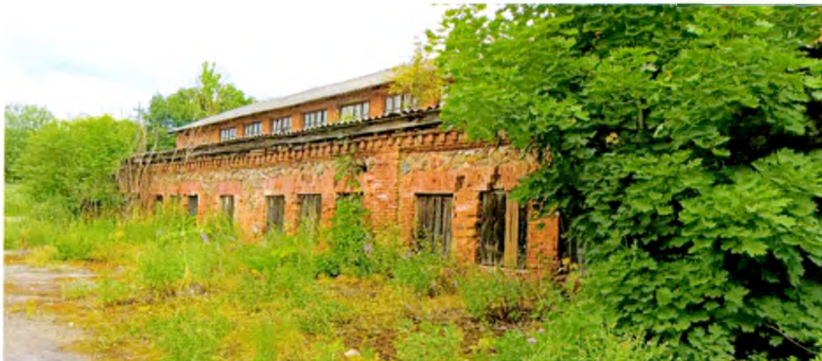
ФОТО 7. Вид на восточный фасад. Боковой корпус одноэтажный, центральная часть имеет оконные проемы во 2 уровне.
