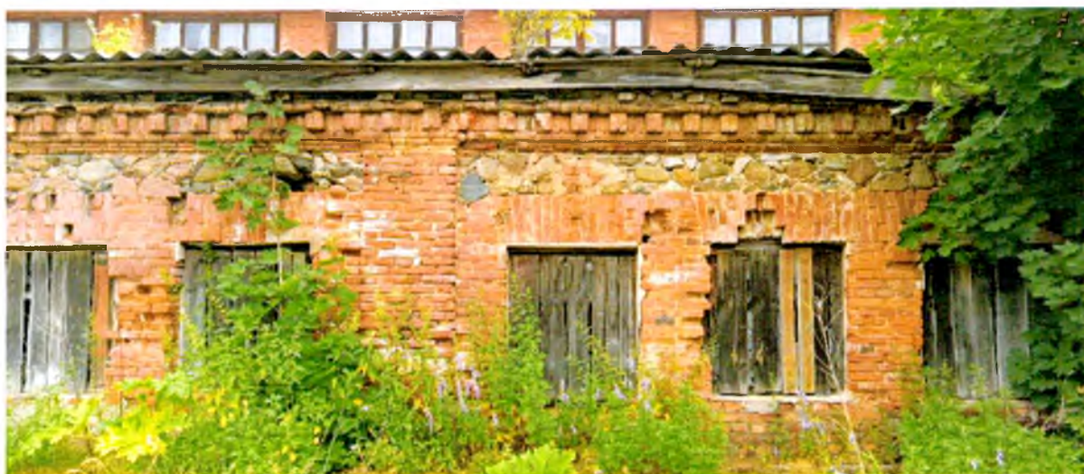
ФОТО 2. Фрагмент западного фасада. Венчающий карниз выполнен из лекального кирпича, прямоугольные оконные проемы имеют клинчатую кирпичную перемычку.
