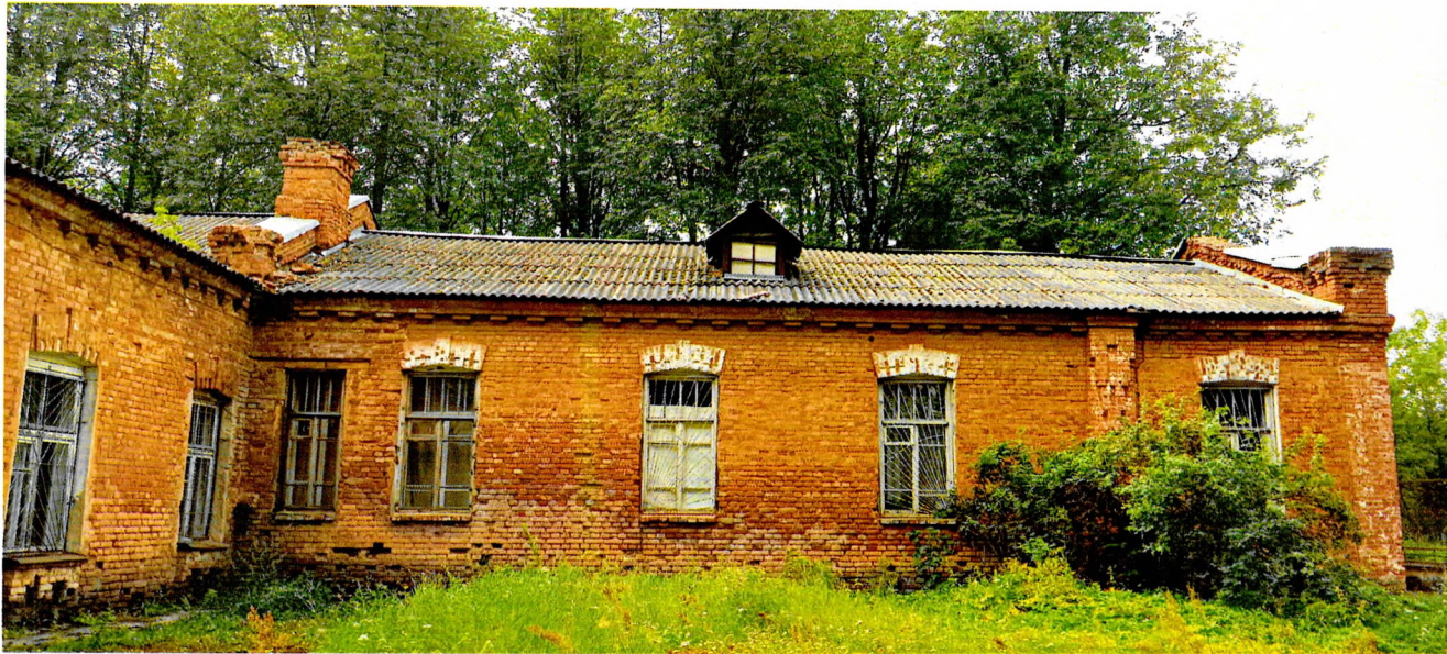
Фото 3. Фрагмент северного фасада, западное крыло. Плоскость фасада делит выступающая из плоскости кирпичная пилястра с декоративным элементом. Оконные проемы декорированы сандриком с замковым камнем
