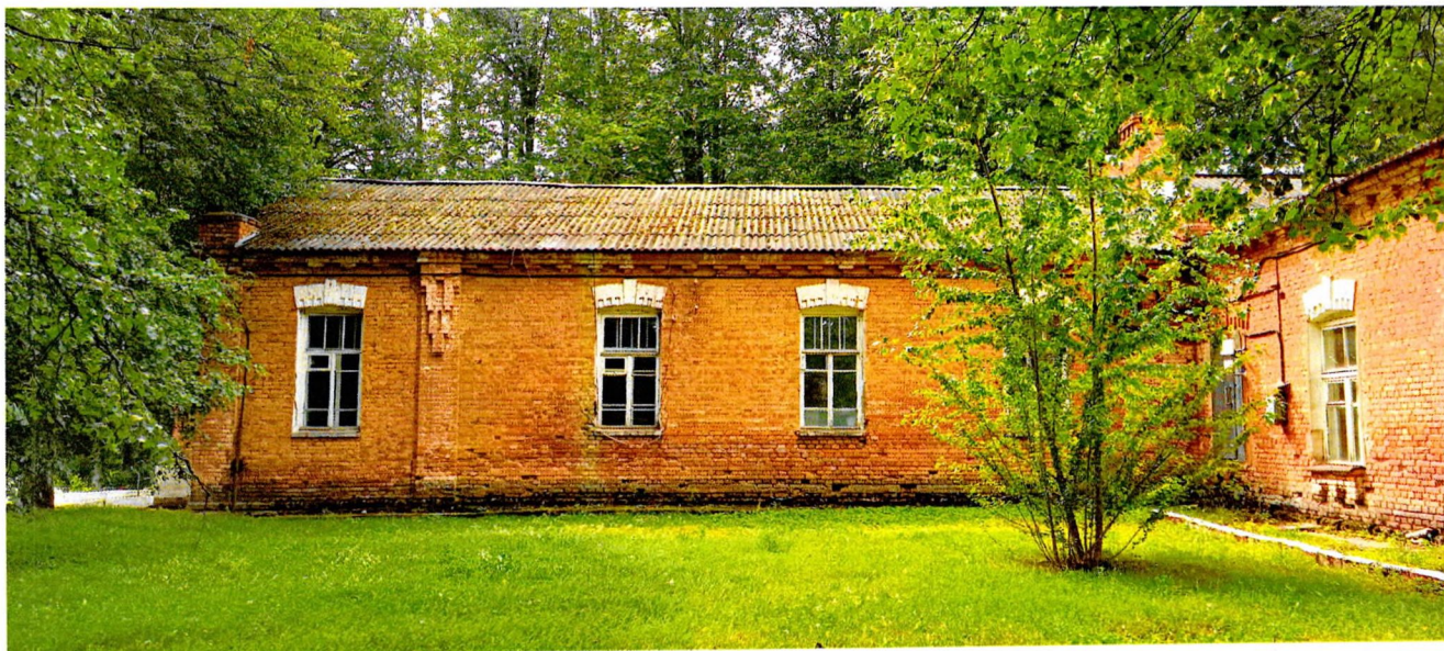
Фото 2. Фрагмент северного фасада, восточное крыло. Плоскость фасада делит выступающая из плоскости кирпичная пилястра с декоративным элементом. Оконные проемы декорированы сандриком с замковым камнем.
