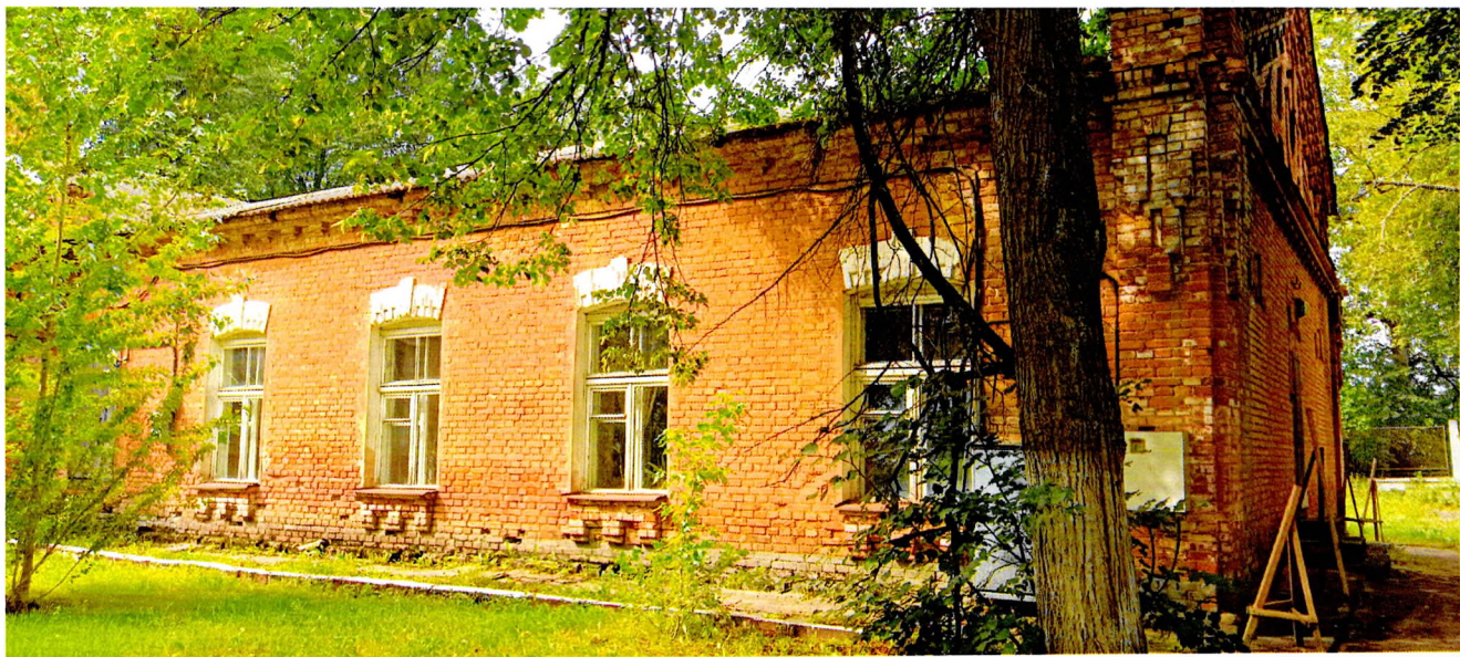
Фото 4. Фрагмент восточного фасада. Сохранилась историческая расстекловка деревянных заполнений оконных проемов
