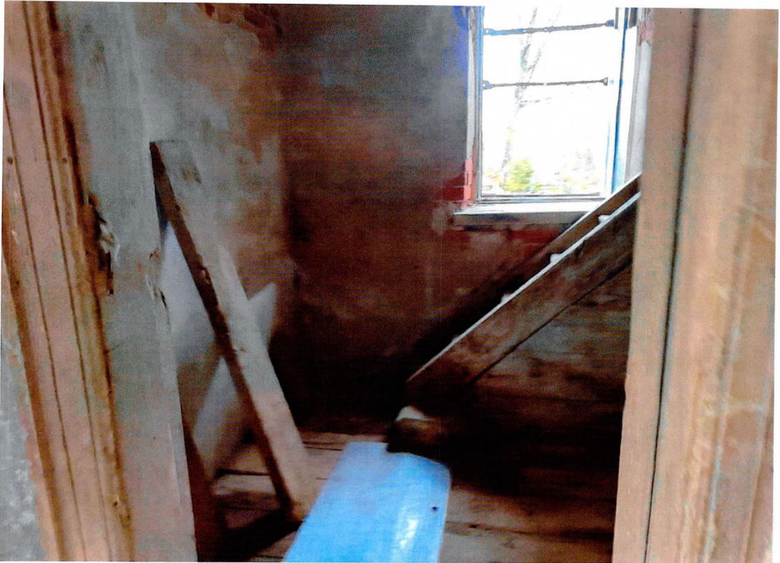
Фото 30. «Церковь Преображенья», деревянная лестница ведущая на второй ярус колокольни.
