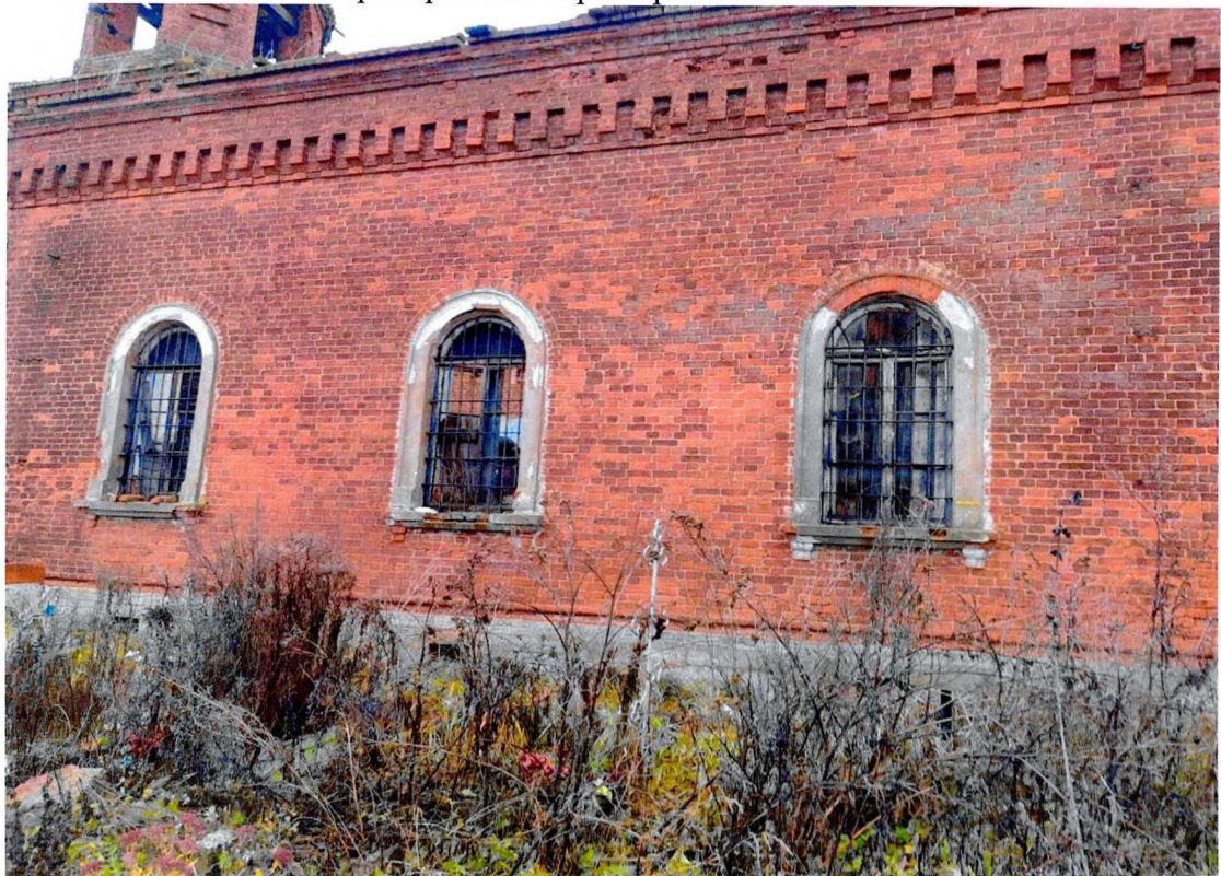
Фото 11. «Церковь Преображенья», южный фасад здания.
