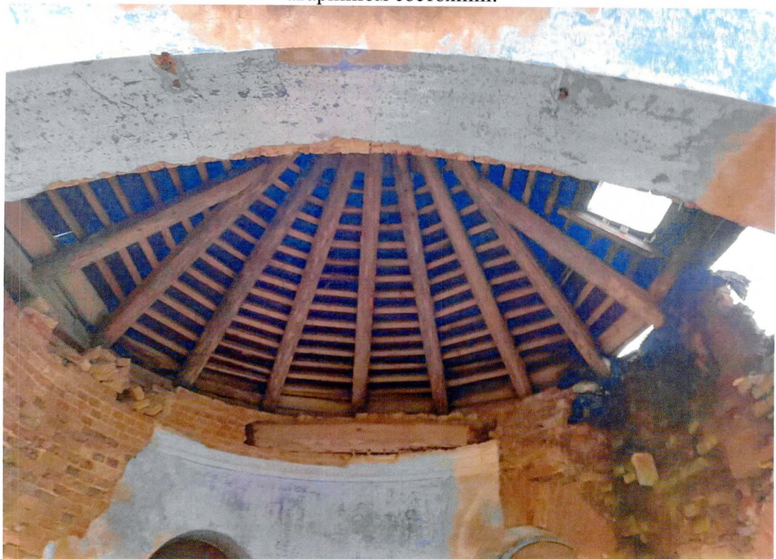
Фото 23. «Церковь Преображенья», деревянная стропильная система апсиды.
