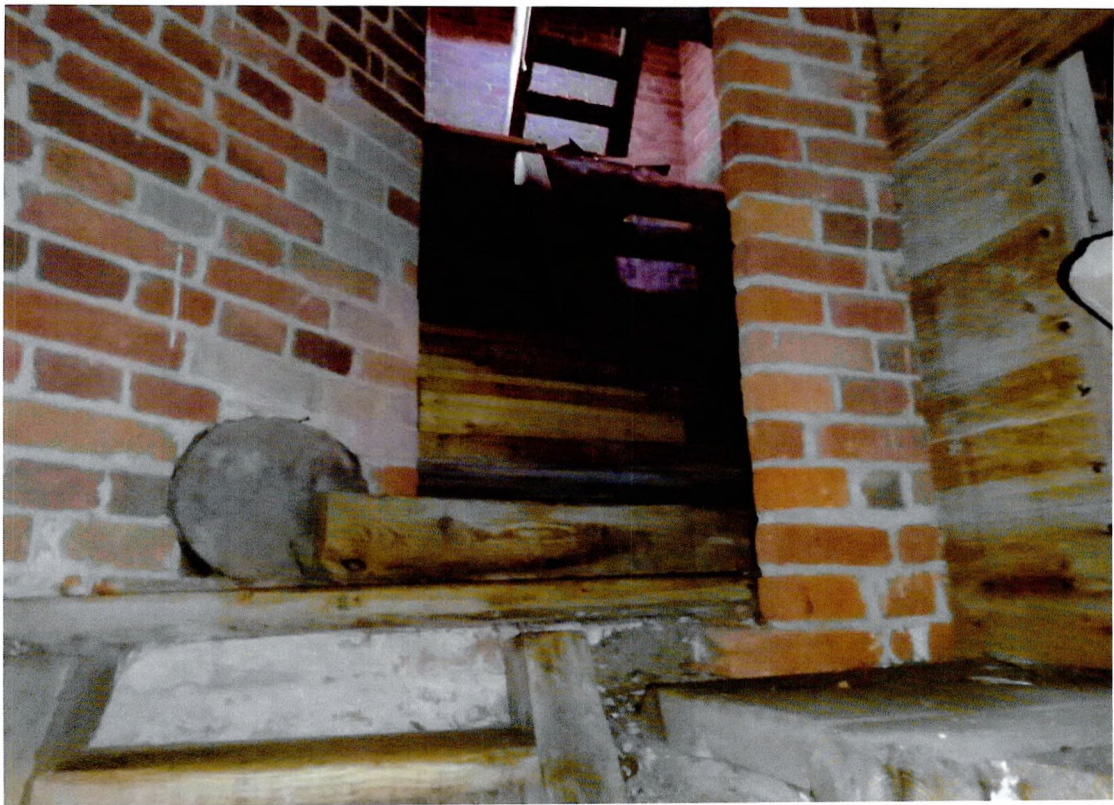
Фото 31. «Церковь Преображенья», деревянная лестница ведущая на второй ярус колокольни.
