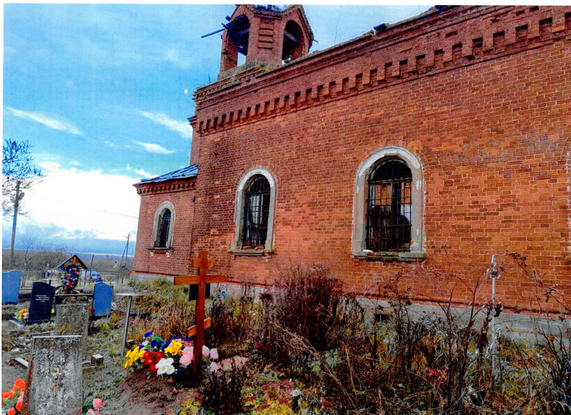
Фото 12. «Церковь Преображенья», южный фасад здания.
