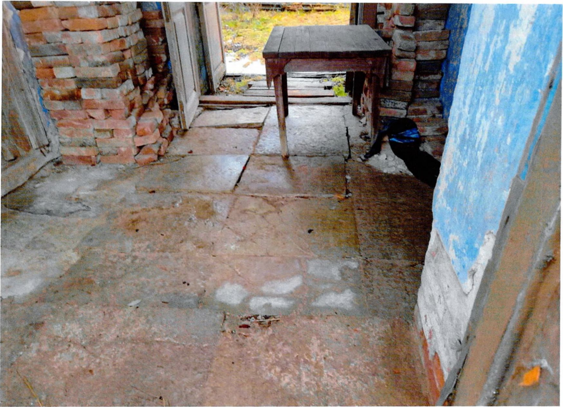
Фото 14. «Церковь Преображенья», лещадные плиты на полу в колокольне.
