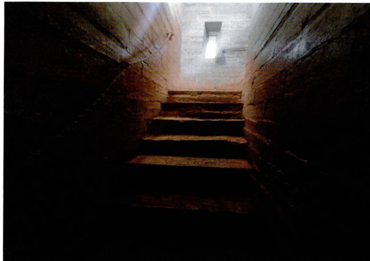
Фото 15. Вид на внутрстенную лестницу.
