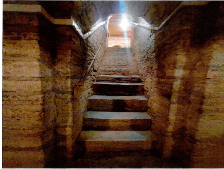
Фото 5. Вид на внутрстенную лестницу.
