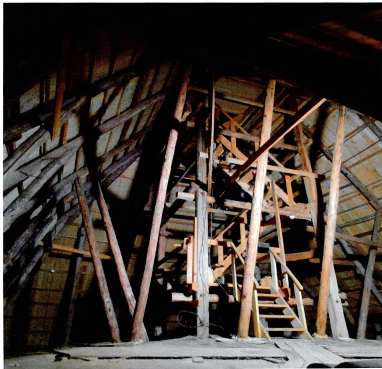
Фото 8. Вид стропильной системы.
