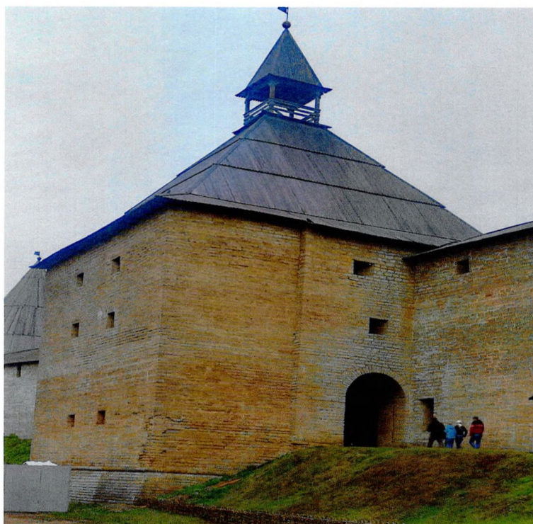
Фото 1. Вид на юго-западный угол башни.
