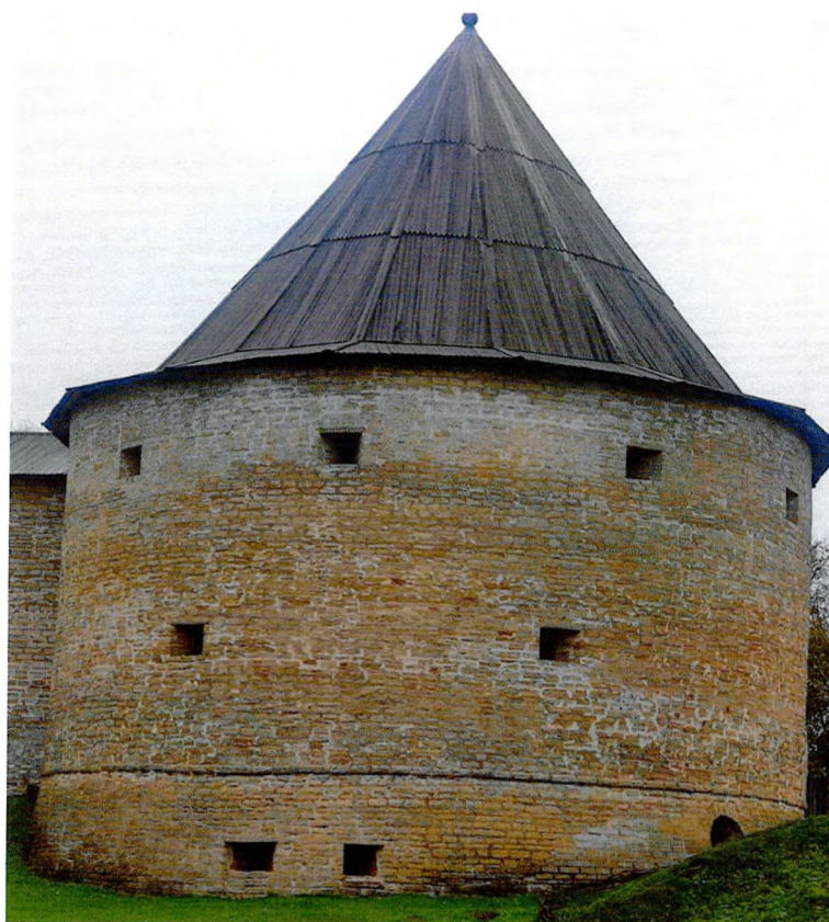
Фото 32. Вид на западный фасад.
