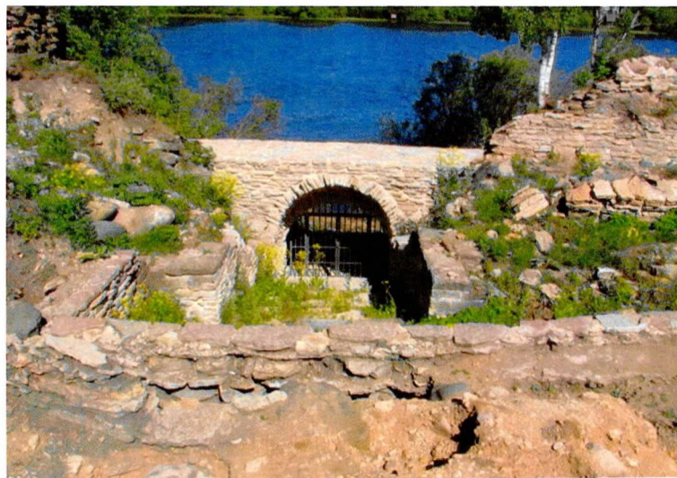
Фото 21. Вид с запада. Нижний марш и восстановленные части сводов лестницы.
