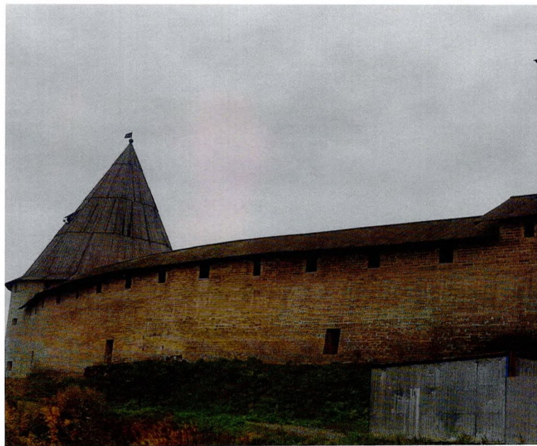
Фото 11. Вид на западный фасад.
