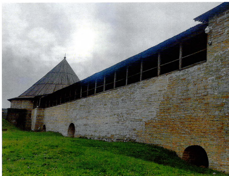
Фото 9. Вид на восточный фасад.
