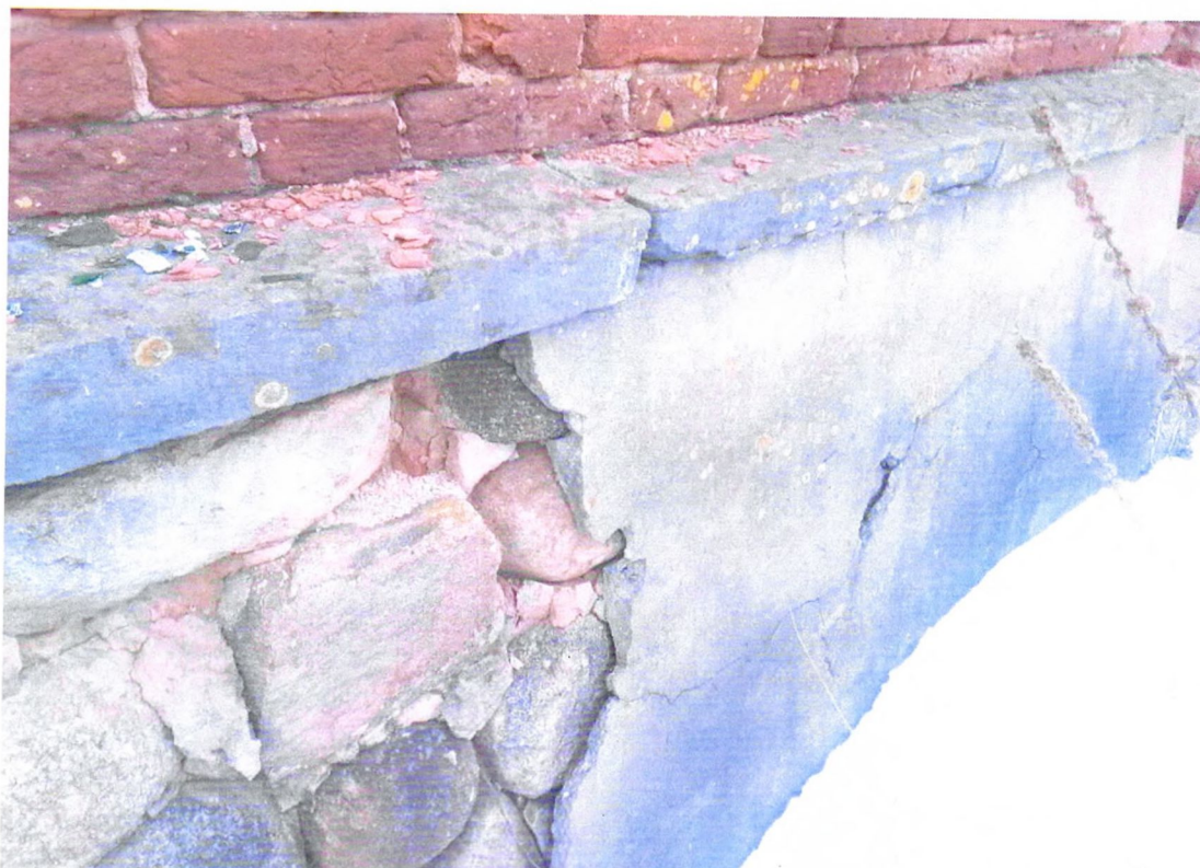
Фото 11. Фрагмент восточного фасада. Штукатурная отделка валунной кладки.
