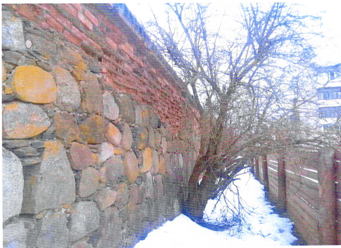
Фото 16. Фрагмент северного фасада. Валунная кладка.
