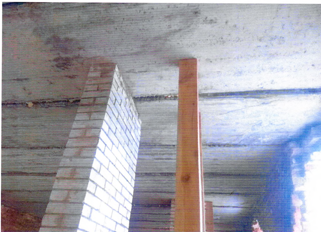
Фото 19. Внутреннее помещение. Усиление покрытия.
