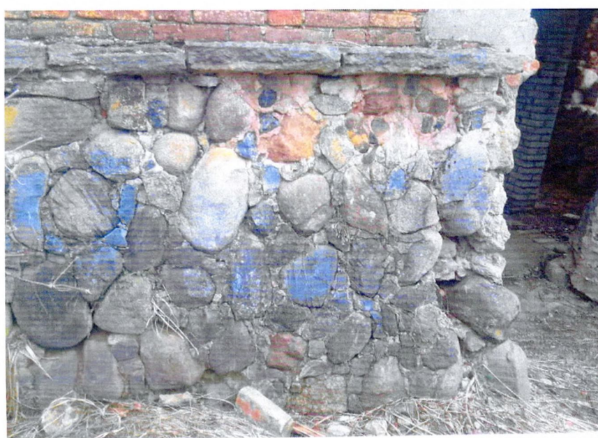
Фото 2. Фрагмент западного фасада. Валунная кладка с выступающим поясом.
