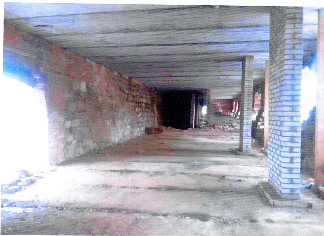
Фото 17. Общий вид внутренних помещений западной части здания.
