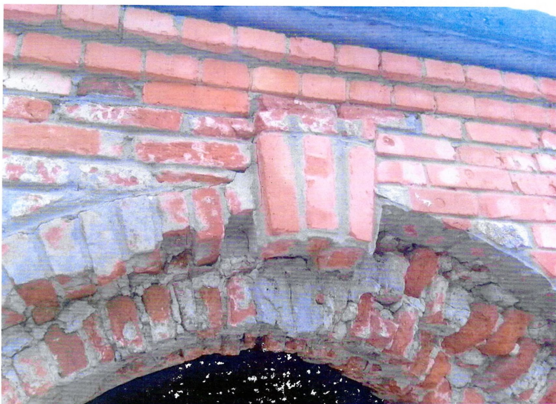
Фото 12. Фрагмент восточного фасада. Замковый камень арочного дверного проема.
