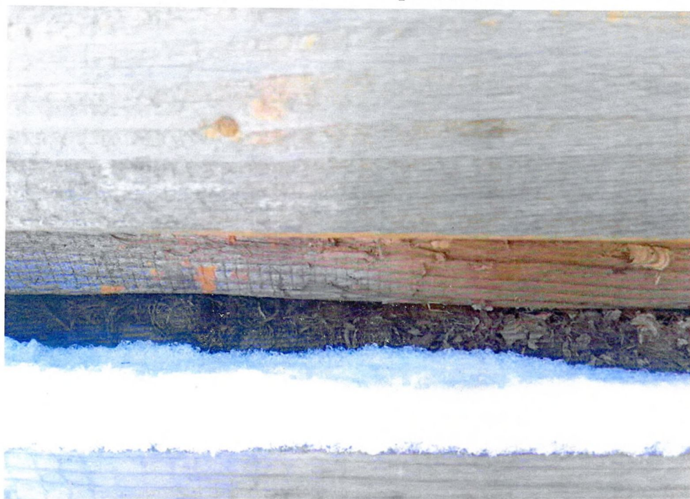
Фото 10. Фрагмент восточного фасада. На участке просматривается слежавшийся межвенцовый волокнистый утеплитель.
