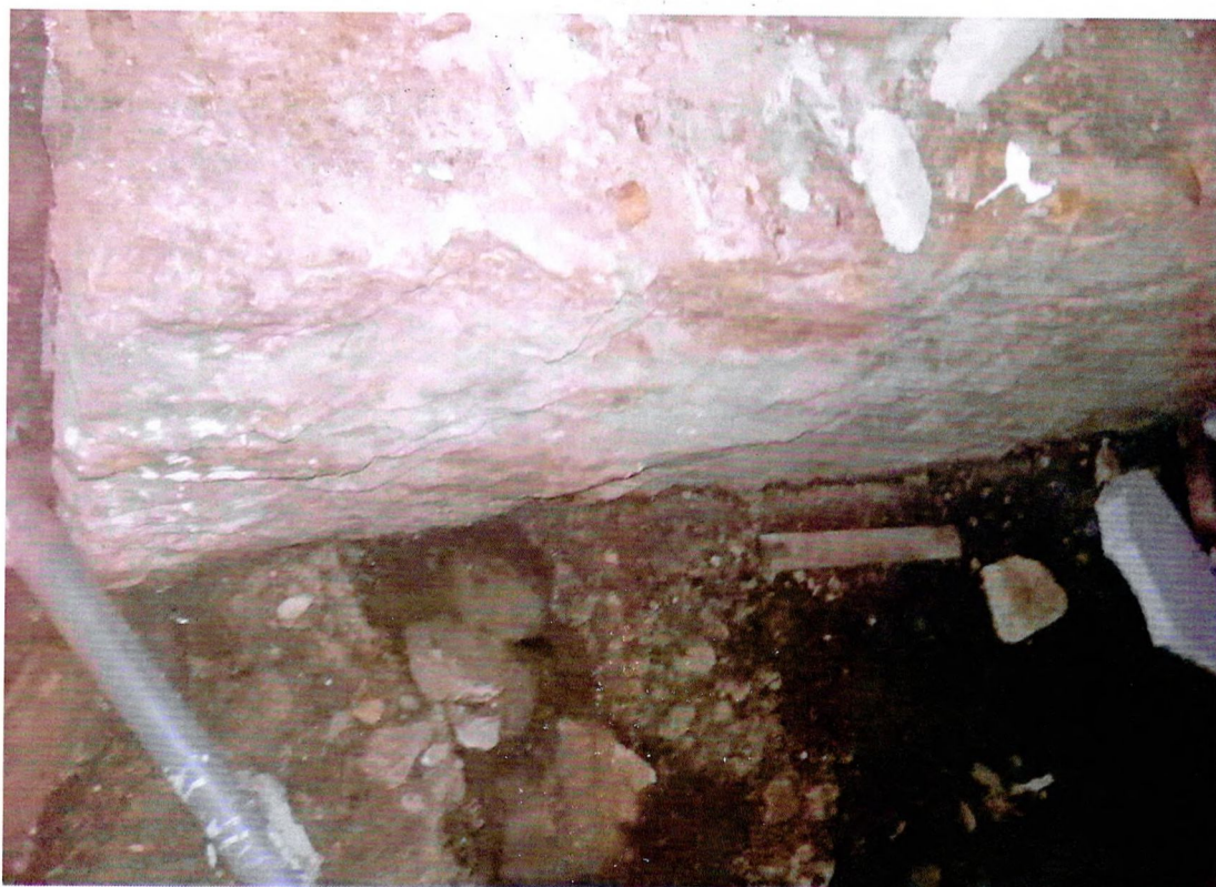
Фото 39. Внутреннее помещение. Участок ленточного кирпичного фундамента.
