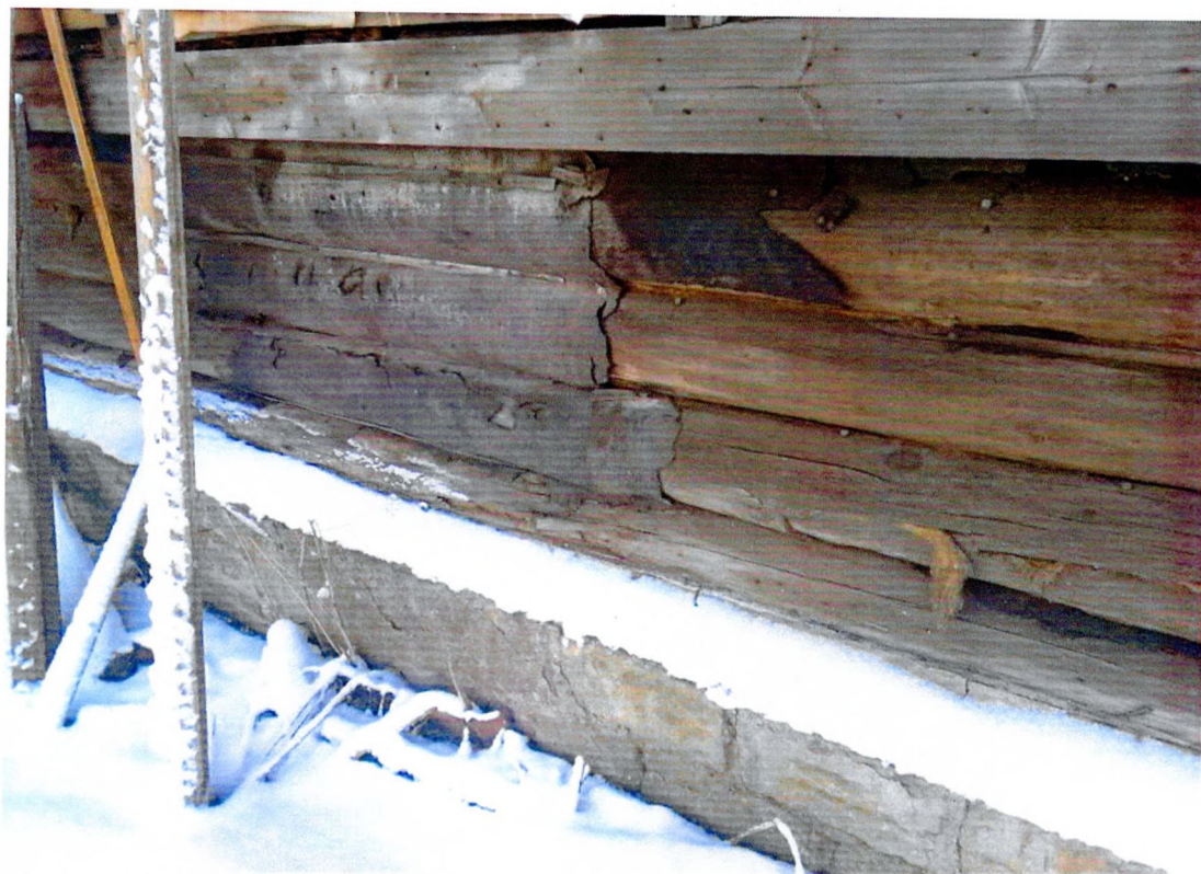
Фото 19. Фрагмент южного фасада. Утрата наружной обшивки. Нарушение конопатки стены, растрескивание древесины венцов.
