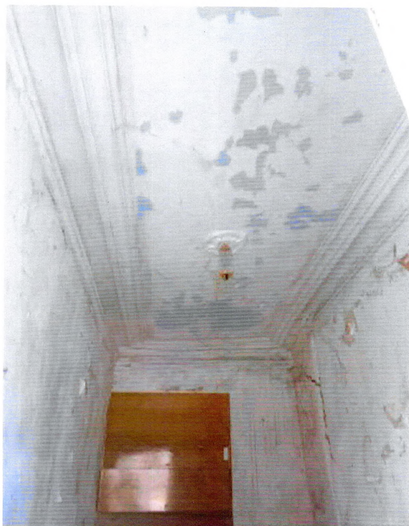
Фото 41. Внутреннее помещение. Сохранившаяся лепнина на потолке.
