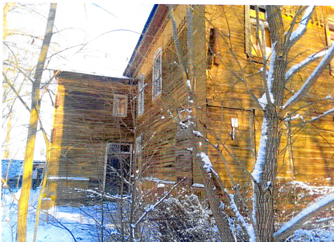
Фото 4. Общий вид северного фасада.
