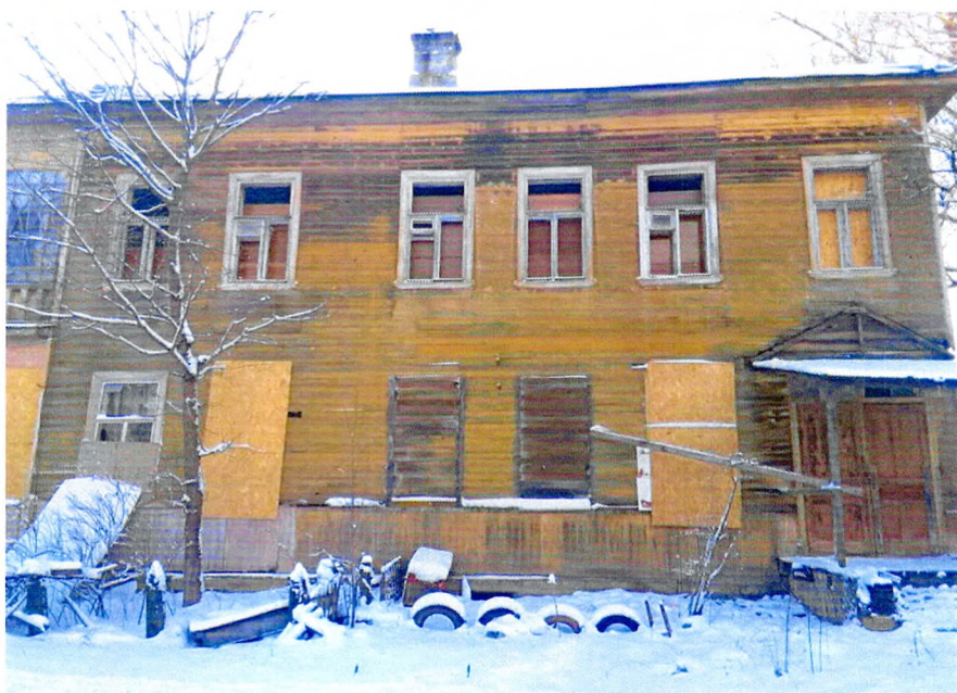
Фото 1. Общий вид восточного фасада.
