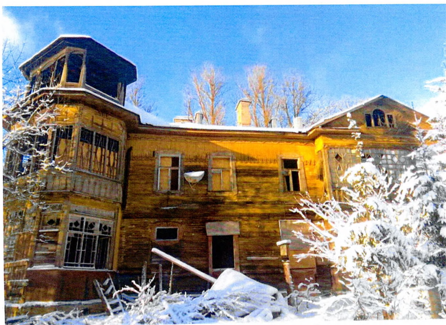
Фото 2. Общий вид южного фасада.
