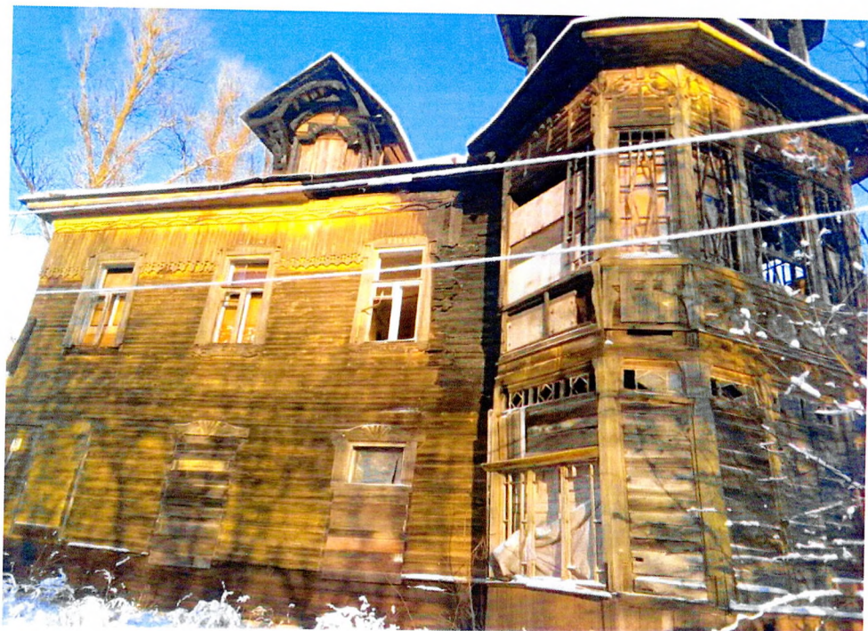
Фото 3. Общий вид западного фасада.
