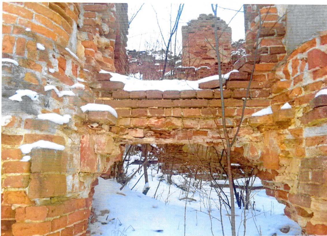
Фото 12. «Главный дом, нач. XIX». Фрагмент восточного фасада. Разрушение перемычек оконных проемов подполья.
