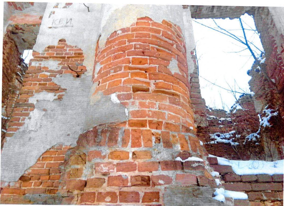
Фото 11. «Главный дом, нач. XIX». Фрагмент восточного фасада. Разрушение штукатурного слоя. Морозная деструкция кирпичной кладки колонн.
