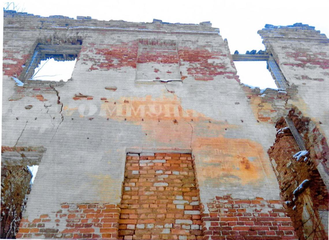
Фото 19. «Главный дом, нач. XIX». Фрагмент северного фасада. Сквозные трещины над оконными проемами первого этажа.
