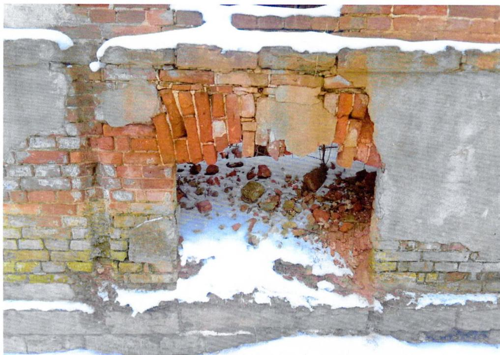
Фото 16. «Главный дом, нач. XIX». Фрагмент северного фасада. Разрушение кирпичной перемычки оконного проема подполья. Биоповреждение кладки.
