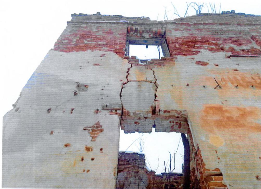
Фото 17. «Главный дом, нач. XIX». Фрагмент северного фасада. Вертикальные сквозные трещины над оконным проемом первого этажа.
