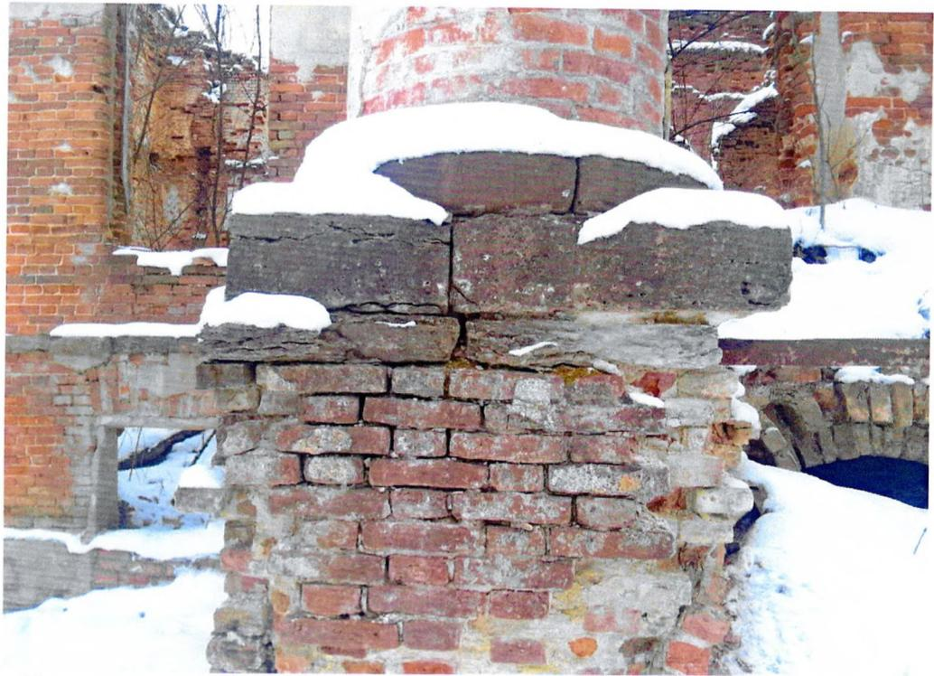
Фото 23. «Главный дом, нач. XIX». Фрагмент западного фасада. Разрушение базы колонны. Выветривание шовного раствора в кирпичной кладке стереобата.
