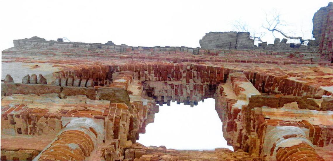
Фото 9. «Главный дом, нач. XIX». Фрагмент восточного фасада. Разрушение арочной перемычки над трехчастным оконным проемом второго этажа, выпадение кирпичей. Выпадение кирпичей из венчающего карниза. Разрушение и утраты карнизных плит.
