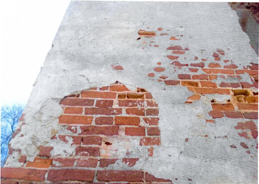
Фото 6. «Главный дом, нач. XIX». Фрагмент восточного фасада. Разрушение штукатурного слоя. Морозная деструкция кирпичной кладки стены.
