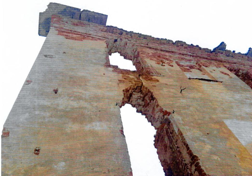
Фото 30. «Главный дом, нач. XIX». Фрагмент южного фасада. Вертикальная сквозная трещина над оконным проемом первого этажа. Разрушение перемычек. Разрушение карнизных плит.
