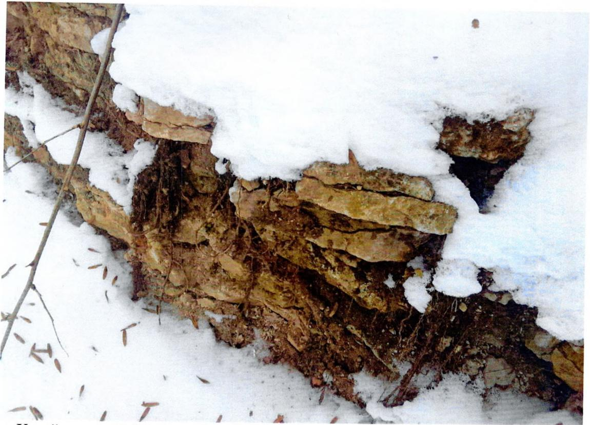
Фото 61. «Хозяйственный (кавалерийский) корпус, нач. XIXв.». Фрагмент юго-восточного фасада. Прорастание растений, биоповреждения, расслоение кладки цокольной части.
