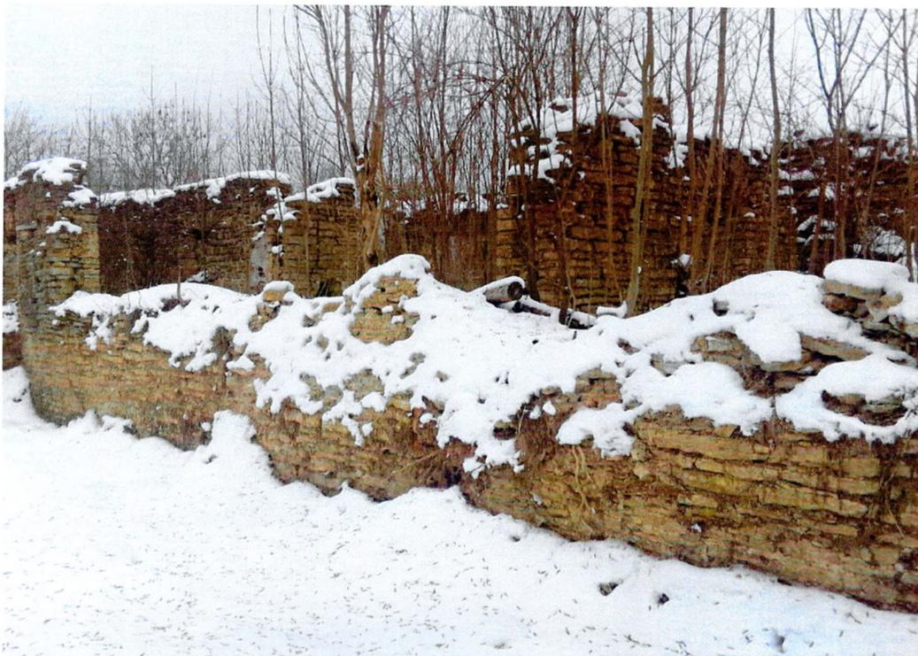
Фото 64. «Хозяйственный (кавалерийский) корпус, нач. XIXв.». Фрагмент южного фасада. Разрушение верхней части стены.
