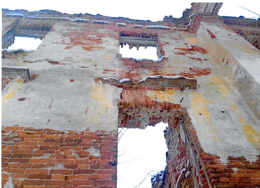
Фото 22. «Главный дом, нач. XIX». Фрагмент западного фасада. Разрушение штукатурного слоя стен. Сквозная трещина над оконным проемом первого этажа. Разрушение сандрика над оконным проемом первого этажа.
