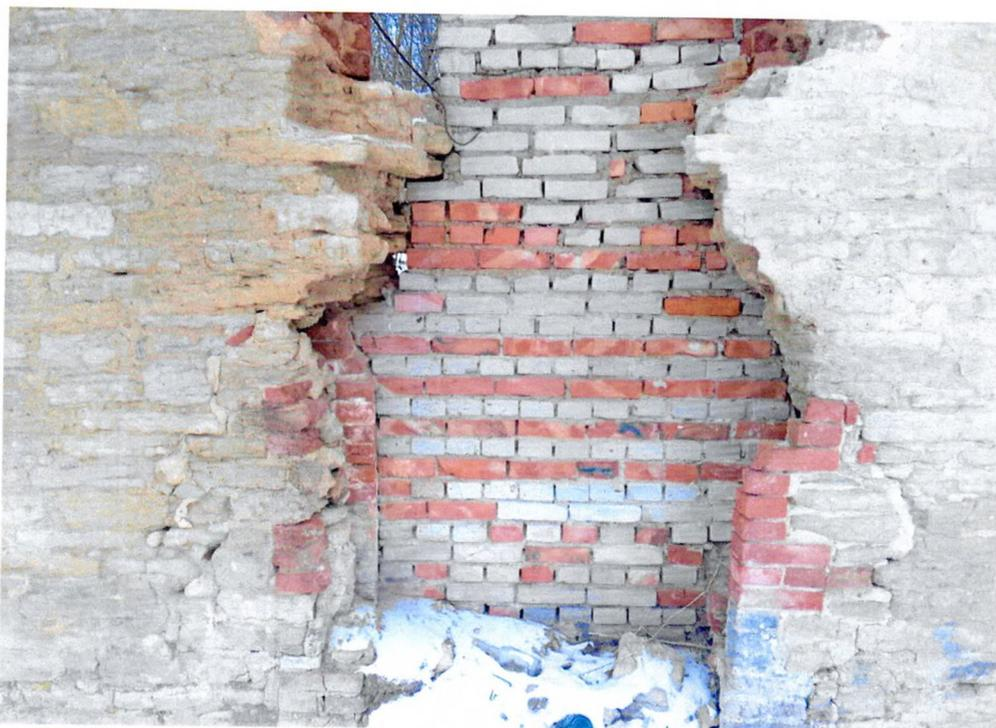
Фото 41. «Конюшня с каретником, нач. XIX в.». Фрагмент восточного фасада. Полное разрушение оконной перемычки. Проем заложен керамическим и силикатным кирпичом на цементно-песчаном растворе.
