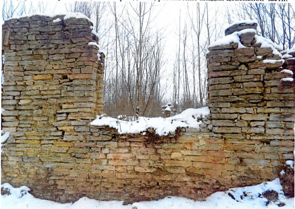
Фото 62. «Хозяйственный (кавалерийский) корпус, нач. XIXв.». Фрагмент южного фасада. Утрата перемычки оконного проема.
