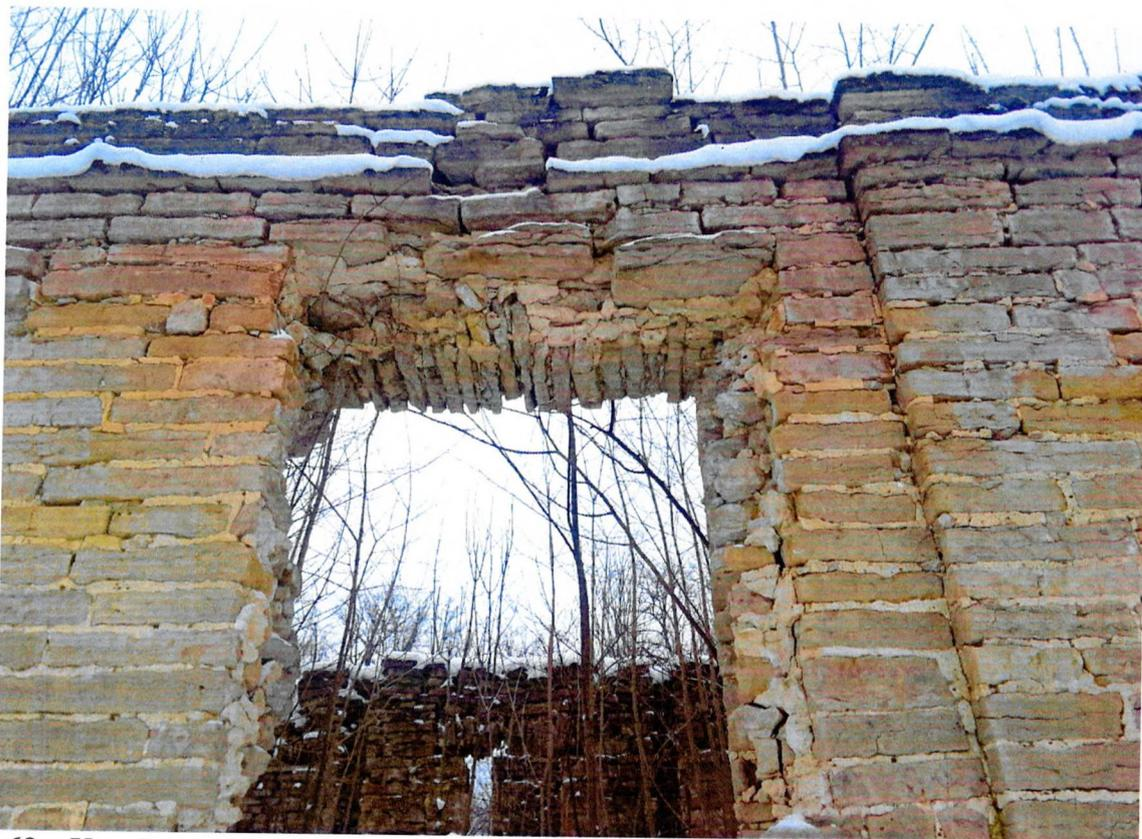
Фото 69. «Хозяйственный (кавалерийский) корпус, нач. XIXв.». Фрагмент северного фасада. Деструкция кладки клинчатой перемычки.
