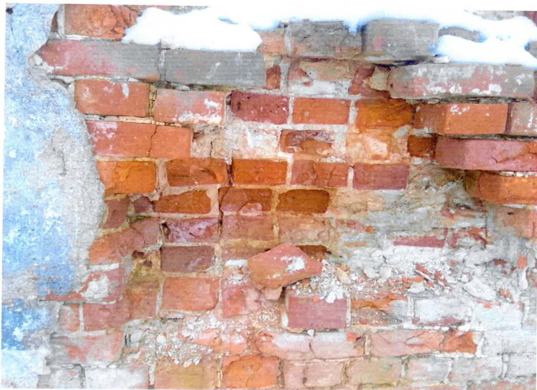
Фото 7. «Главный дом, нач. XIX». Фрагмент восточного фасада. Разрушение наружного слоя кладки на глубину в один кирпич.
