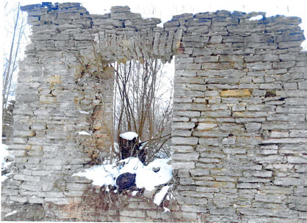
Фото 63. «Хозяйственный (кавалерийский) корпус, нач. XIXв.». Фрагмент южного фасада. Расслоение кладки клинчатой перемычки оконного проема. Прорастание кустарников в подоконной зоне.
