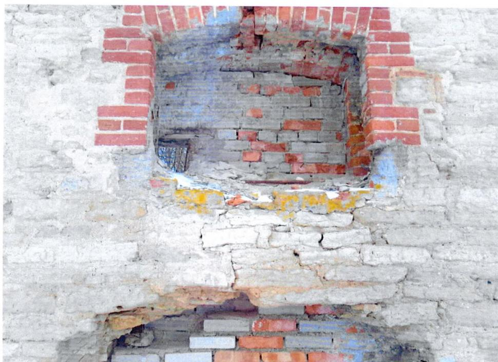
Фото 42. «Конюшня с каретником, нач. XIX в.». Фрагмент восточного фасада. Трещина по швам кладки из известняка под оконным проемом. Выпадение кирпича из замковой части лучковой перемычки оконного проема.
