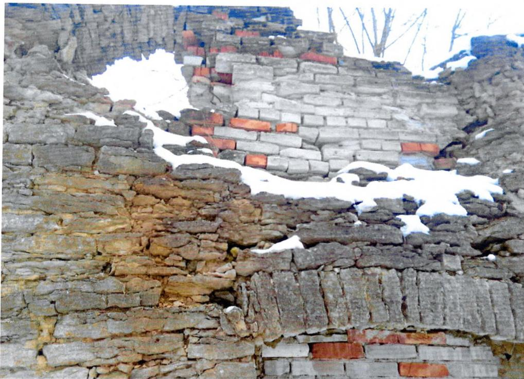
Фото 53. «Конюшня с каретником, нач. XIX в.». Фрагмент юго-восточного фасада. Разрушение арочной перемычки оконного проема. Деструкция кладки в подоконной зоне. Проемы заложены керамическим и силикатным кирпичом на цементно-песчаном растворе.
