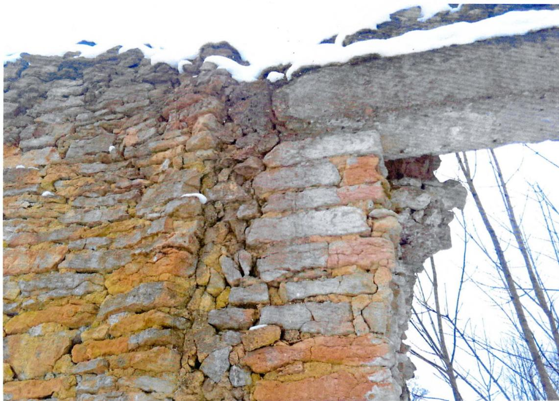
Фото 44. «Конюшня с каретником, нач. XIX в.». Фрагмент северного фасада. Расслоение кладки из известняка в зоне опирания перемычки дверного проема.
