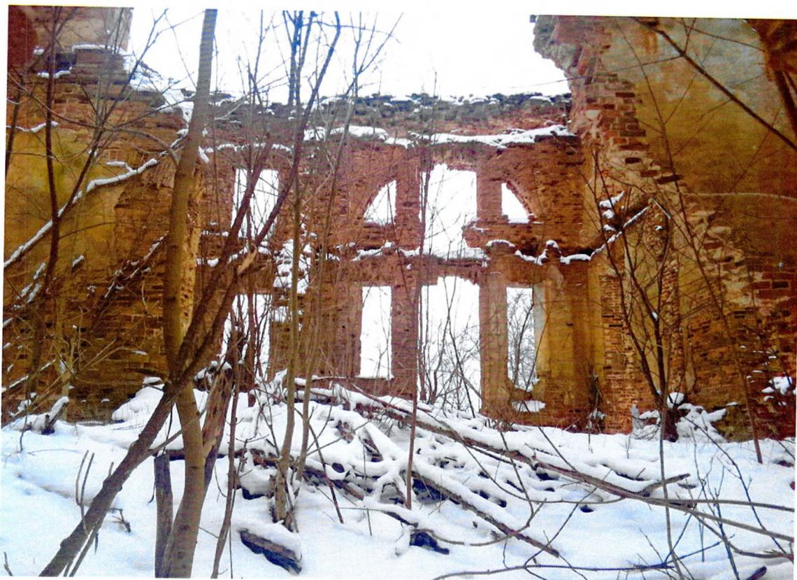
Фото 33. «Главный дом, нач. XIX». Общий вид внутренних помещений. Разрушение кирпичной кладки внутренних стен. Зарастание кустарником.
