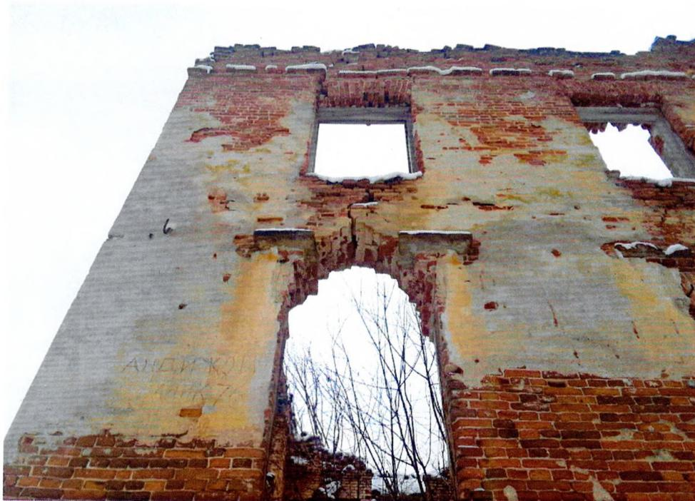
Фото 21. «Главный дом, нач. XIX». Фрагмент западного фасада. Разрушение штукатурного слоя стен. Сквозная трещина над оконным проемом первого этажа. Разрушение перемычки оконного проема первого этажа, разрушение сандрика.
