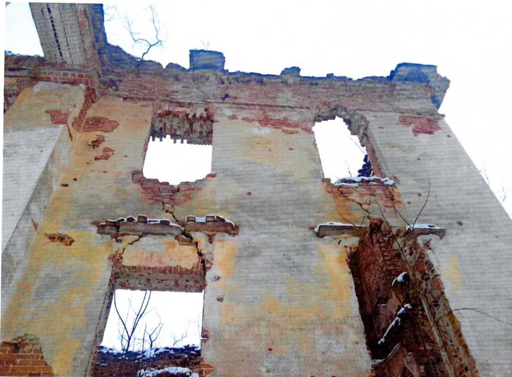
Фото 29. «Главный дом, нач. XIX». Фрагмент западного фасада. Наклонные сквозные трещина над оконными проемами первого этажа. Разрушение кирпичных перемычек, венчающего карниза и карнизных плит.
