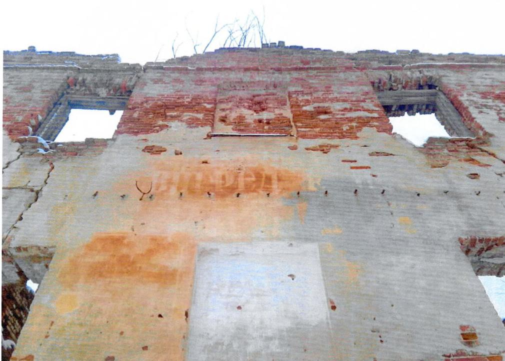
Фото 18. «Главный дом, нач. XIX». Фрагмент северного фасада. Часть оконных проемов заложены кирпичом. Разрушение кладки в уровне венчающего карниза. Прорастание растений.
