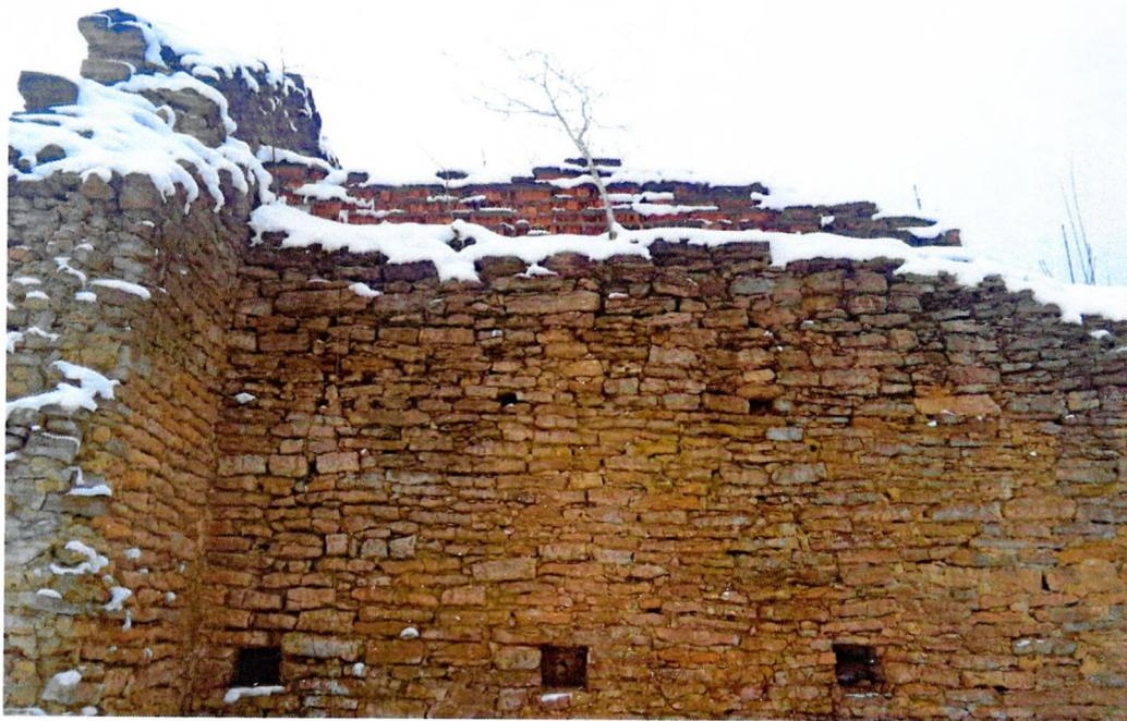
Фото 43. «Конюшня с каретником, нач. XIX в.». Фрагмент северного фасада. Прорастание кустарников в теле кладки. В верхней части участка стены выполнена поздняя кладка из керамического кирпича на цементно-песчаном растворе.
