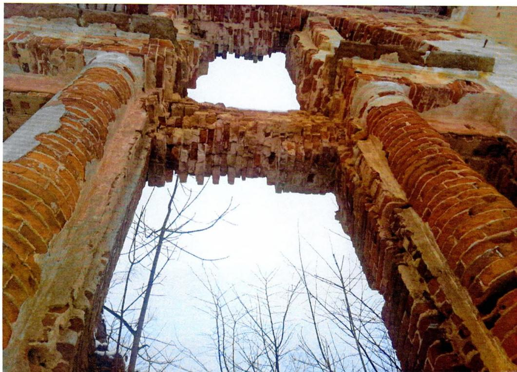
Фото 8. «Главный дом, нач. XIX». Фрагмент восточного фасада. Разрушение кирпичной перемычки, выпадение кирпичей.
