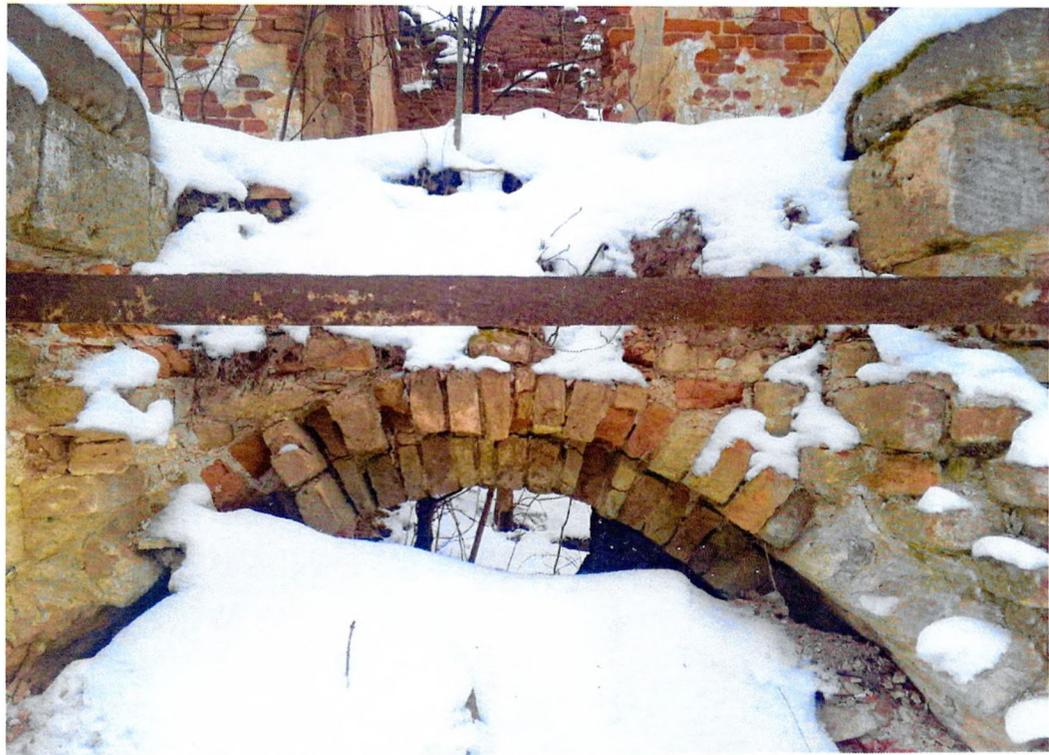
Фото 24. «Главный дом, нач. XIX». Фрагмент западного фасада. Коррозия металлических тяжей. Биоповреждение, расслоение кладки сводчатого перекрытия под стилобатом.
