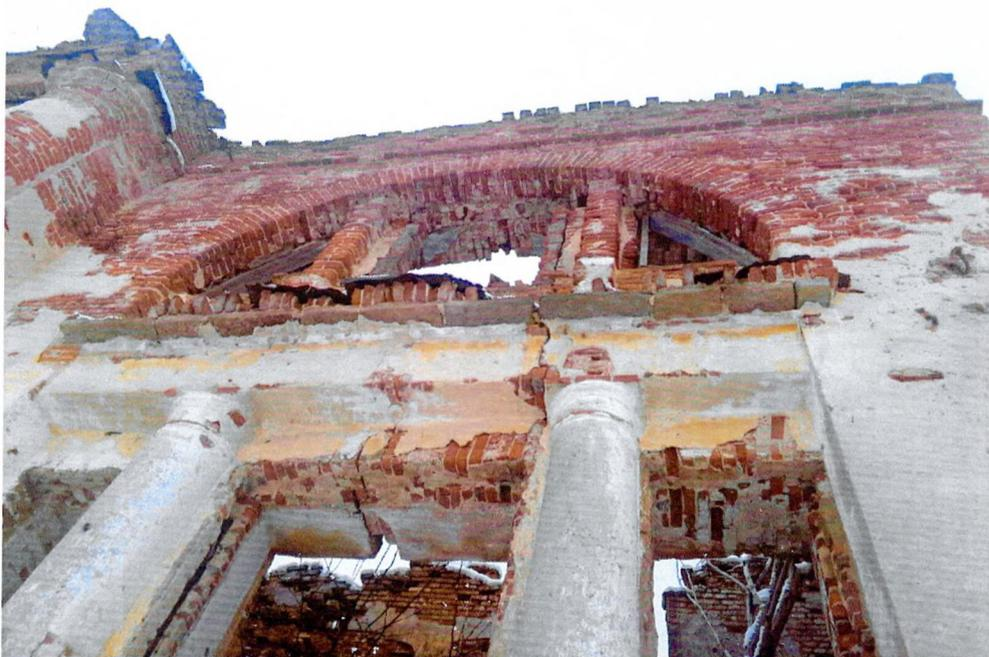
Фото 15. «Главный дом, нач. XIX». Фрагмент восточного фасада. Трещины в кирпичных перемычках на проемах первого этажа. Разрушение кладки арочной перемычки над трехчастным оконным проемом второго этажа, выпадение кирпичей. Выпадение кирпичей из венчающего карниза.
