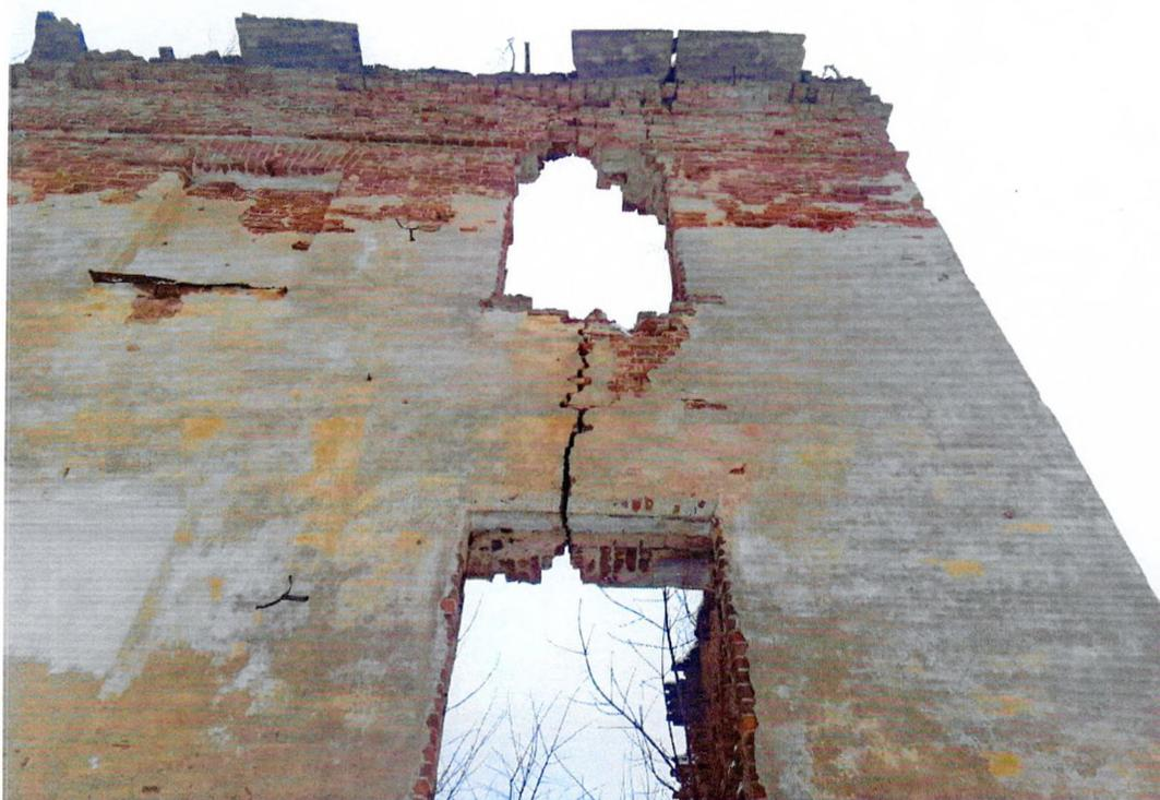
Фото 32. «Главный дом, нач. XIX». Фрагмент южного фасада. Вертикальная сквозная трещина над оконным проемом первого этажа.
