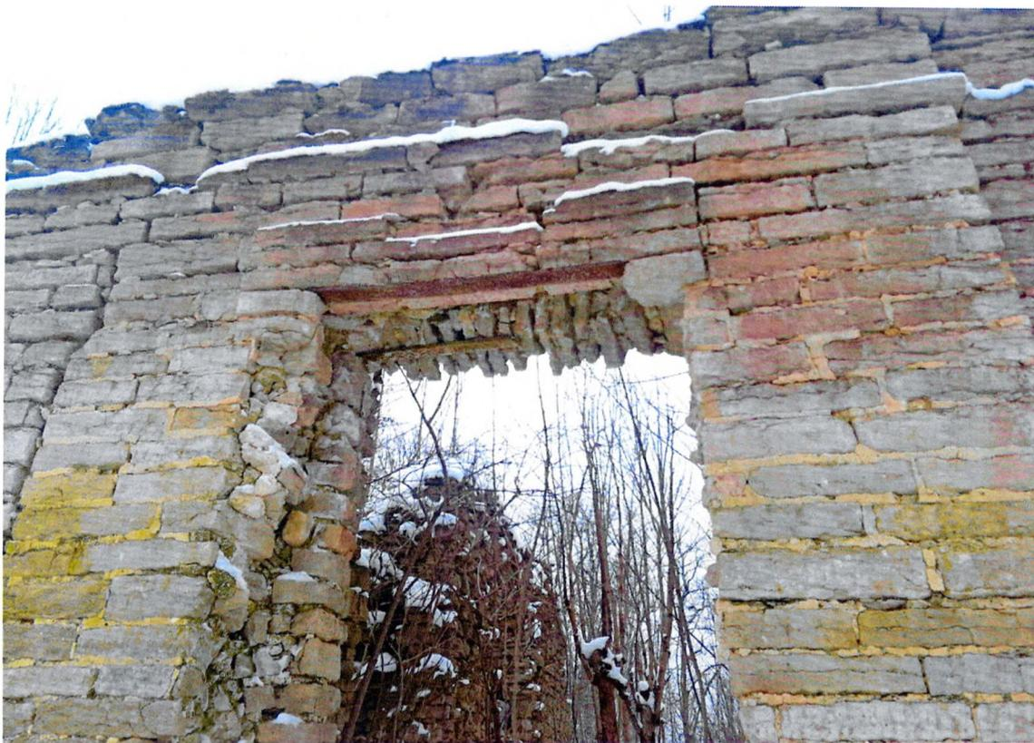
Фото 70. «Хозяйственный (кавалерийский) корпус, нач. XIXв.». Фрагмент северного фасада. Две перемычки оконных проемов усилены металлическими полосами.
