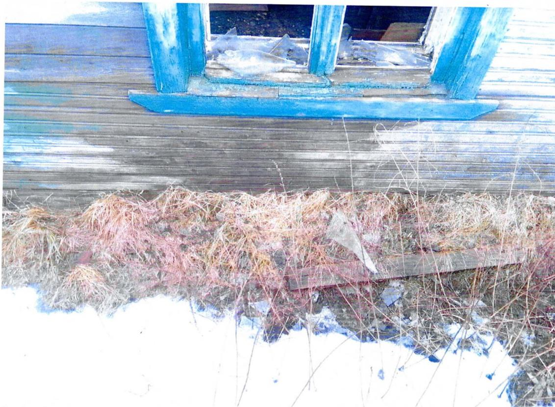
Фото 9. Фрагмент северного фасада. Увлажнение деревянной обшивки. Отсутствие отмостки, зарастание прилегающей территории.
