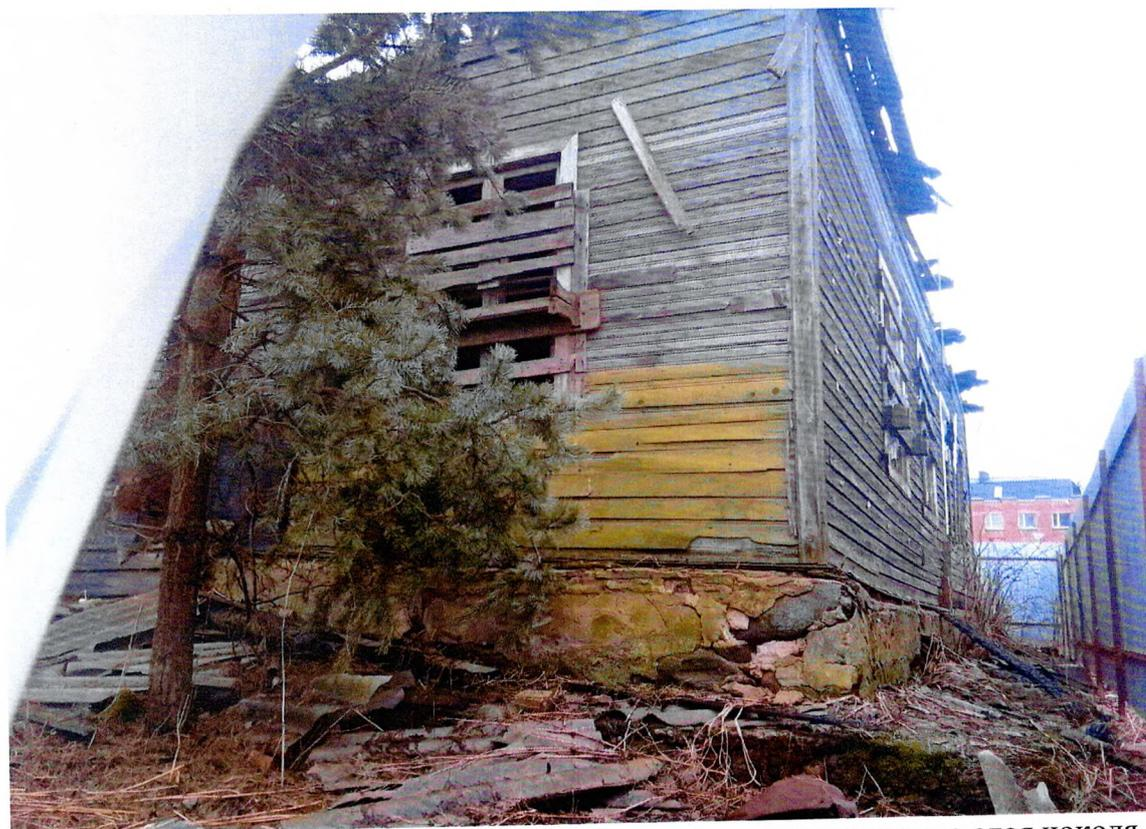
Фото 12. Фрагмент западного и южного фасадов. Разрушение штукатурного слоя цоколя, вывалы камня.
