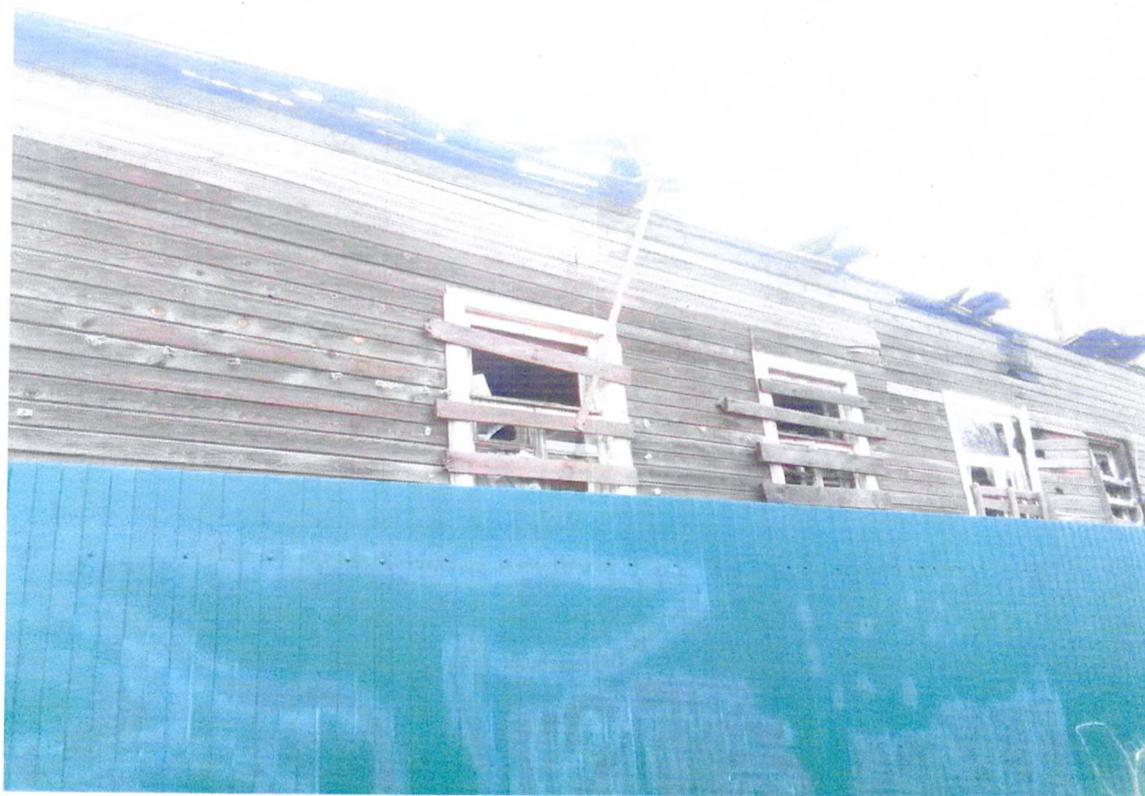
Фото 13. Фрагмент южного фасада. Утрата конструкций крыши. Отслоение отделочного обшивки стен, выпучивание конструкций обшивки. Утрата остекления оконных проемов, оконные заполнения защиты досками.
