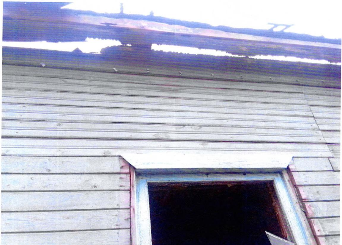
Фото 8. Фрагмент северного фасада. Утрата конструкций крыши и оконного заполнения.
