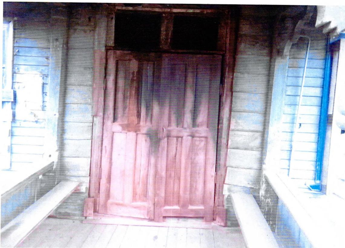
Фото 3. Фрагмент восточного фасада. Дверное полотно осело и имеет неплотный притвор по периметру коробки, дверные коробка перекошена, наличники повреждены.
