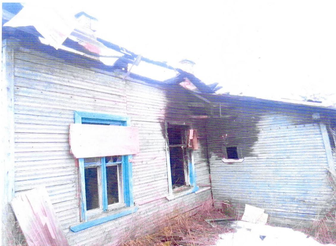
Фото 10. Фрагмент западного фасада. Утрата конструкций крыши. Обугливание стен здания и пристройки. Утраты остекления оконных проемов.
