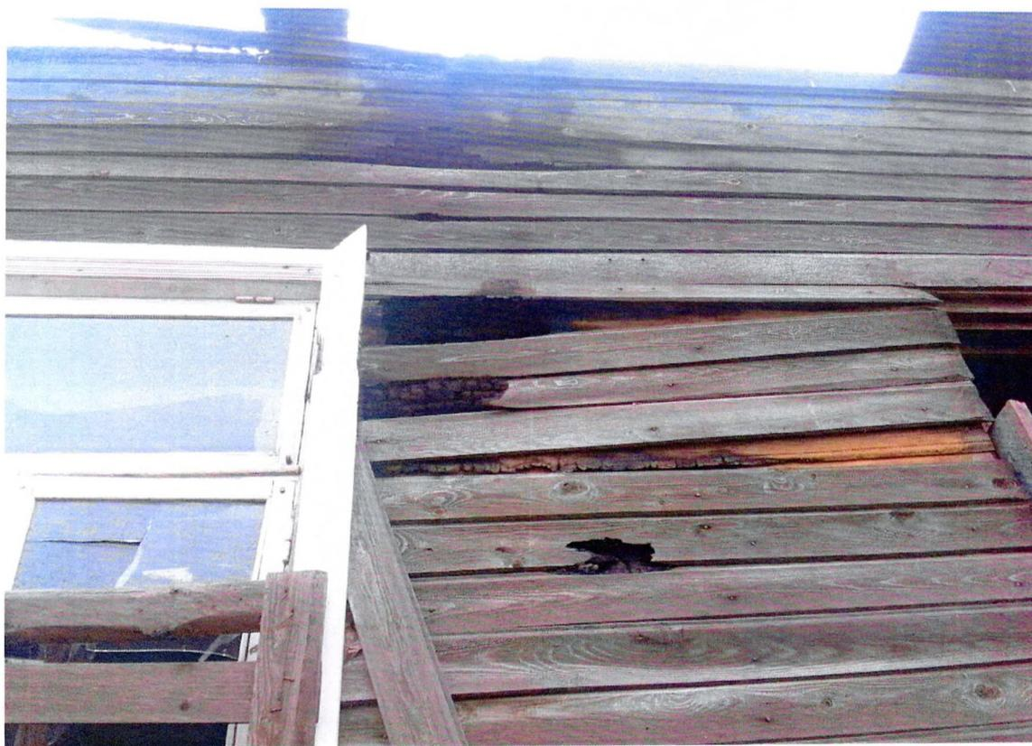
Фото 14. Фрагмент южного фасада. Разрушение конструкций обшивки, обугливание стен здания.
