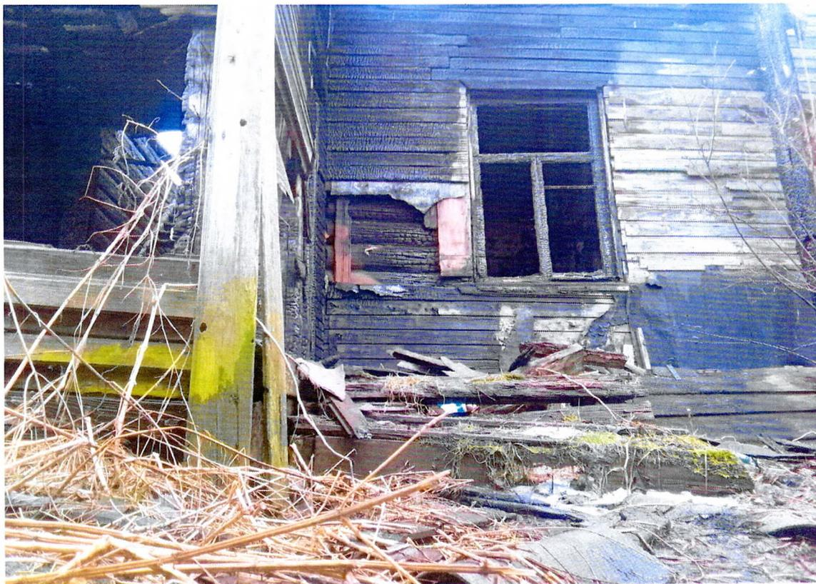
Фото 11. Фрагмент западного фасада. Обугливание стен здания. Утрата части пристройки.
