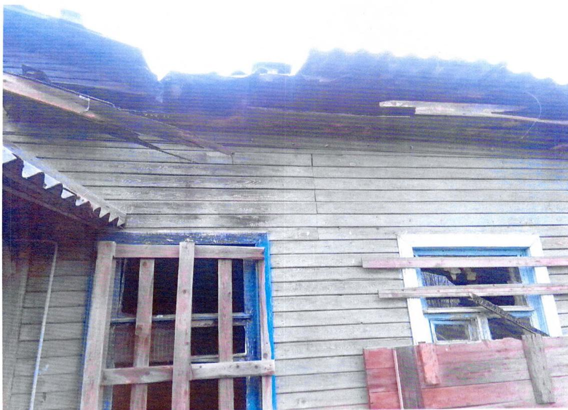
Фото 4. Фрагмент восточного фасада. Разрушение покрытия кровли и подшива карниза. Утраты остекления оконных проемов.
