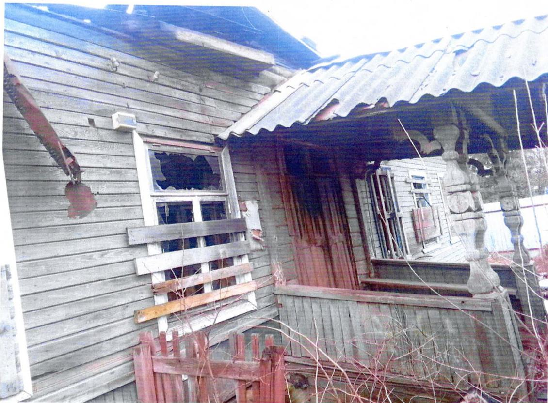
Фото 5. Фрагмент восточного фасада. Разрушение асбестоцементного покрытия козырька над входом в здание. Перекос конструкций крыльца.
